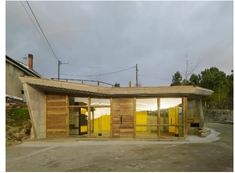
Vista general del proyecto. Fotografía por Héctor Santos-Diez, 2016. Fuente: https://www.archdaily.mx/mx/897156/refor-ma-del-centro-social
