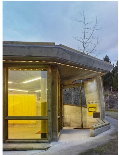
Vista a zona de espera exterior. Fotografía por Héctor Santos-Diez, 2016. Fuente: https://www.archdaily.mx/mx/897156/refor-ma-del-centro-social
