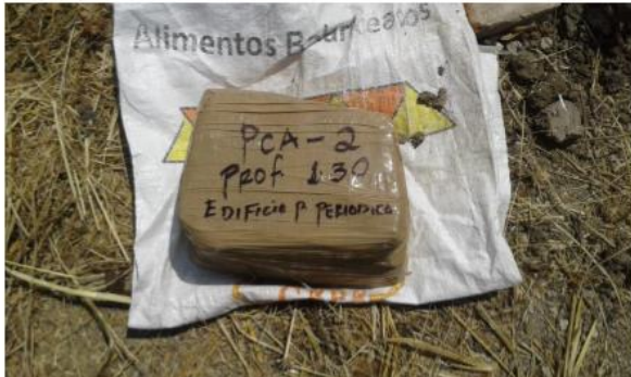
Recuperación de muestra inalterada del subsuelo en el sondeo tipo pozo a cielo abierto (PCA- 02)
