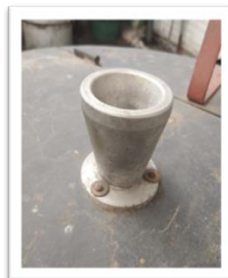
Imagen 17 Detalle del vertedero
