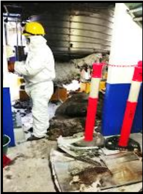
Ilustración 45 Desmantelamiento con equipo de protección personal.
