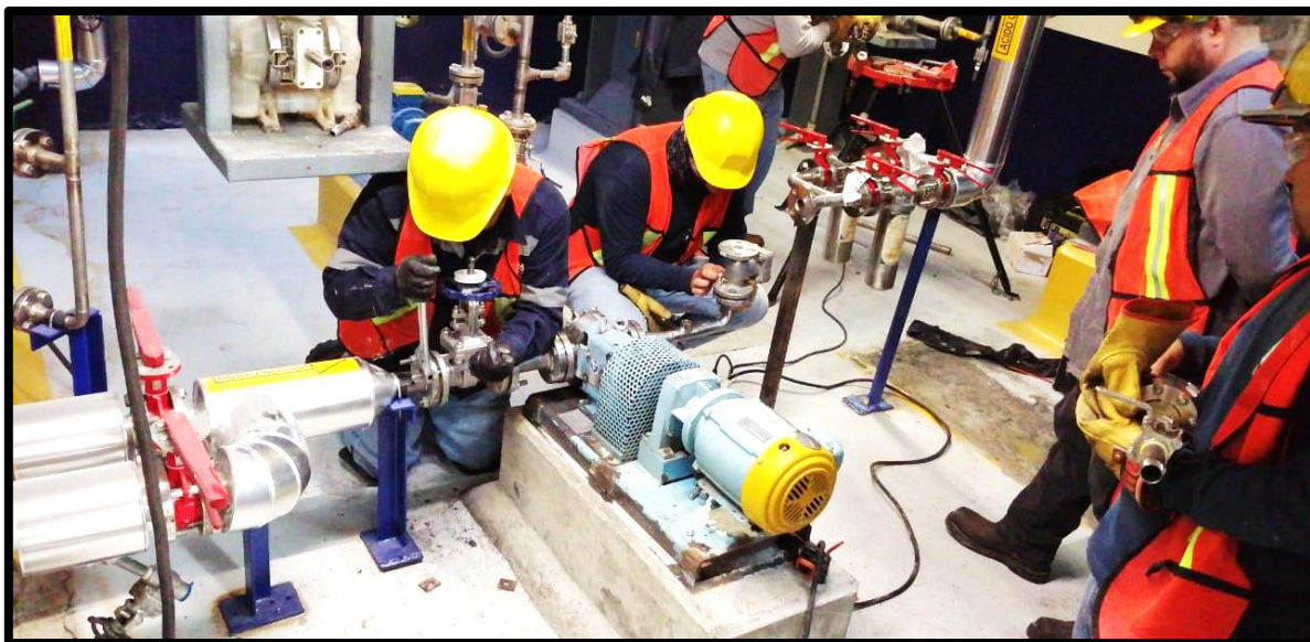
Ilustración 62 Reubicación de bomba
