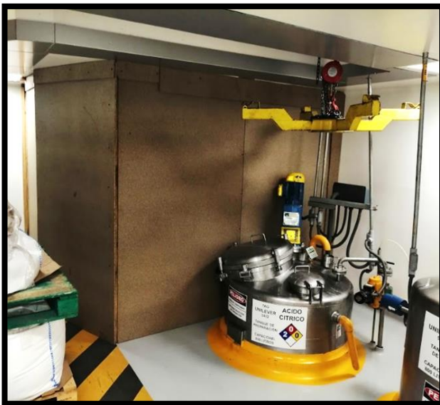
Ilustración 42 Tapial de madera (vista externa) colocado en cuarto de preparación.
