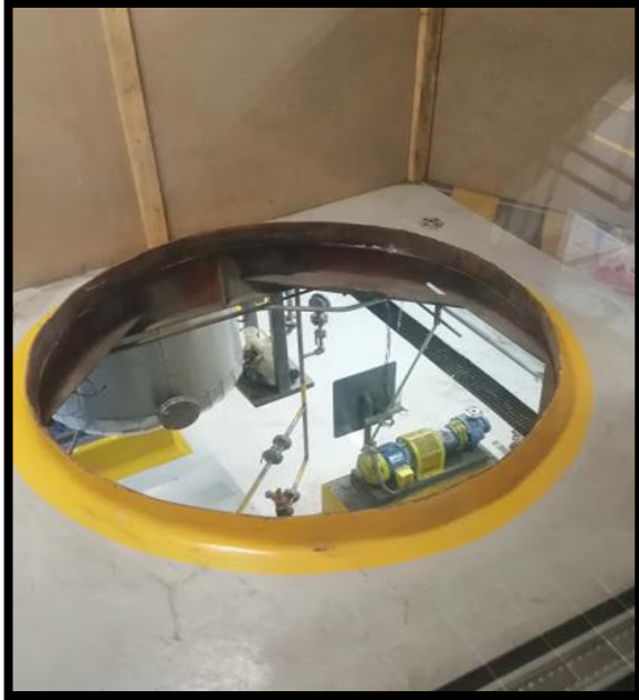
Ilustración 46 Agujero al dismantelar tanque.
