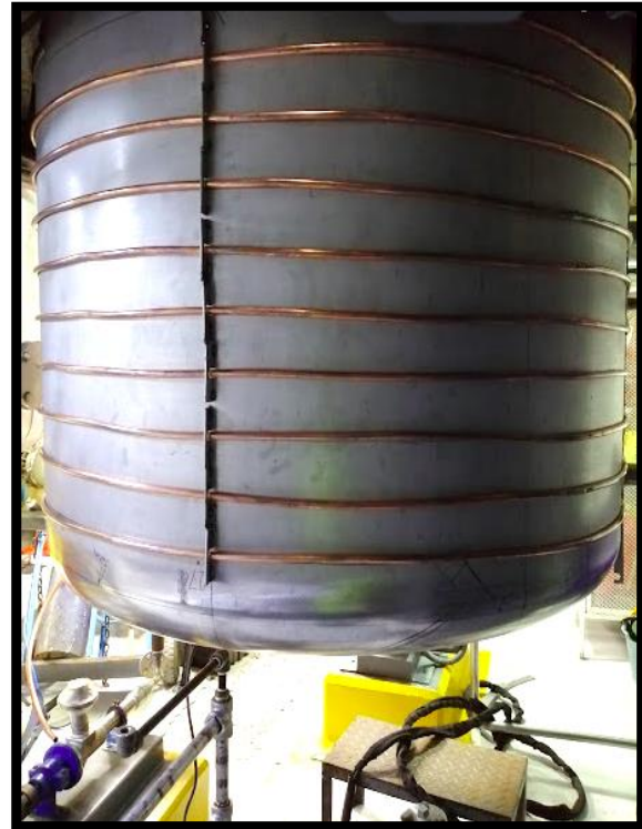
Ilustración 55 Colocación de traza de vapor
