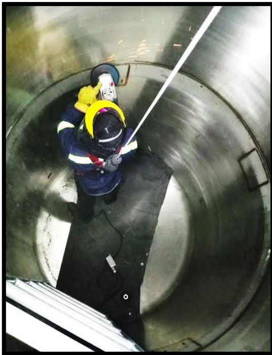
Ilustración 52 Pulido de unión posterior a la soldadura de secciones.
