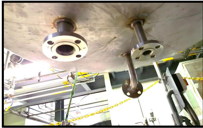
Ilustración 51 Boquillas soldadas a nuevo tanque
