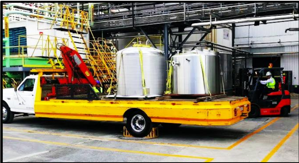
Ilustración 50 Llegada de nuevo tanque a planta. 4,500 [lts]
