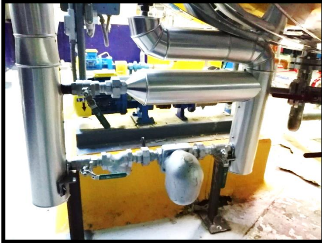
Ilustración 58 Instalación de tubería de condensado
