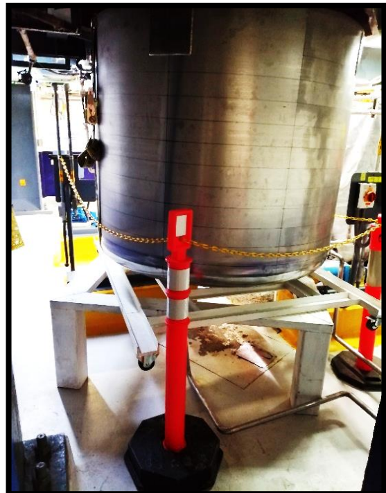
Ilustración 53 Mitad inferior del tanque montada durante su instalación
