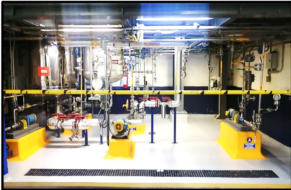
Ilustración 69 Cuarto inferior posterior a las reparaciones
