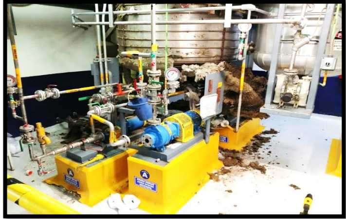
Ilustración 44 Desmantelamiento de enchaquetado de tanque.
