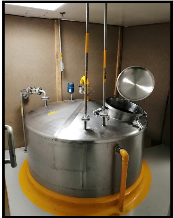
Ilustración 41 Tapial de madera (vista interna) colocado en cuarto de preparación.
