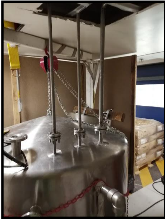
Ilustración 54 Instalación superior de nuevo tanque con boquillas y tuberías.
