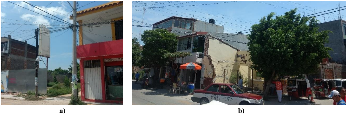
Figura 2.3 Ejemplos de negocios que sufrieron interrupción definitiva a causa de un colapso total del edificio durante el sismo de Chiapas de 2017: a) comedor; b) pollería
