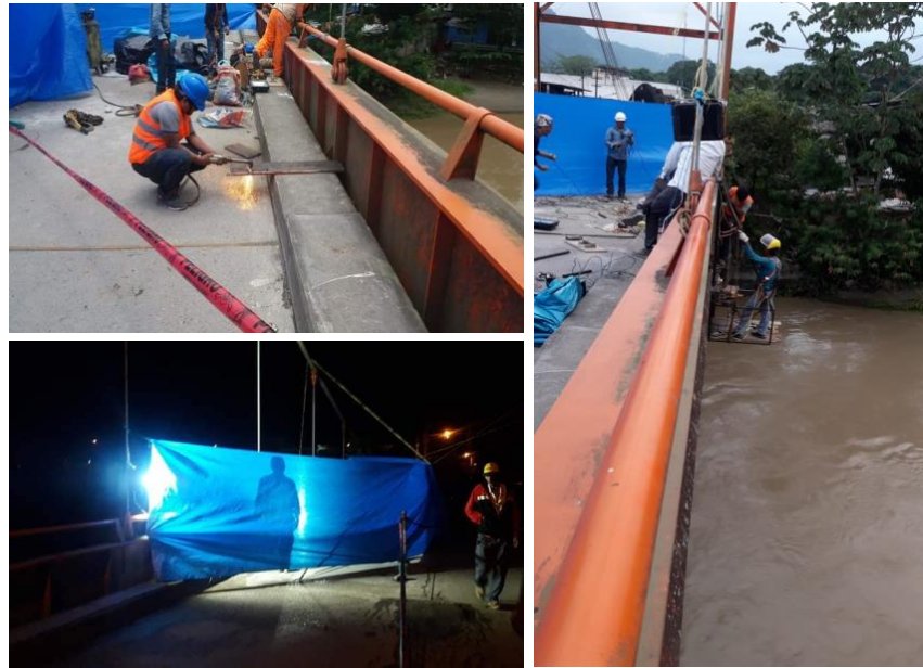
Figura 7 Ejecución de actividades para la reparación de fracturas en las uniones y grietas del puente Corpac. Fuente: De autores (2020)
