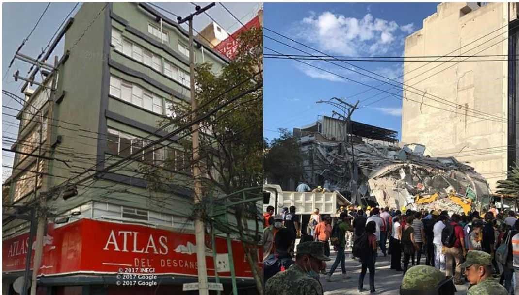
Figura 1. Ejemplo de pérdida total: Edificio de San Luis Potosí y Medellín en la Colonia Roma: A) Antes del sismo del 19S de 2017 y B) Colapso tras el sismo del 19S de 2017. Fuente: Ana Lagos (Usuaría de Twitter) y Google Maps
