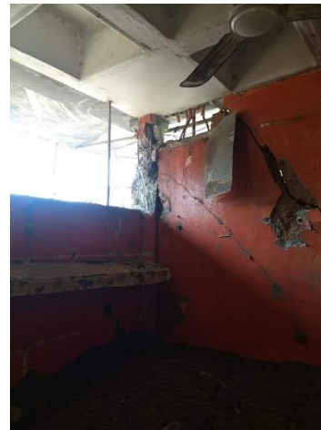
Figura 5.4 Daños no estructurales en el mercado de Juchitán: a) desprendimiento de acabados y rotura de ventanas; b) agrietamiento por cortante en muro no estructural
