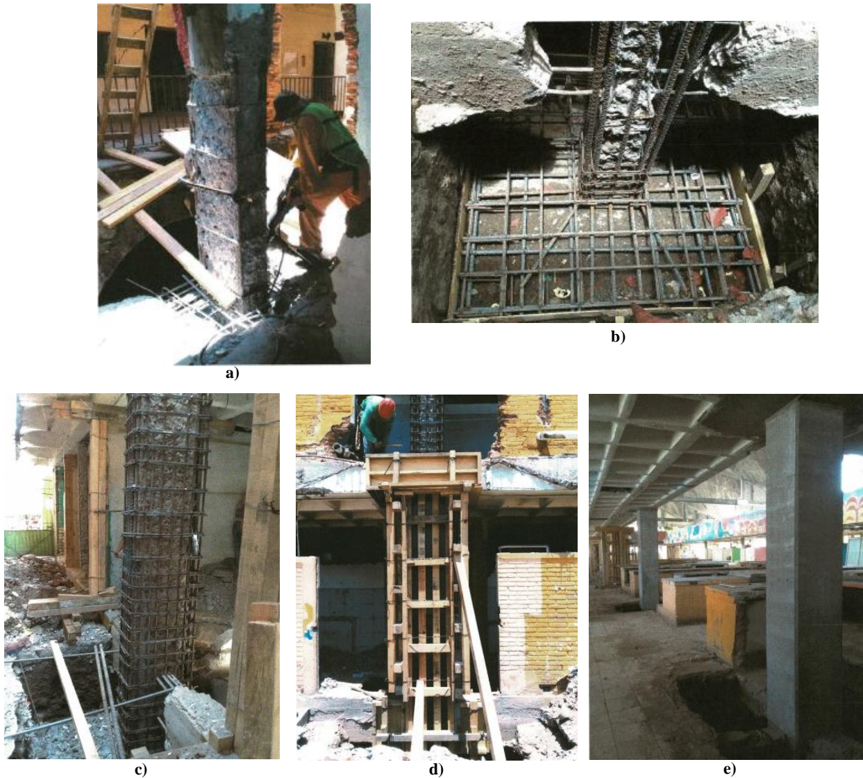
Figura 5.5 Etapas del proceso constructivo para el encamisado de las columnas del edificio del mercado de Juchitán: a) escarificado; b) habilitado y armado de acero para la nueva zapata; c) habilitado y armado de acero para la columna; d) cimbrado; e) colado
