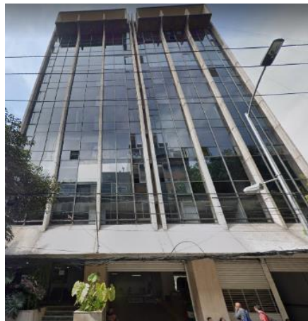
Figura 3.6 Aunque el edificio no experimentó daños, la sociedad civil tuvo que cerrar por 30 días debido al colapso de un edificio vecino. Fuente: Google
