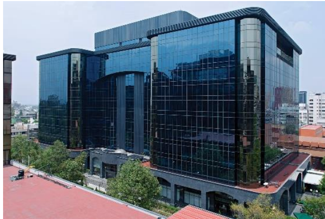
Figura 3.9 El personal de unas oficinas situadas en un edificio de Polanco no pudo laborar por 4 días a causa de las complicaciones para trasladarse al inmueble. Fuente: Google
