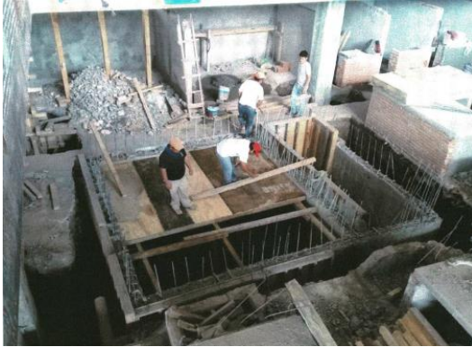
Figura 5.6 Cimbrado de la losa superior de la cisterna y del cuarto de máquinas
