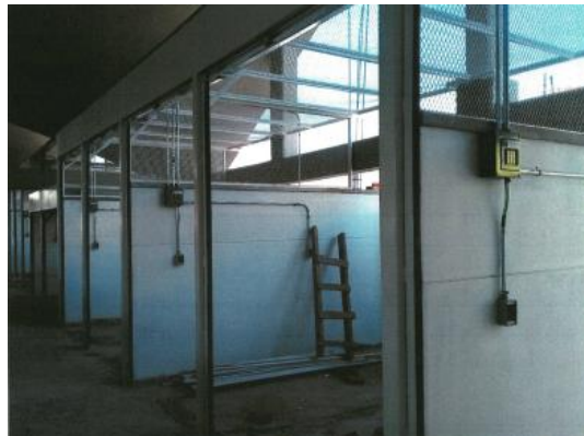
Figura 5.8 Actividades para la reconstrucción de los locales: a) construcción de muros divisorios; b) trabajos de herrería; c) instalación eléctrica
