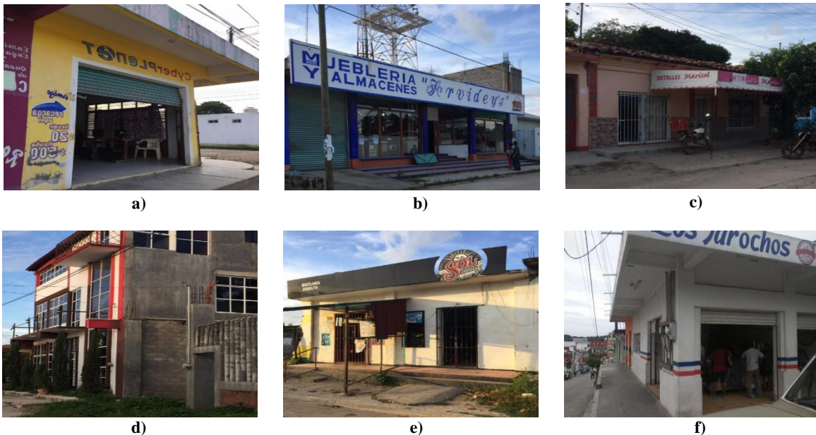
Figura 4.4 Algunos establecimientos de Oaxaca que detuvieron sus operaciones tras el sismo de Mw8.2 de Chiapas (tipo de negocio - razón de cierre): a) ciber café - corte de energía eléctrica; b) mueblería - daños no estructurales en el edificio; c) tienda de regalos - falta de clientes; d) gimnasio - daños estructurales en el edificio; e) miscelánea - problemas personales del dueño; f) carnicería - daños a un edificio vecino; g) veterinaria - desorden en los contenidos; h) estética - incertidumbre debido a réplicas
