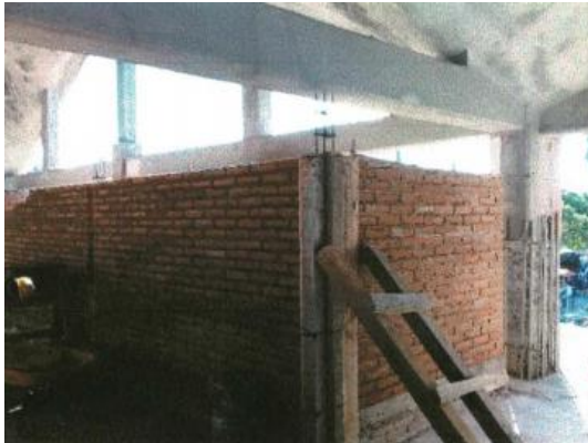
Figura 5.6 Cimbrado de la losa superior de la cisterna y del cuarto de máquinas
