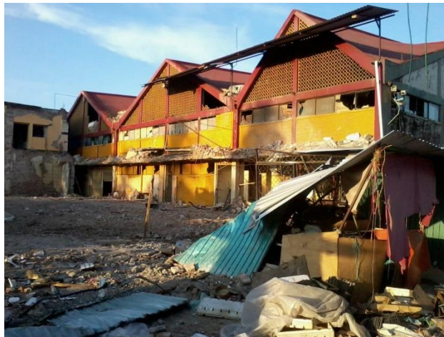
Figura 5.4 Daños no estructurales en el mercado de Juchitán: a) desprendimiento de acabados y rotura de ventanas; b) agrietamiento por cortante en muro no estructural
