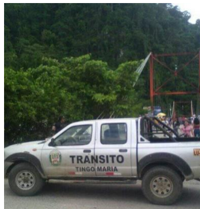
Figura 3 Restricción del paso vehicular en el puente. Fuente: Usuario de redes sociales
