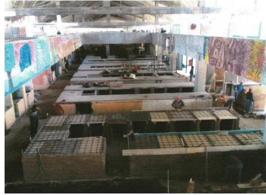
Figura 5.7 Construcción de barras para mesas de los negocios
