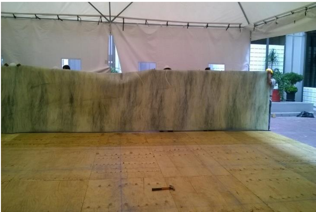
Imagen 26. Aplicación de una cobertura de vinil sobre la base, esto con el objetivo de proteger la madera de humedad y facilitar la limpieza del área.
