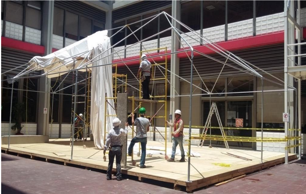
Imagen 25. Montado de estructura para carpa sobre base de madera. Para su armado utilizamos algunas herramientas específicas, proporcionadas por el fabricante de la misma, y andamios ya que tiene una altura de 5 metros
