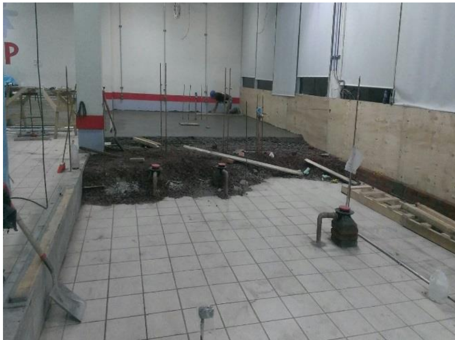
Imagen 35. Colado de piso para cocina provisional, se observan las instalaciones hidráulicas que van dentro del mismo, cadenas perimetrales que han sido coladas previamente las cuales cuentan con armado anclado a losa para su fijación.
