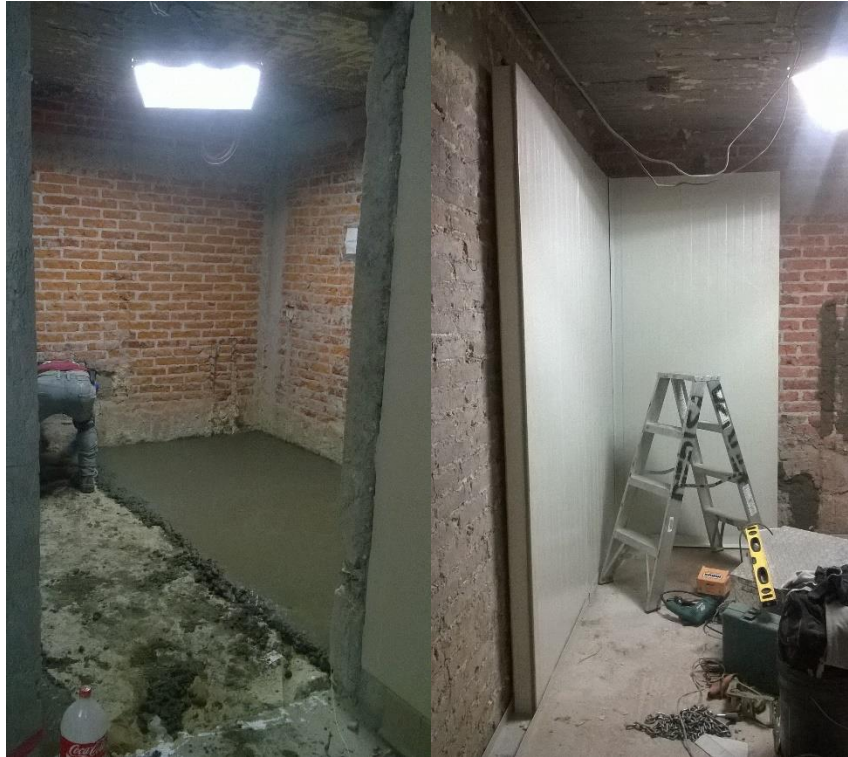
Imagen 61 y 62. Cámara Fría. En la imagen de la izquierda vemos la elaboración de piso firme de concreto. La imagen de la derecha muestra el tipo de panel con el que es forrado el cuarto, anteriormente el aislamiento térmico formaba parte del muro de concreto.
