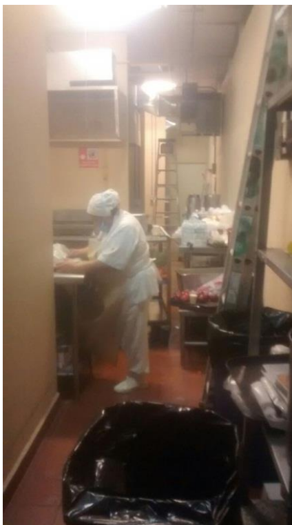
Parte del equipo de cocina: marmitas, equipos de cocción, losas, charolas, son trasladados a la cocina provisional, en cuanto esta queda lista se procede al desmantelamiento de dicho equipo en la cocina actual para su traslado e instalación inmediata.
