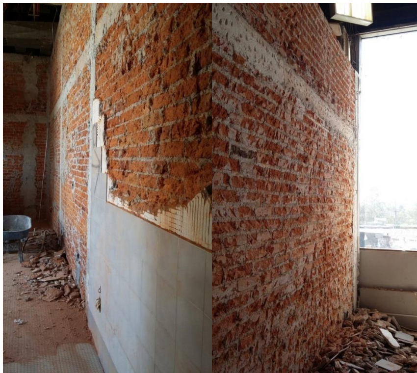
Imagen 43. Demolición de acabados en muros, azulejos. Dejamos los muros con acabado aparente para la colocación de la nueva cubierta.
