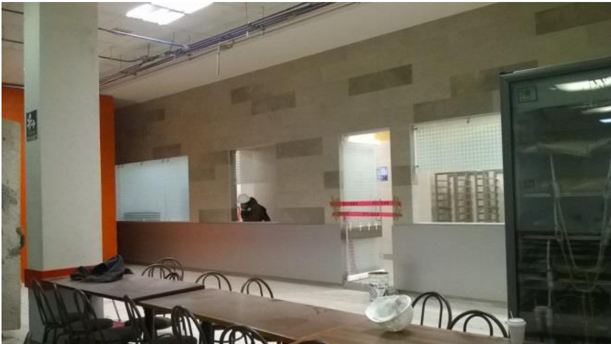
Imagen 76. Muro con acabados cerámicos en proceso, las boquillas se encuentran preparadas para recibir cristales y cancelos que ya se encuentran sobre puestos.
