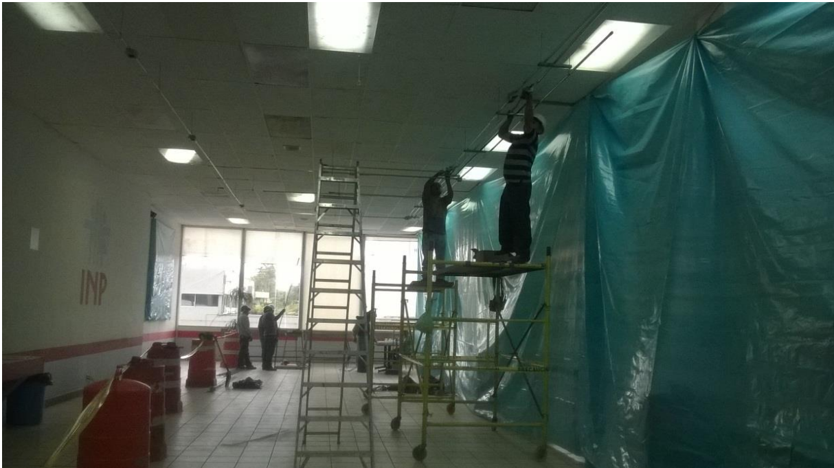
Imagen 33. Trabajos de instalación eléctrica previos a la adecuación de la cocina provisional, colocación de soportaría y tubería.
