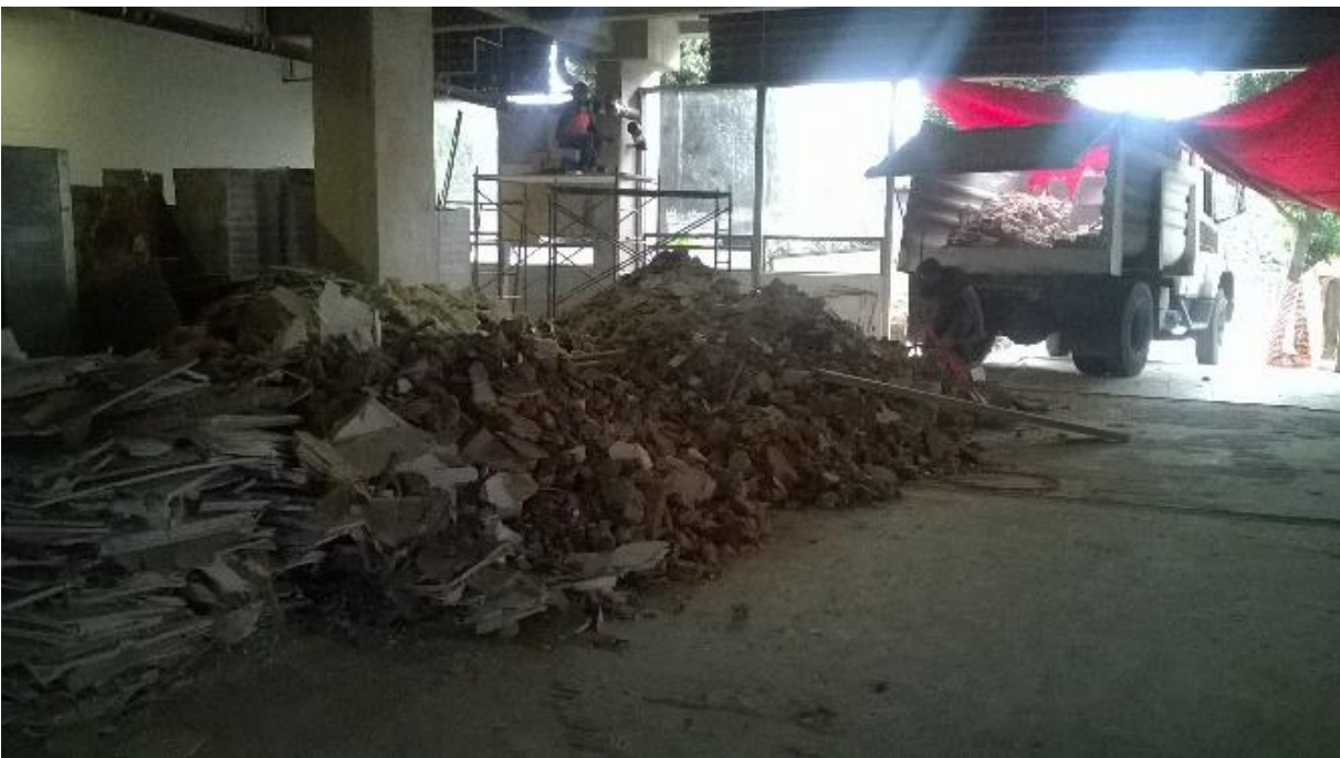
Imagen 55. Retiro de escombro de torre de oncología, espacio asignado por el instituto para nuestros desechos.
