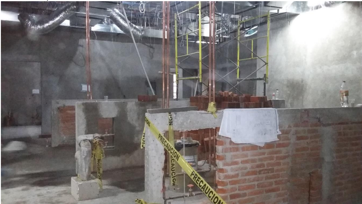
Imagen 60. Muros bajos en la zona de cocción terminados sin acabados con instalaciones hidráulicas en proceso, al fondo muros con repellado listos para la colocación de loseta cerámica.
