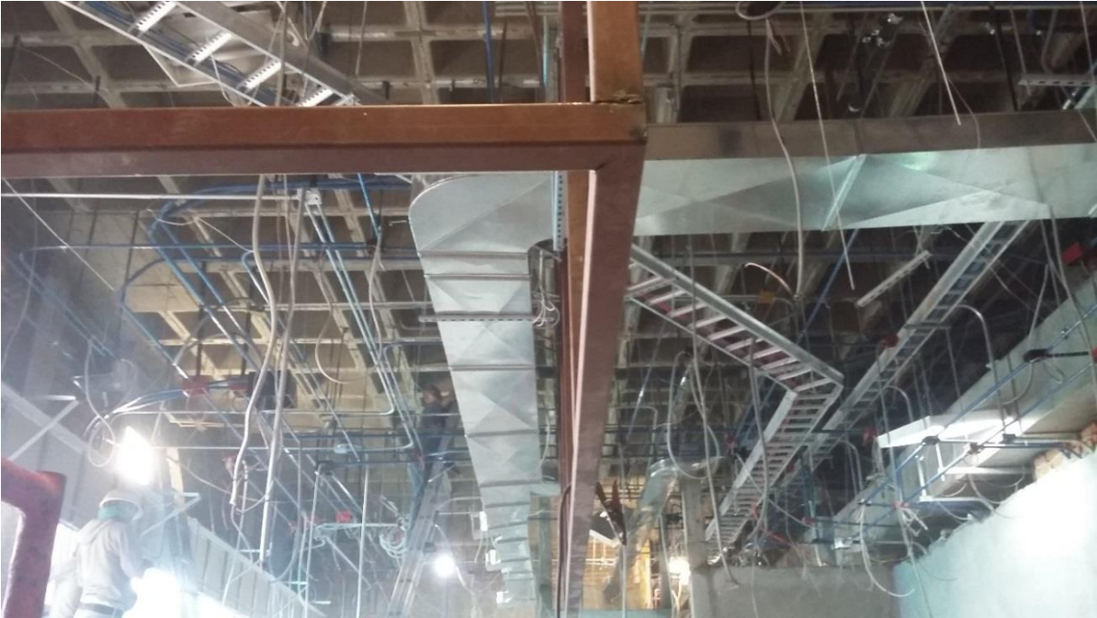
Imagen 74. Bastidor de perfil cuadrado de acero, soldado con placas metálicas a estructura de losa. Es utilizado para fijar la cancelería.
