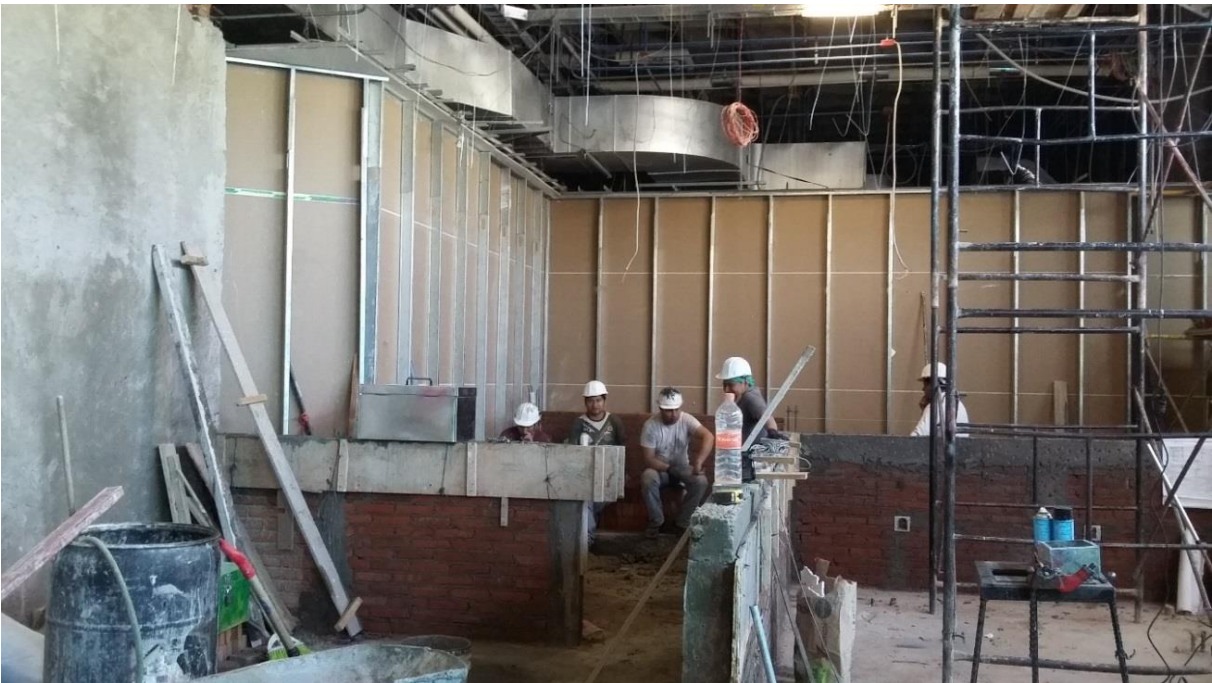
Imagen 71. Colado de cadenas en muros bajos con instalaciones eléctricas ya preparadas. Posteriormente se recubren de aplanado fino y pintura vinílica, sobre estos se instala la cancelería.
