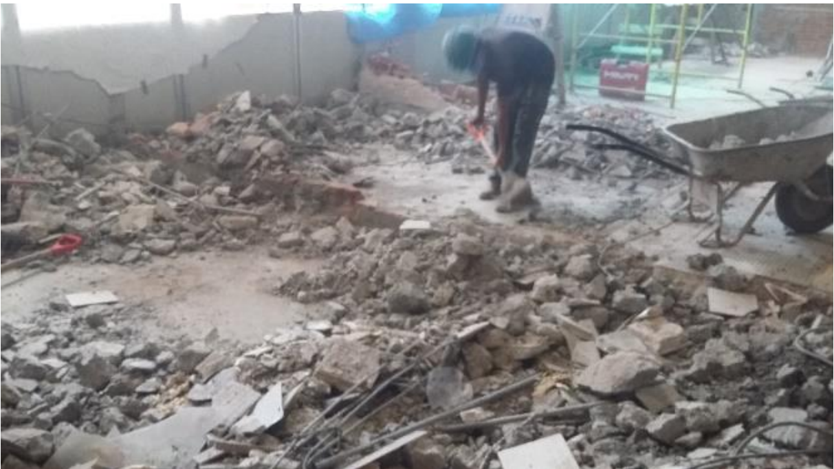
Imagen 53. Finalización de demolición manual de cadenas de concreto y acarreo de escombro es llevado a la planta baja de la torre de oncología del instituto.
