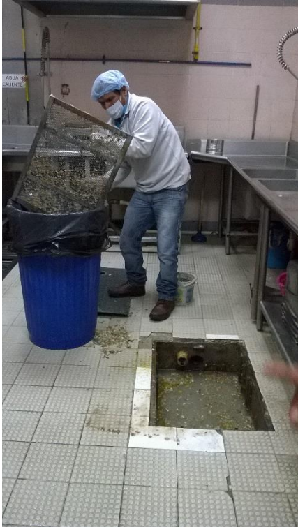
Imagen 15. Fotografía tomada en el área de cocción, uno de nuestros trabajadores se encuentra limpiando la trampa de grasas. Los cocineros reportan que le tienen que dar mantenimiento constante para que no se desborde.
