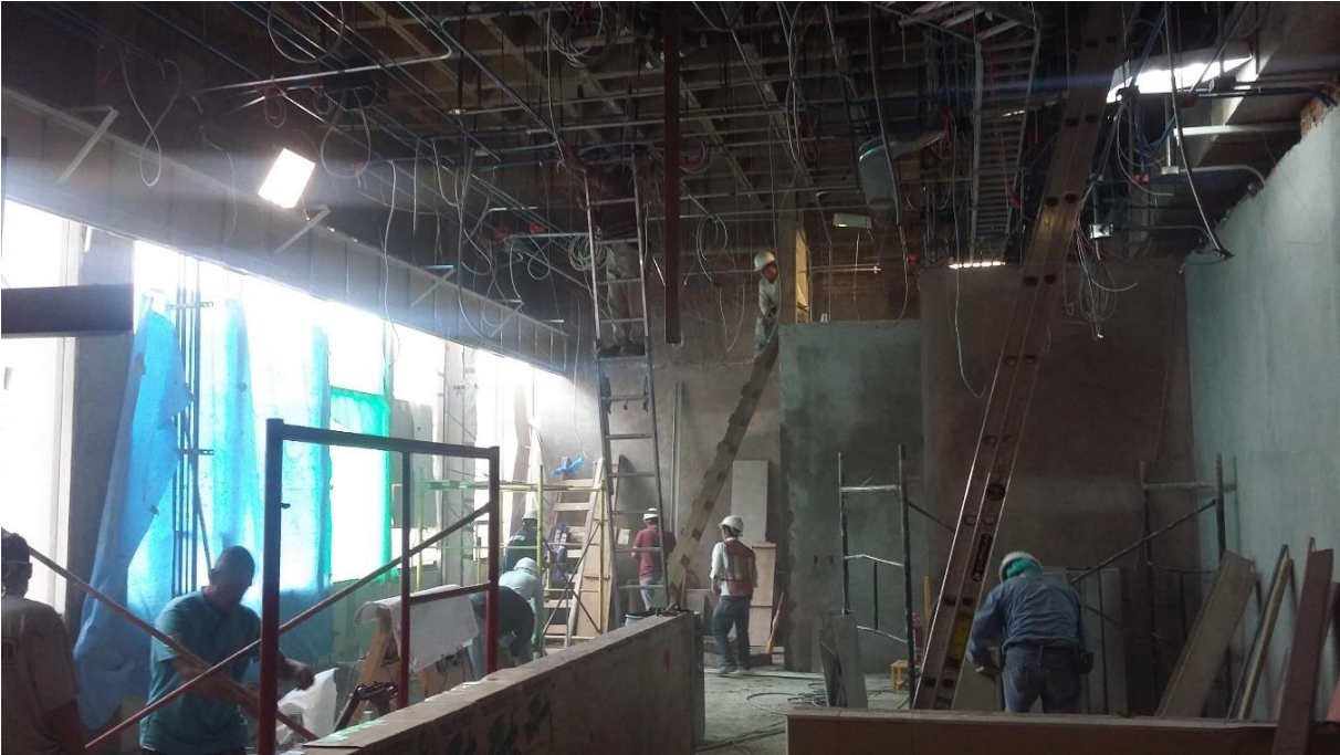
Imagen 72. Muros con aplanados terminados. Al mismo tiempo se realizan trabajos de soportaría, colocación de charolas tipo escalera.
