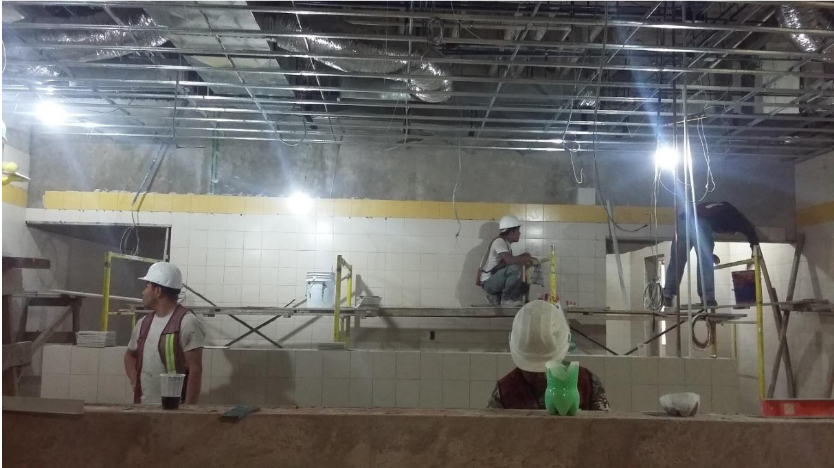
Imagen 64. Colocación de loseta cerámica en muros, y terminado de soportaría para el plafón de tabla roca.
