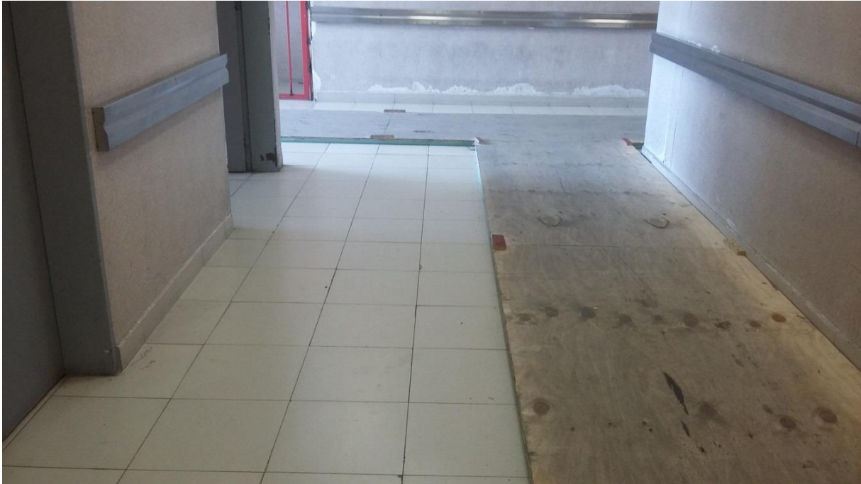
Imagen 29. Pasillos protegidos con bajo alfombra y triplay. Únicamente sobre estos podemos trasladar nuestro material.
