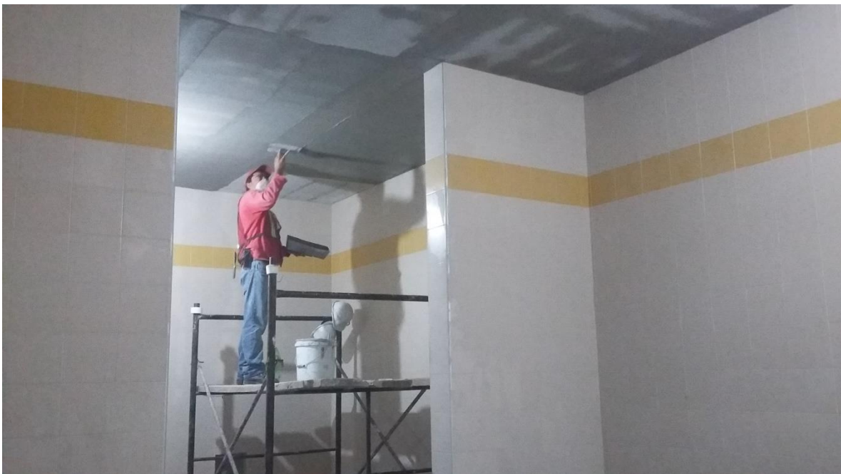
Imagen 65. Finalizando el tratamiento de tabla roca en plafones, posteriormente se recubre con pintura vinílica.
