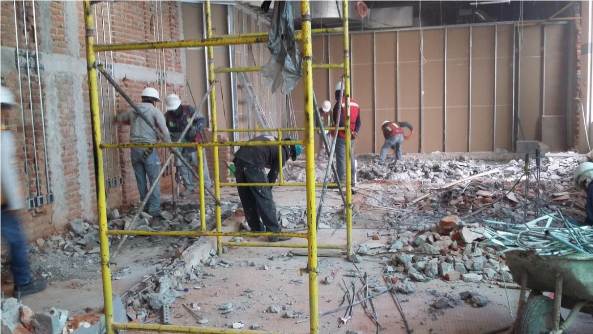
Imagen 54. Culminación de demoliciones de muros, cerramientos y acabados en cocina.
