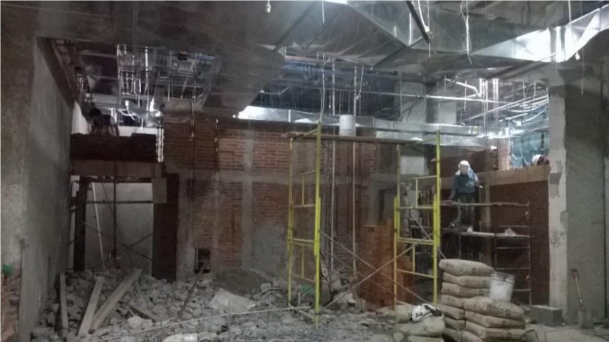
Imagen 52. Demolición de acabados en muros y algunos cerramientos de tabique, al igual que cadenas y castillos de concreto. En la imagen también observamos la instalación de aire acondicionado la cual se va desmontando cuidadosamente una vez que se ha cerrado la inyección y extracción de aire en esta zona, es un trabajo muy delicado por ser un hospital.
