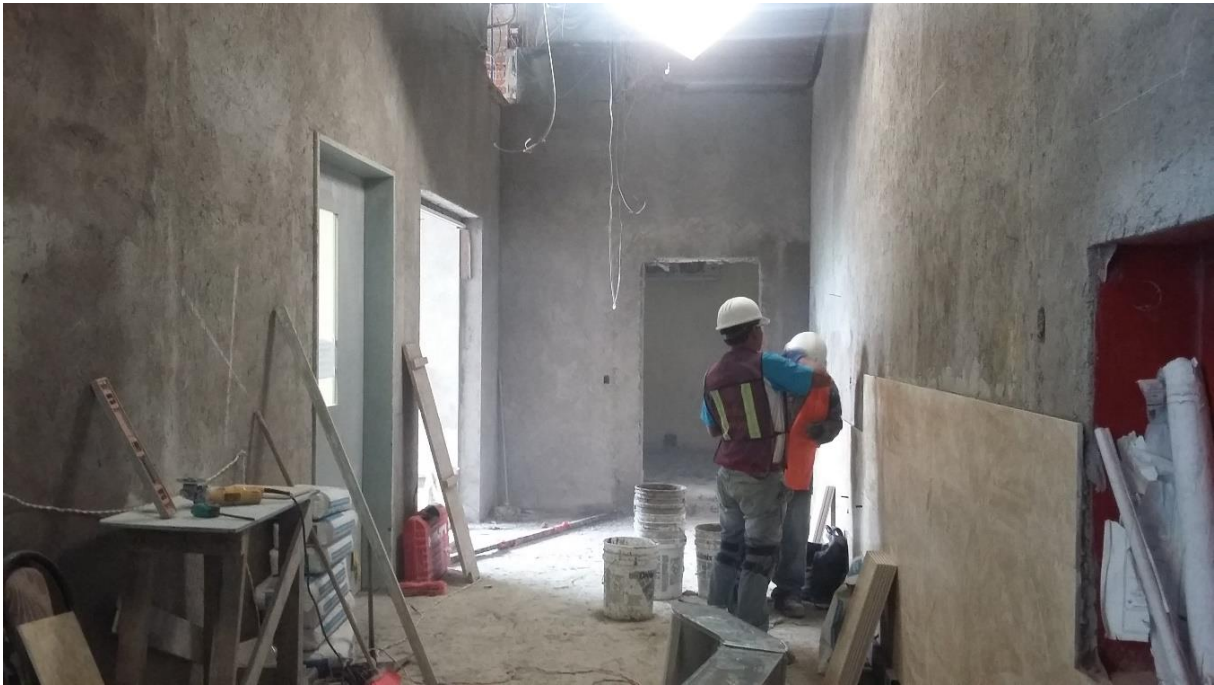
Imagen 78. Colocación de loseta cerámica en muros hacia escaleras
