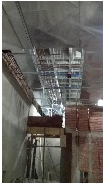
Imagen 58. Colado de cadenas en muros, se observan también las ranuras en el muro para el paso de instalaciones hidráulicas.
