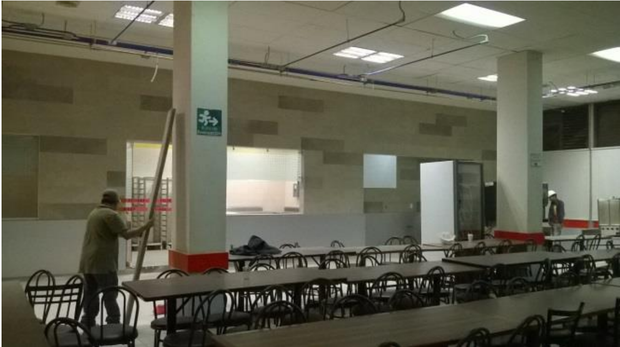
Imagen 77. Tubería eléctrica y luminarias listas para la colocación del plafón. También podemos observar algunos equipos que se llevan al área para corroborar que quepan, aunque todo esté especificado en la guía mecánica.
