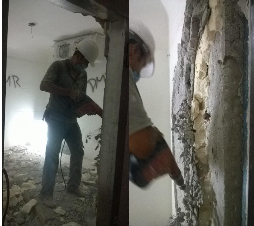
Imagen 44. Demolición de acabados en muro de cámara fría con ayuda de rotomartillo, podemos observar el aislante térmico utilizado.
