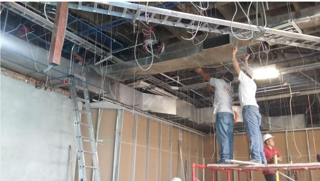
Imagen 73. Instalación de conductos, fabricados con lámina galvanizada, para extracción e inyección de aire.
