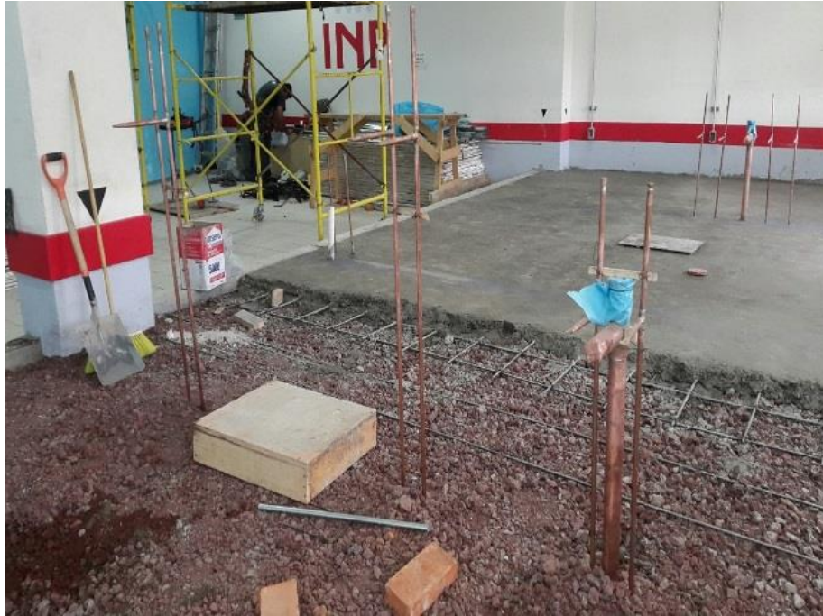
Imagen 36. Relleno y colado de plataforma. Podemos observar el tezontle que es utilizado como relleno, seguido de una malla de acero electrosoldada finalizando con el concreto. Las cajas de madera protegen las salidas de aguas negras.
