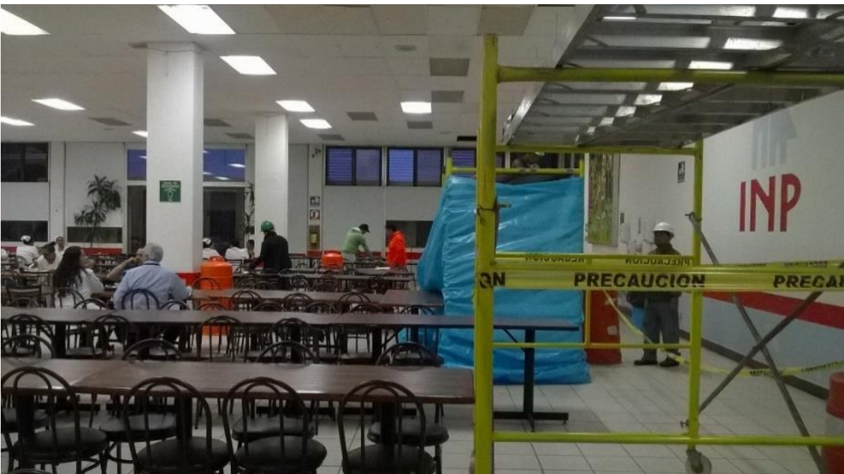
Imagen 18. Fotografía de comedor. Observamos el tipo y acomodo de mobiliario. Los diversos acabados y colores de piso, muros, columnas, plafones, varias luminarias sin funcionar y andamios colocados por nuestro equipo de trabajo para iniciar con la remodelación del mismo.
