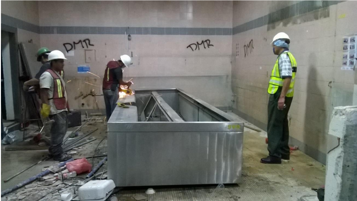
Imagen 42. Desmantelamiento de equipo de cocina y de cámara fría. Algunos son reutilizados en la cocina provisional, mientras otros son resguardados por el instituto. Utilizamos herramienta común y en algunos casos fue necesario desoldar o romper, tratando de no maltratar en la manera posible los equipos.
