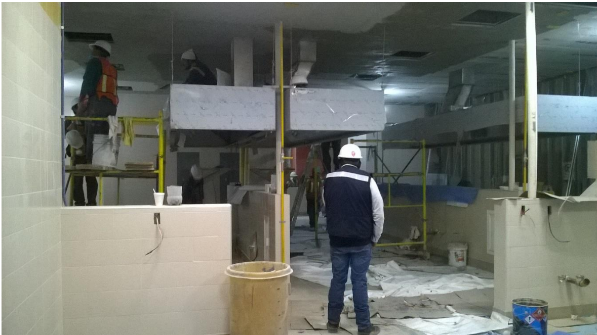
Imagen 67. Colocación de equipos en zona de cocción, campanas de extracción fabricadas con lámina de acero inoxidable. Y aplicación de pintura en plafones.
