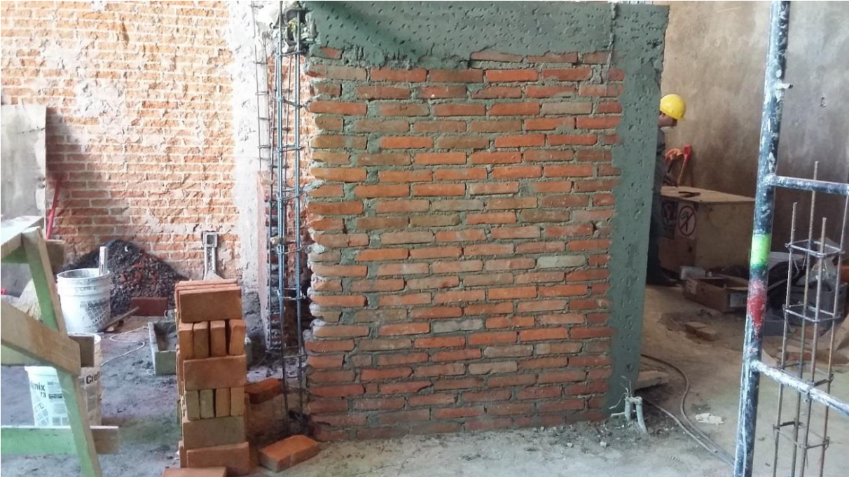
Imagen 70. Armado de muros de tabique rojo y castillos de varilla del número tres con estribos a cada veinte centímetros anclados a losa.
