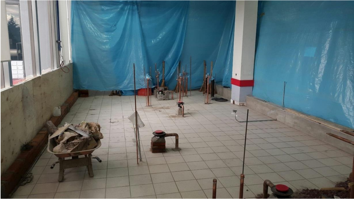
Imagen 34. Trabajos de instalación hidráulica y sanitaria en cocina provisional, armado de cadenas perimetrales y protección a cancelería existente.
