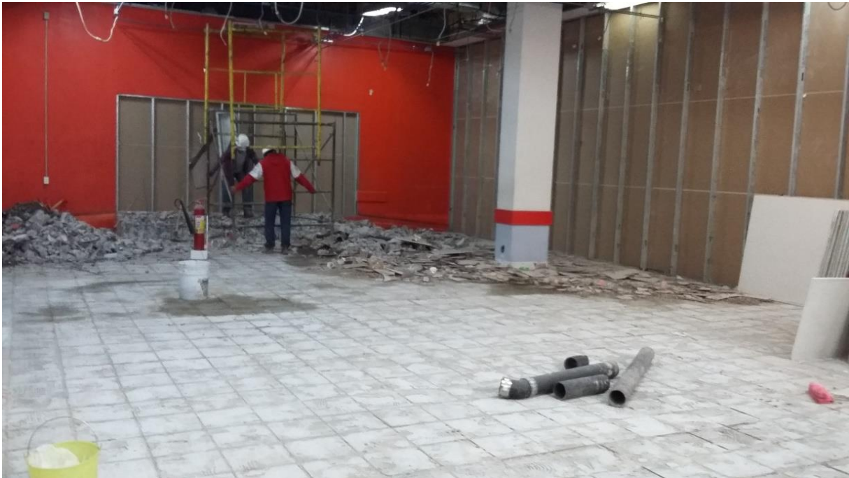
Imagen 50. Demolición de muretes y tubería de aguas residuales que pasan por la zona del comedor, para realizar los trabajos a ciertas alturas se auxilian de andamios.
