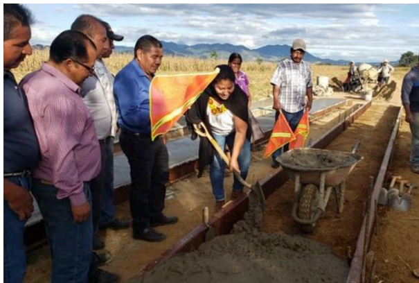
La presidenta municipal María de Jesús Saveche dando el banderazo de salida a las obras de pavimentación del camino de Santa Inés a Santiago Apóstol. Fotografía Ayuntamiento de Santa Inés Yatzeche.
