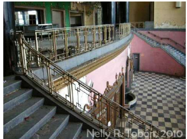
10. Vista desde escalinatas a vestíbulo y
