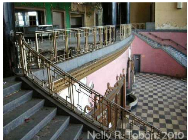
10. Vista desde escalinatas a vestíbulo y
