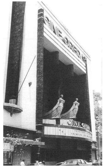
Fachada del Cine Ópera
