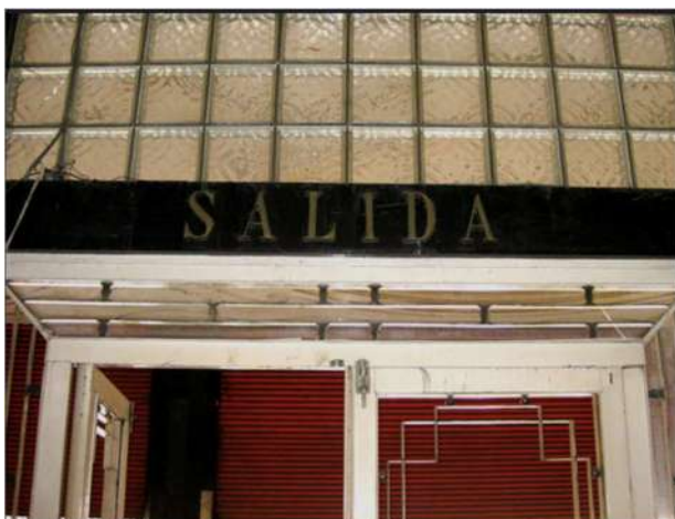
Salida a la calle desde vestíbulo principal
