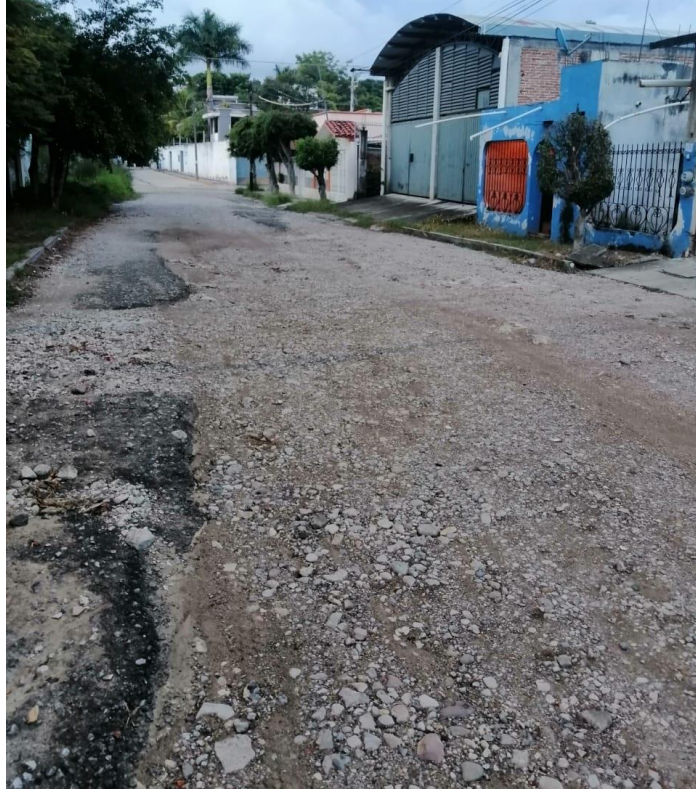
Figura 11: Condiciones actuales de la calle
