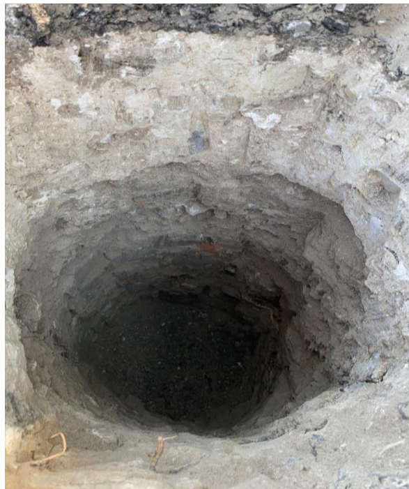
Figura 39: Excavación que se realizó para hacer el sondeo y extraer el material
