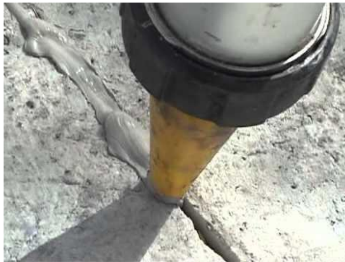
Figura 21: Calafateamiento de agrietamientos
