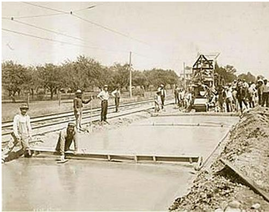
Figura 3: Colocación de concreto a una calle en construcción
