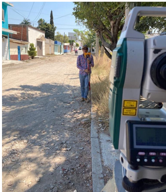
Figura 29: Levantamiento topográfico con estación total
