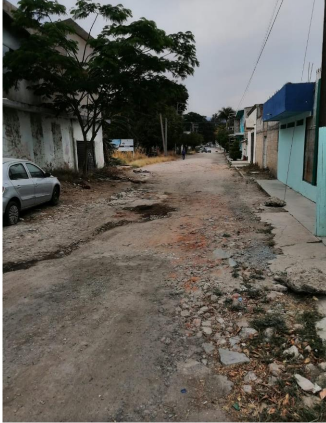
Figura 12: Condiciones actuales de la calle
