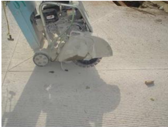
Figura 22: Fresado de la superficie
