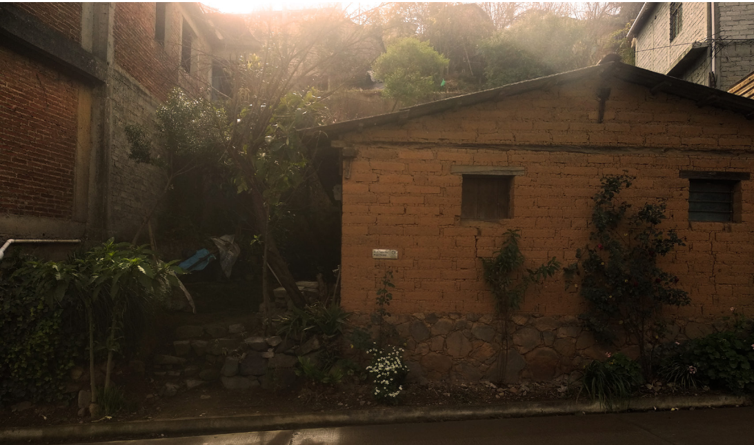
Vivienda de adobe con basamento de piedra en Tlahuitoltepec. El acceso se da lateralmente al patio que conecta con el espacio construido. Foto tomada por: Gimena Bustamante.
