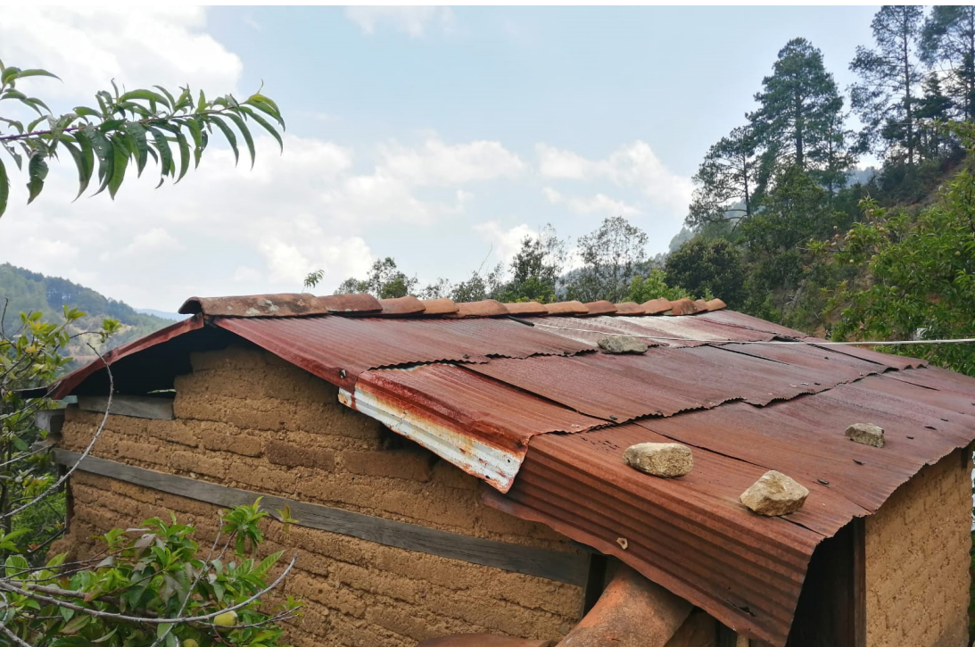
Cubierta del área de la cocina. Foto tomada por familiares de Carolina Vázquez Pérez
