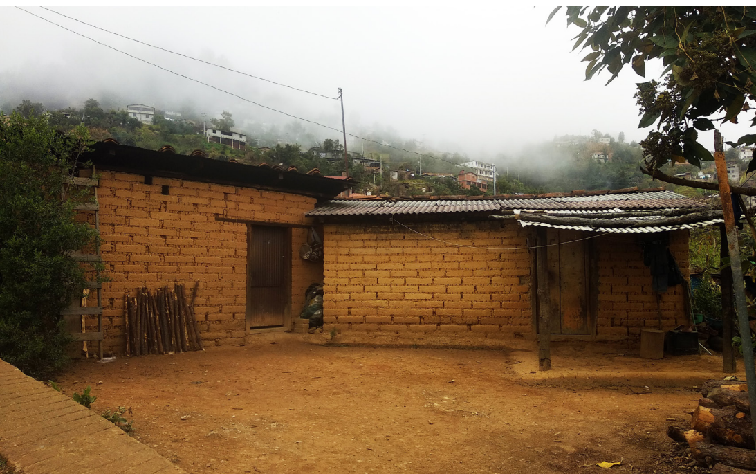
Vivienda elaborada con bloques de adobe y cubierta de lámina en Tlahuitoltepec. Tipología que responde a un patio de acceso que vincula los módulos en el solar. Foto tomada por: Gimena Bustamante.
