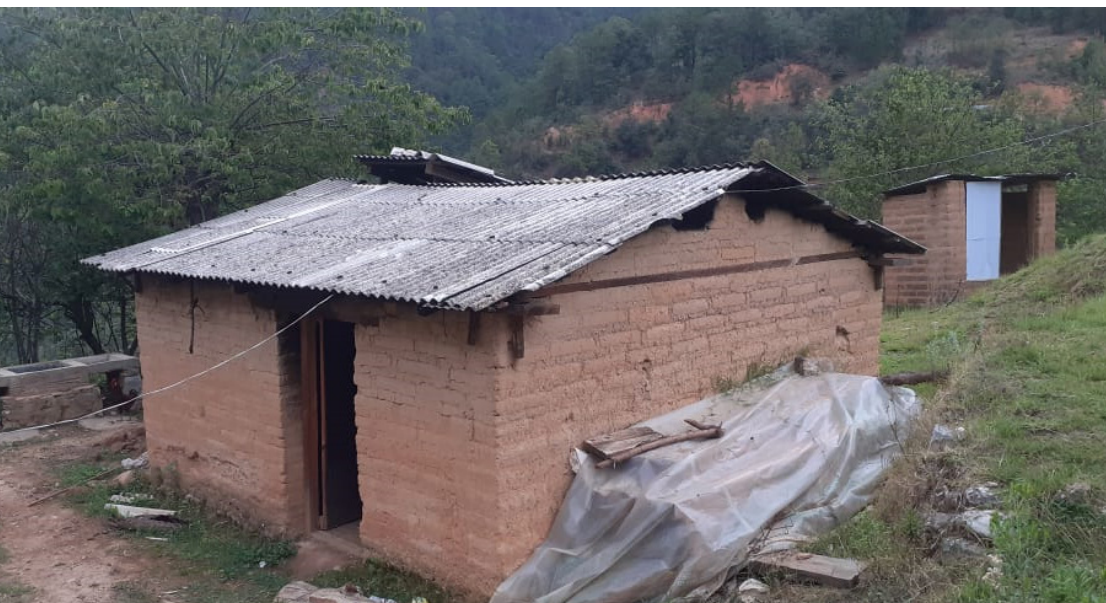
Vista hacia el módulo de la cocina y baño. Foto tomada por familiares de Gregoria Vázquez Vázquez
