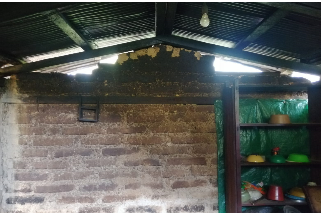
Vista interior del de la cocina. Hueco en parte superior de muro para ventilar. Foto tomada por familiares de Carolina Vázquez Pérez
