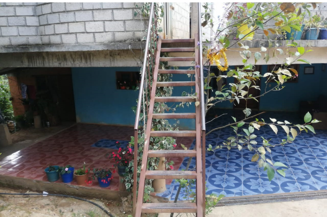
Vista del acceso, patio que funge como estacionamiento y escaleras de acero al primer nivel. Foto tomada por familiares de Teresa Pérez Pérez
