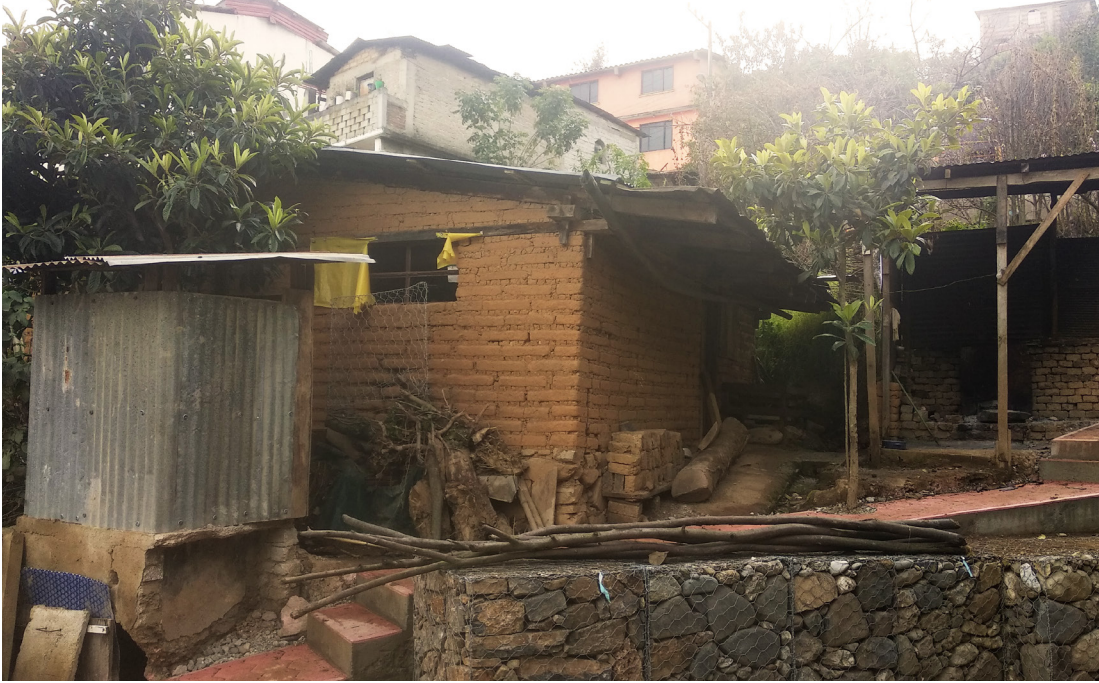
Viviendas con modulo de baño elaborado de lámina, módulo para dormir elaborado de bloques de adobe y fogón al aire libre en Tlahuitoltepec. Foto tomada por: Gimena Bustamante
