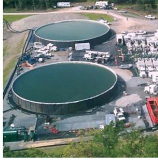
Figura 1.32: Tanques de paneles de acero.
