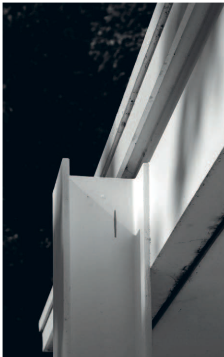
Imagen 29.0 Detalles y propuesta estructural para la casa; como se puede ver la calidad constructiva fue impecable, sin embargo, los costos incrementaron sustancialmente debido a los incrementos por los que pasaba constantemente el acero. Cervilla, Alejandro. La evolución de la imagen de la estructura en las viviendas de Mies Van der Rohe.
