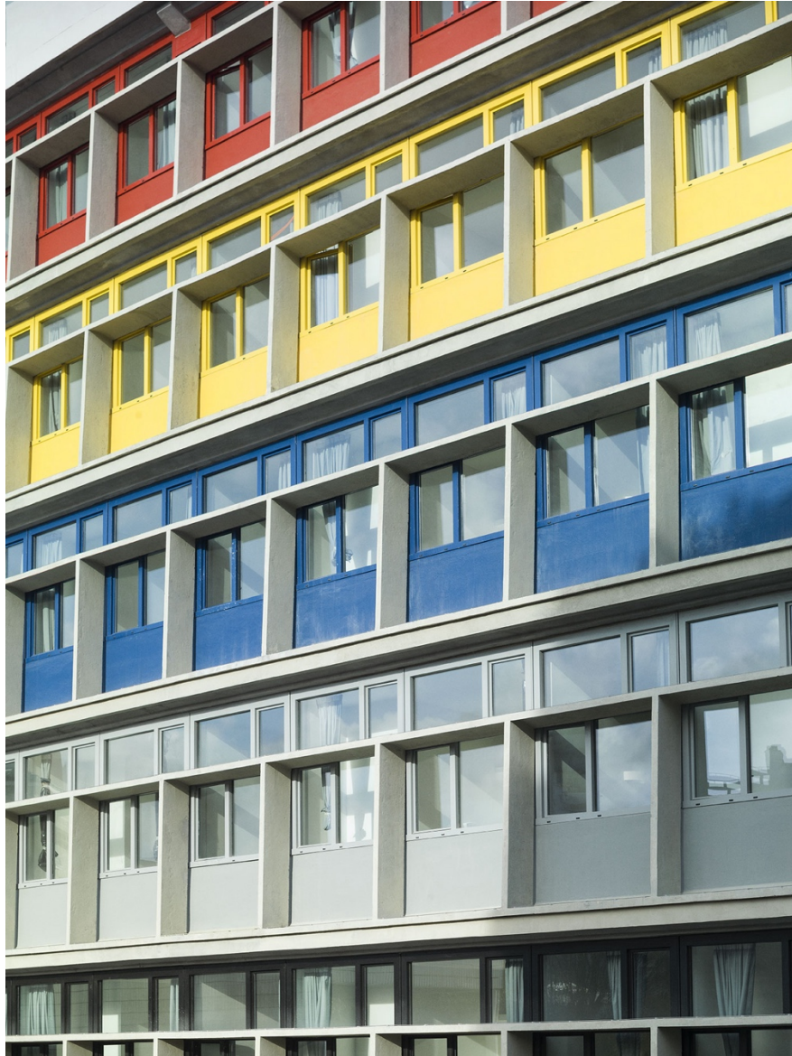
Imagen 32.0 Le Cité de Refuge por Le Corbusier con su fachada de cristal. Fotografía extraída de Chatillon Architectes https://www.chatillonarchitectes.com/portfolio/cite-de-refuge/
