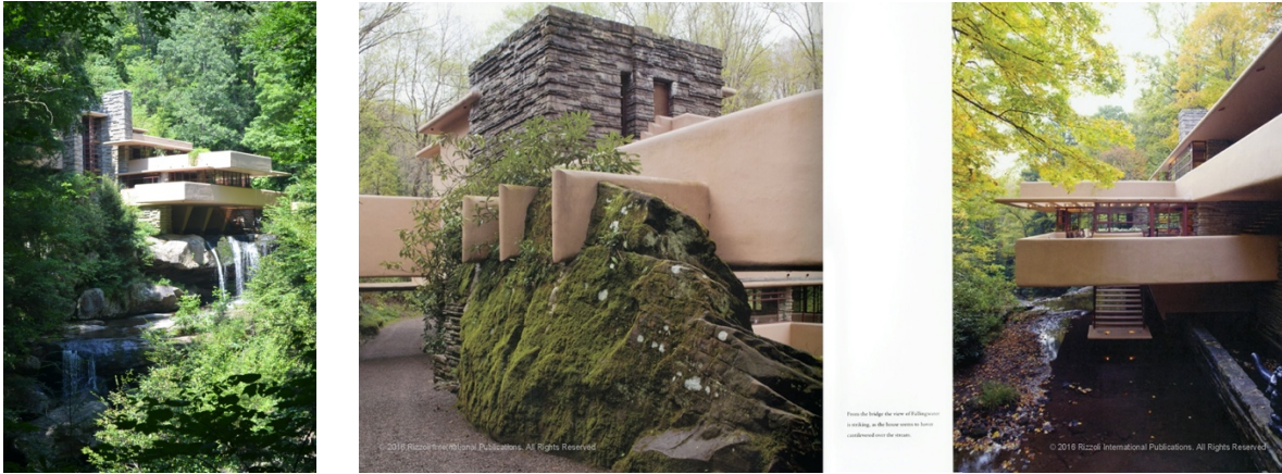
Imagen 25.0 Diferentes vistas de la Casa de la Cascada, Christopher Little 2016, el resultado compositivo y estético fue impecable, sin embargo, bajo el cuidado y la dedicación estética y espacial existen múltiples deficiencias técnicas que provocaron que esta construcción fuera una casa prontamente obsoleta. Hoy en día funge como museo. Little, Christopher. Fallin water, la importancia del fallo II . Rizzoli. Fuente. https://christopherlittle.com/
