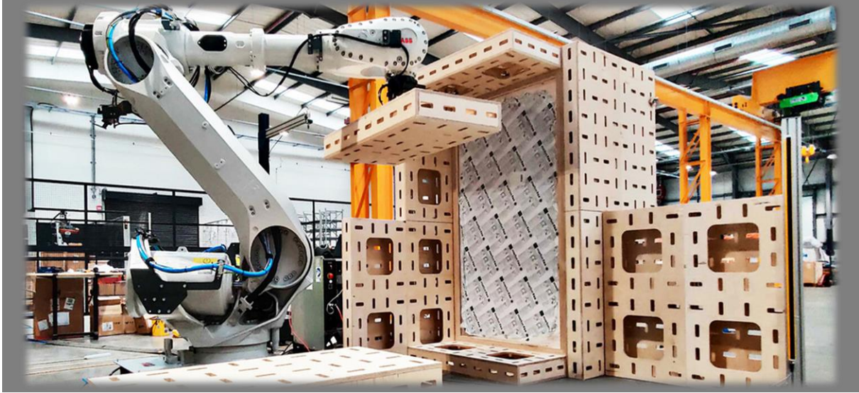
Ilustración 3.42 Proceso de trabajo de AUAR. Fuente: Revista digital Designboom . Accedido el 22 de enero 2022 en: < https://www.designboom.com/architecture/automated-architecture-auar-robotically-assembled-dwelling-global-investment-summit-uk-10-19-2021/ >
