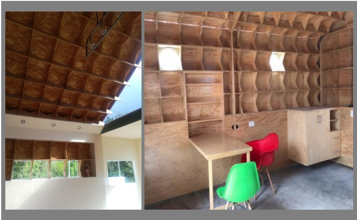
Ilustración 4.16 Tercera fase del proceso de construcción on-site . Fuente: Archivo personal.
