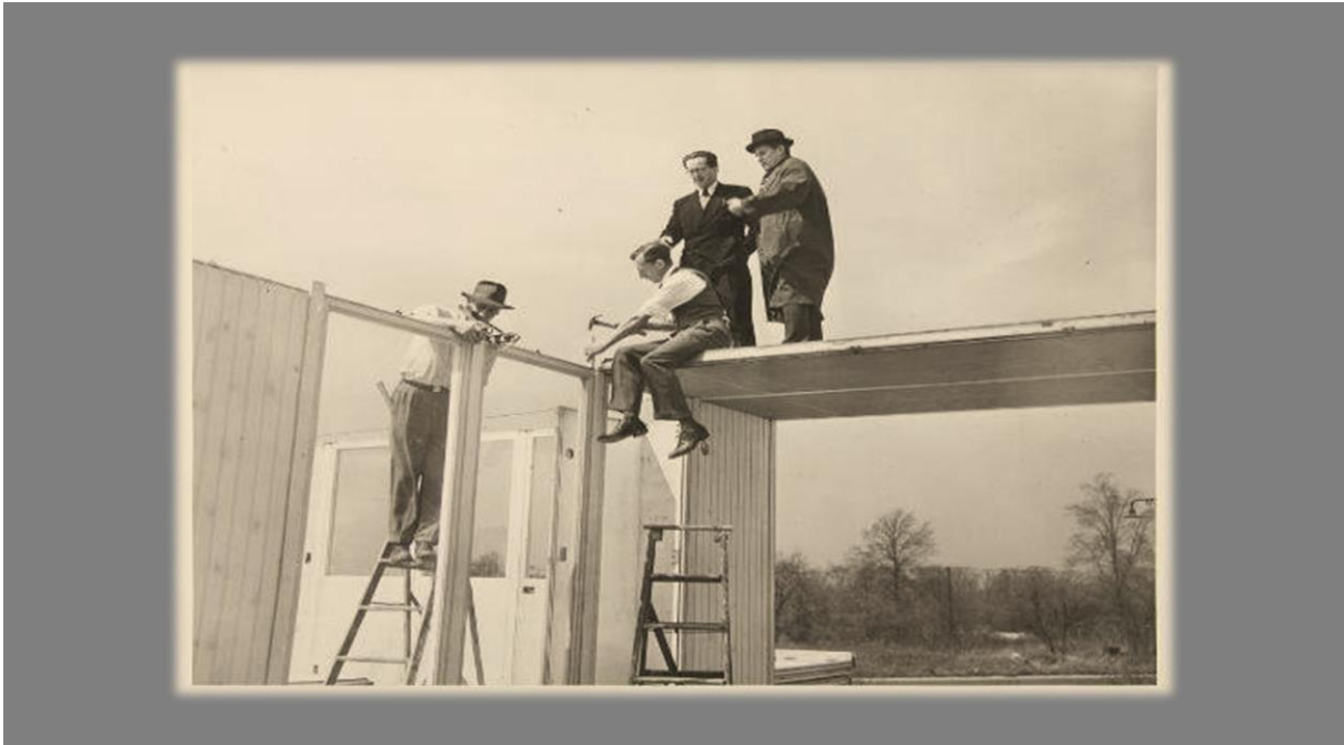
Ilustración 2.15 Wachsmann y Gropius arriba de losa de la casa. Fuente: (Saiz, 2020b).
