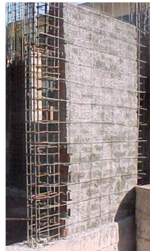
Figura 3.4 Acero de refuerzo de camisa de concreto: a) muro existente de concreto (seismosoft.com), b) muro existente de mampostería (cerem.ufp.pt)
