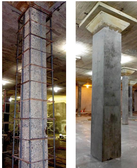
Figura 3.1.1 Columna con encamisado no continuo
