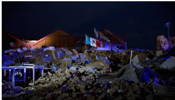
Figura 1.2.2 Escombros de un colapso debido al sismo en Juchitán, Oaxaca (SkyAlertMX, 2017)
