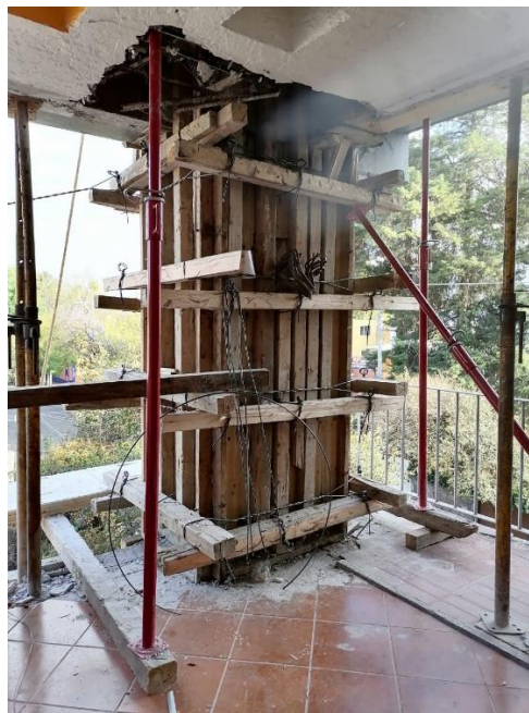
Figura 3.2.5.1 Cimbra de la camisa de una columna rehabilitada
