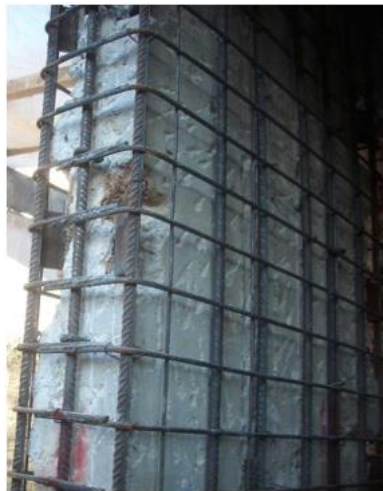
Figura 3.4 Acero de refuerzo de camisa de concreto: a) muro existente de concreto (seismosoft.com), b) muro existente de mampostería (cerem.ufp.pt)
