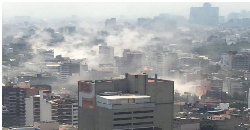
Figura 1.3.1 Nube de escombros resultado de colapsos en la Ciudad de México debido al sismo (Arquine, 2017)
