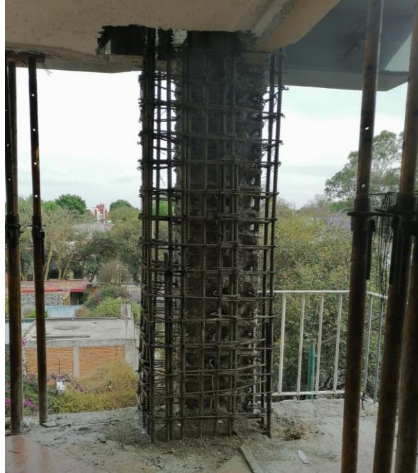
Figura 3.1.2 Columna con encamisado continua a través de losas planas
