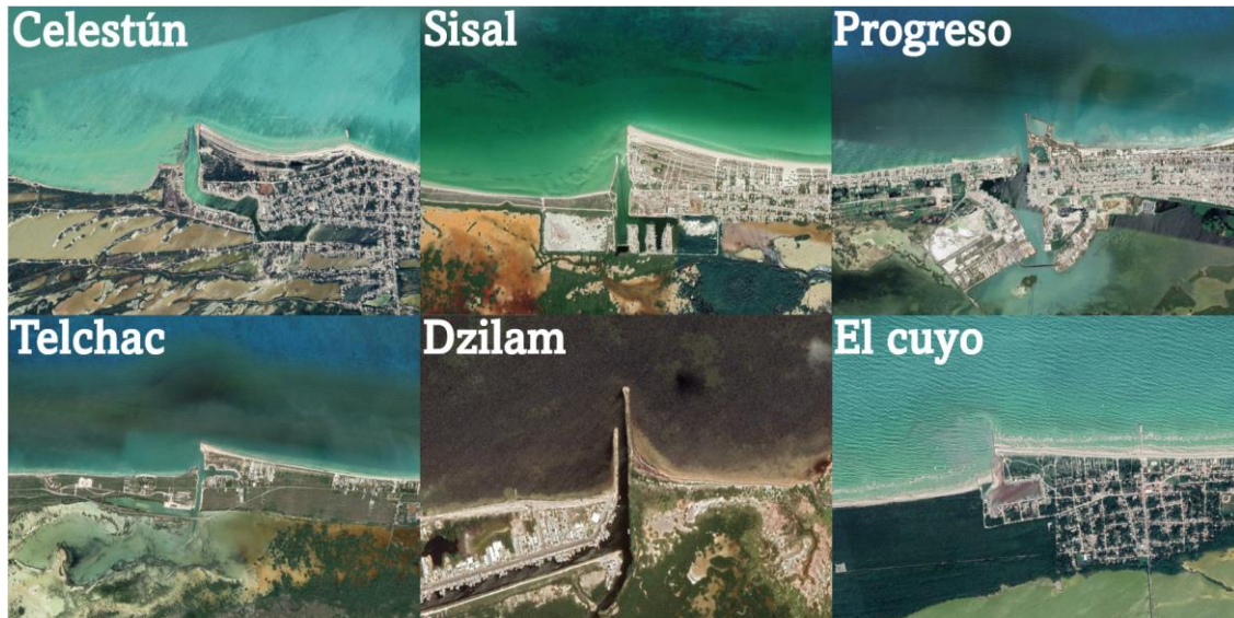
Fig. 1 Imágenes satelitales de los puertos de abrigo de las seis localidades estudiadas. Obsérvese la acumulación de arena en el lado este de los puertos (Google Earth, 2020).
