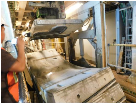
Figura 5.3 Dovelas empleadas en TEP II. (Cortesía Dr J.Ma Chávez, 2022)
