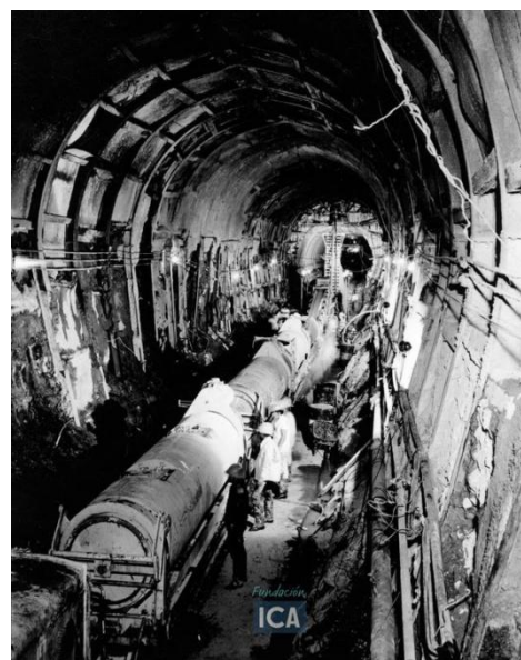
Figura 4.6 Túnel Emisor Central en 1975 (ICA, 2018)
