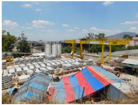
Figura 5.2 Dovelas empleadas en TEP II. (Cortesía Dr J.Ma Chávez, 2022)
