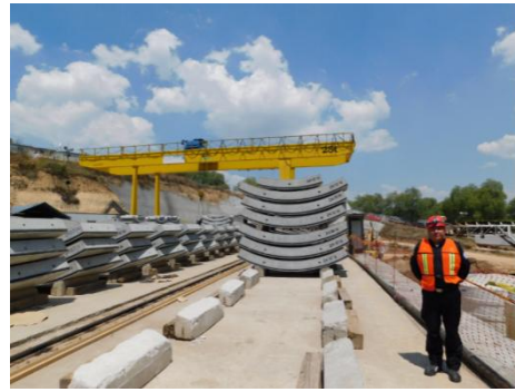
Figura 5.2 Dovelas empleadas en TEP II. (Cortesía Dr J.Ma Chávez, 2022)
