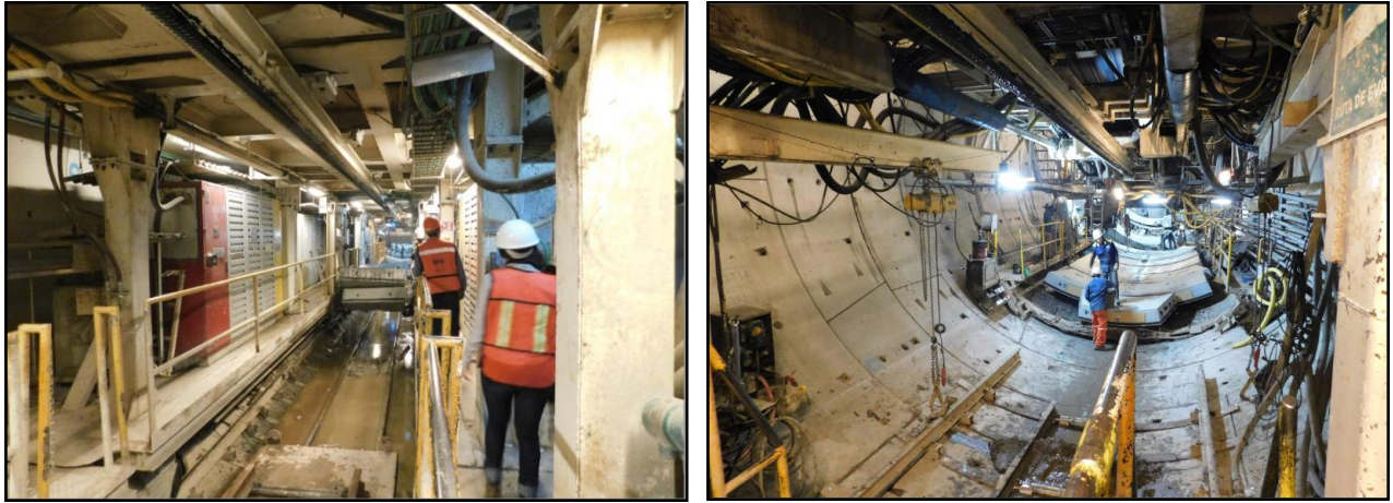
Figura 6.8 Interior de Tuneladora TBM TEP II (Cortesía Dr J.Ma Chávez, 2022)
