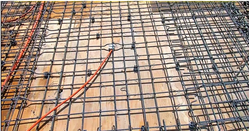
Figura 25. Armado de losa maciza. Foto tomada de internet.
