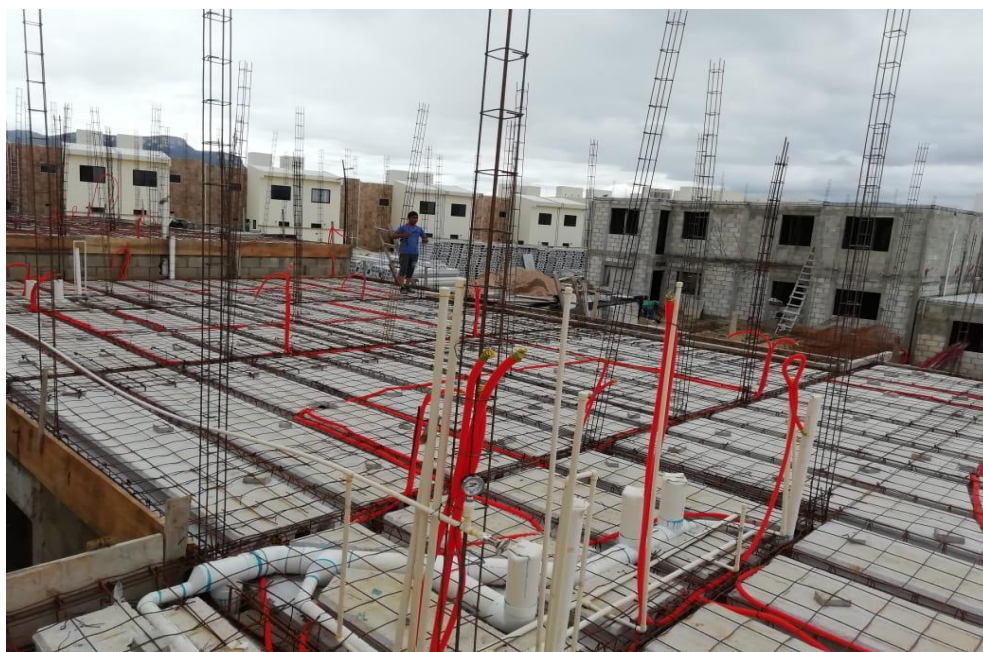
Figura 18. Losa steelfoam lista para colar. Foto tomada en obra Valle Verde.
