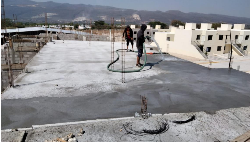
Figura 26. Curado de losa Steelfoam . Foto tomada en obra de Valle Verde.
