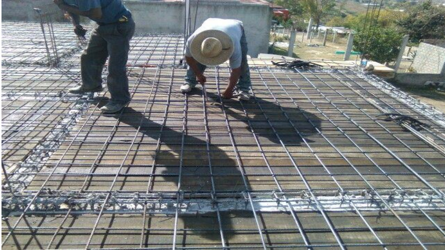
Figura 24. Armado de losa maciza. Foto tomada de internet.
