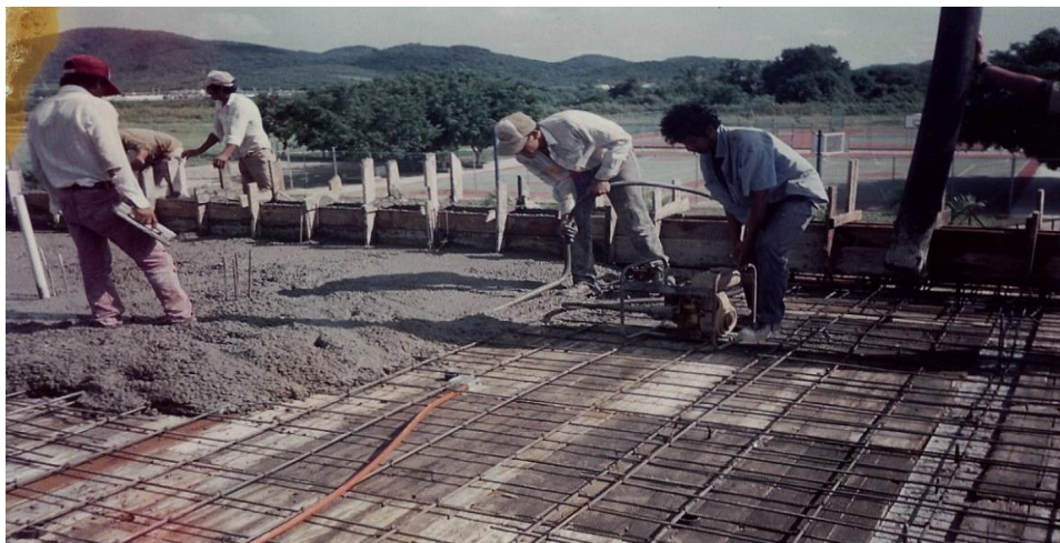
Figura 27. Colado de losa maciza. Foto tomada de internet.
