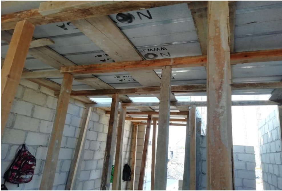
Figura 15. Cimbra de losa Steelfoam. Foto tomada en obra Valle Verde.
