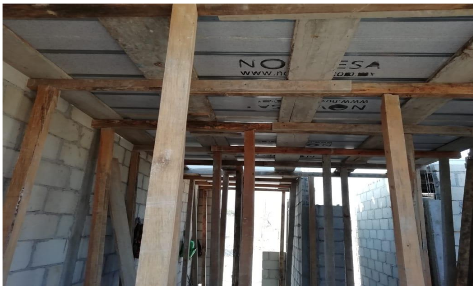
Figura 14. Cimbra de losa Steelfoam . Foto tomada en obra Valle Verde.
