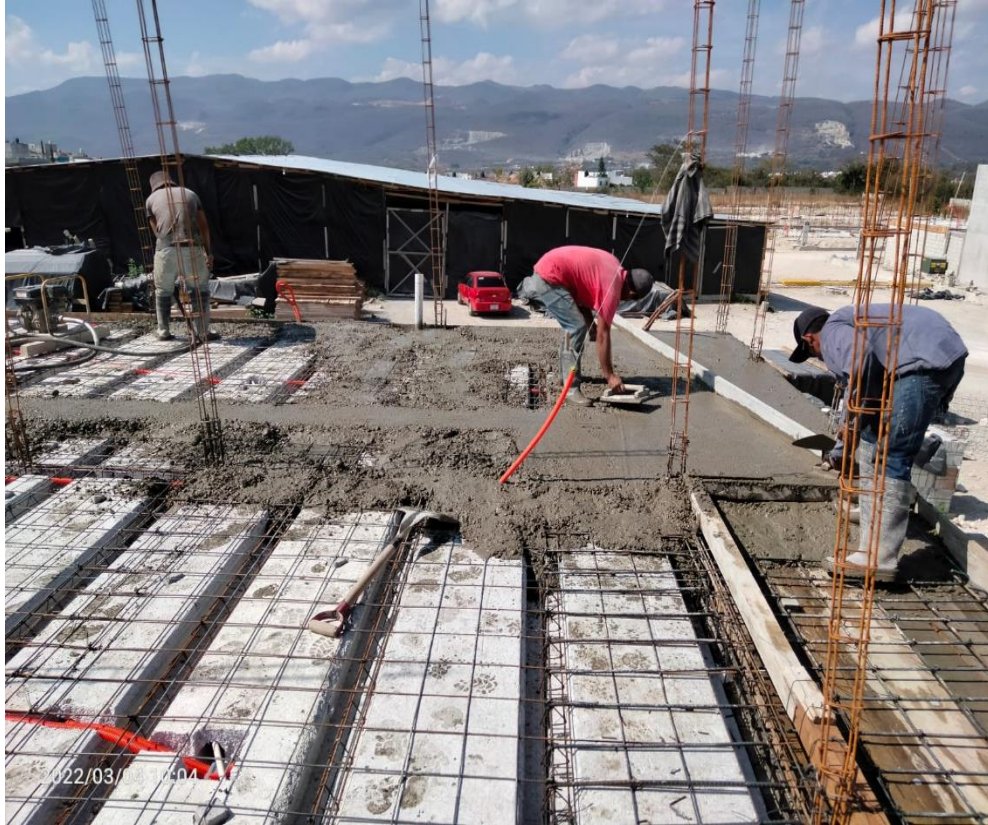
Figura 21. Colado de losa Steelfoam . Foto tomada en obra Valle Verde.
