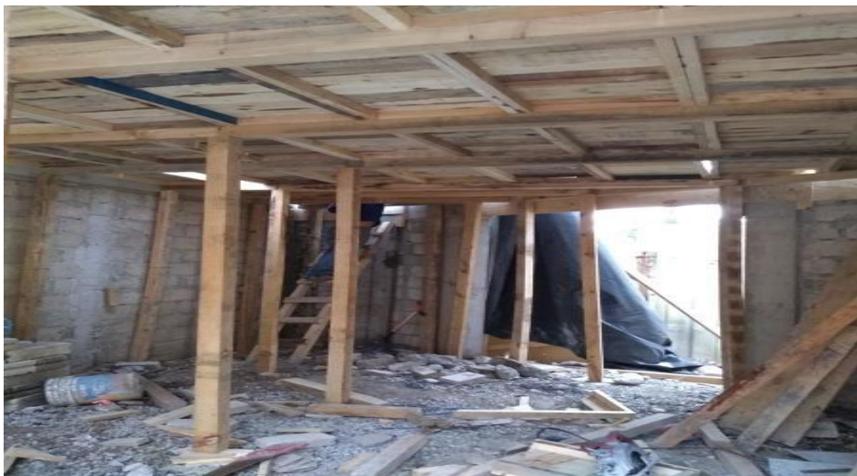
Figura 23. Cimbrado de losa maciza. Foto tomada de internet.
