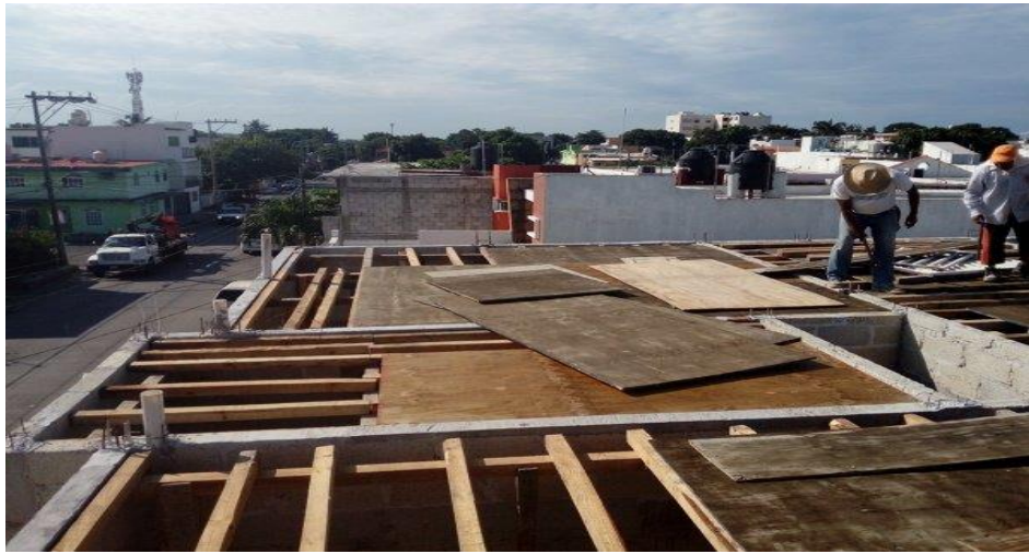
Figura 22. Cimbrado de fondos de losa maciza. Foto tomada de internet.
