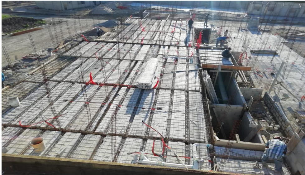
Figura 17. Detallado de losa steelfoam para colado. Foto tomada en obra Valle Verde.
