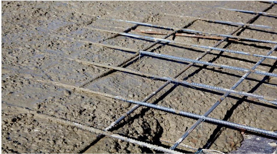
Figura 28. Colado de losa maciza. Foto tomada de internet.
