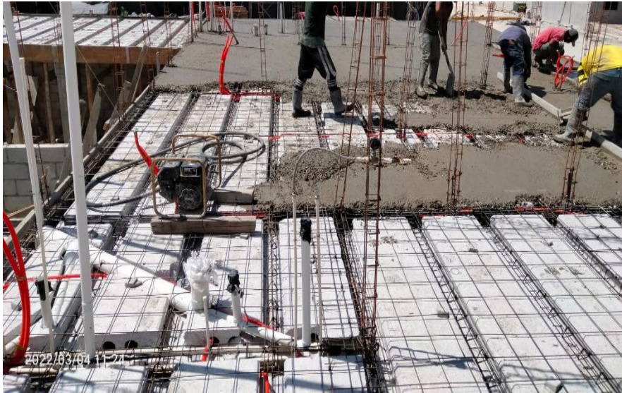
Figura 19. Colado de losa Steelfoam . Foto tomada en Valle Verde.
