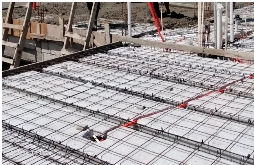
Figura 20. Armado de losa Steelfoam . Foto tomada en obra Valle Verde.
