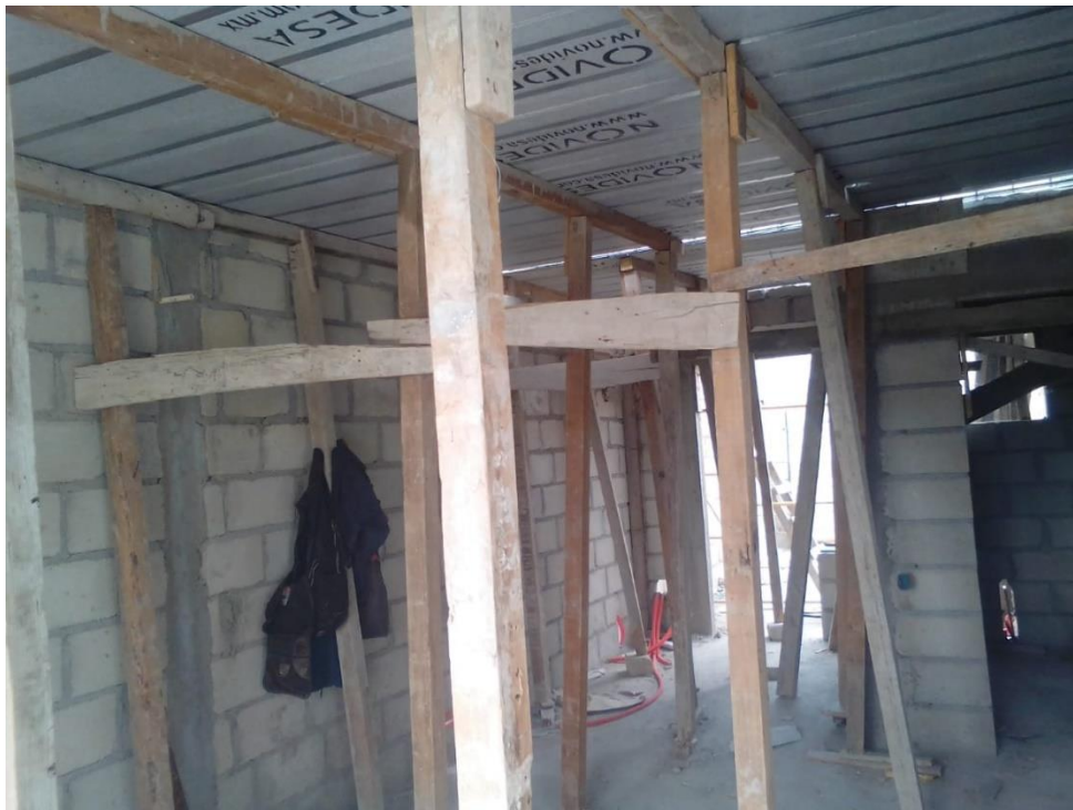
Figura 16. Cimbra de losa Steelfoam . Foto tomada en obra Valle Verde.
