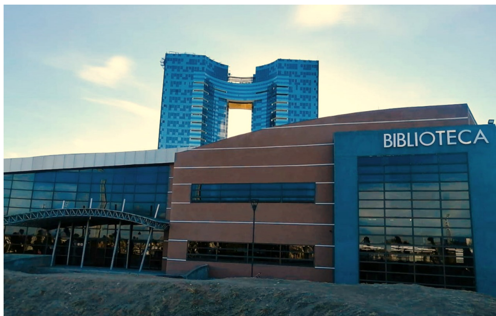
Figura 2.1: Fachada de la Biblioteca Pública Central del Estado de Hidalgo.
