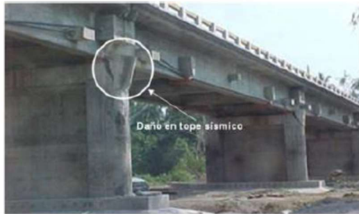
Figura 22. Daños en el Puente Coahuayana localizado en la carretera Playa Azul-Manzanillo, por el temblor del 21 de enero de 2003 ( M=7.6 ) (fuente: Jara, J. M., 2015)
