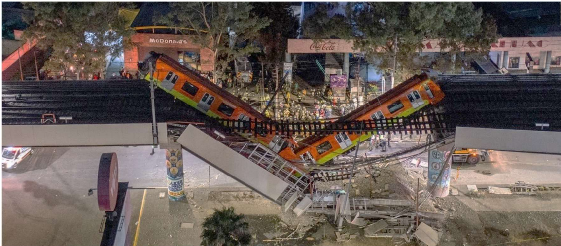
Figura 29. Colapso de tramo elevado línea 12 metro de la Ciudad de México
