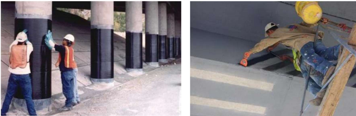
Figura 38. Refuerzo de una trabe cajón con fibra de carbono (imagen derecha) y confinamiento con fibra en la base de columnas (imagen izquierda) (Fuente: Jara, J. M.,2015)
