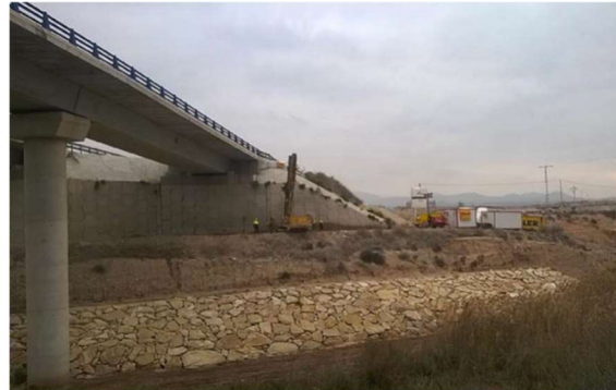
Mejoramiento del suelo (jet groutin)
