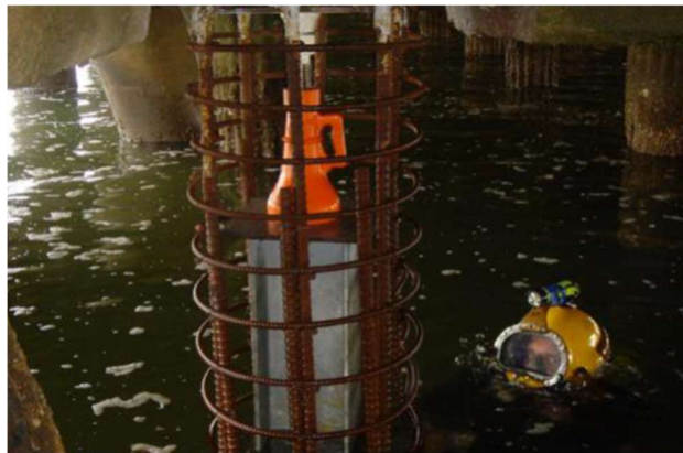
Reparaciones bajo agua (buceo especializado)
