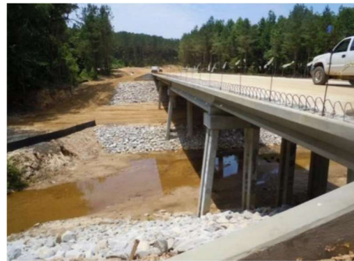
Protección contra socavación al pie de pilas
