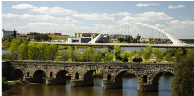
Reemplazo de puente existente
