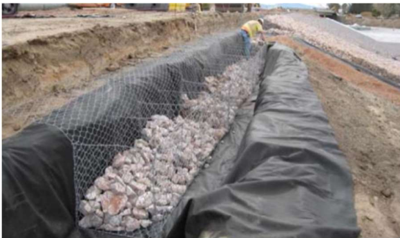
Protección del talud de la orilla superior
