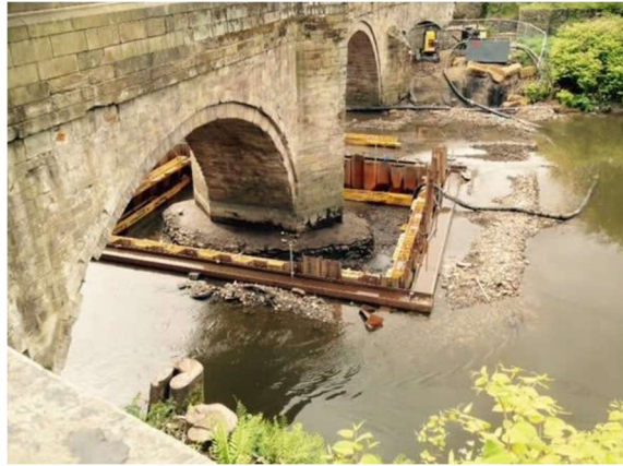
Reparaciones en seco (ataquías)
