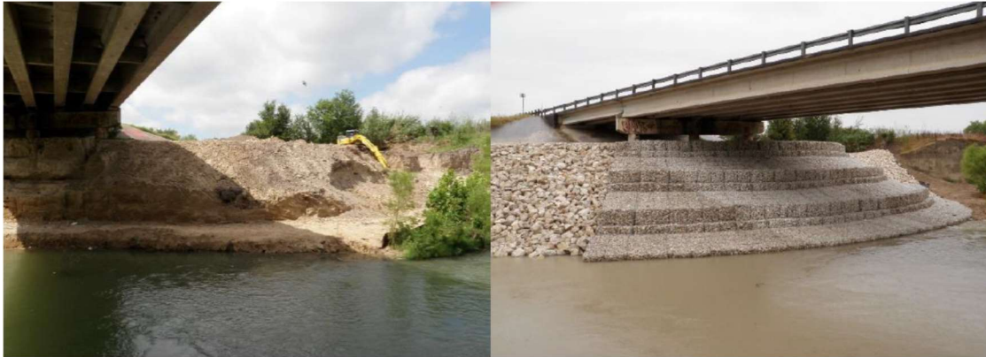
Protección de pilas y estribos con gaviones
