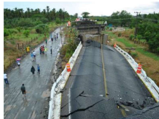
Figura 23. Puente Cuajilote colapsado por pérdida de longitud de apoyo durante el sismo de Guerrero del 8 de mayo de 2014.
