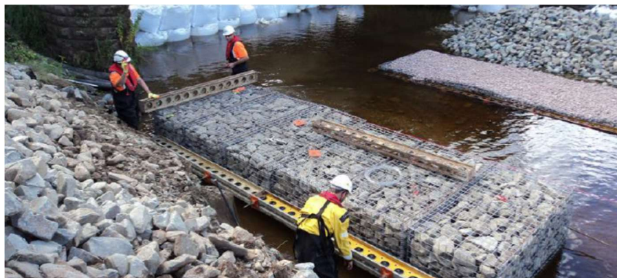
Protección de pilas y estribos con pantallas
