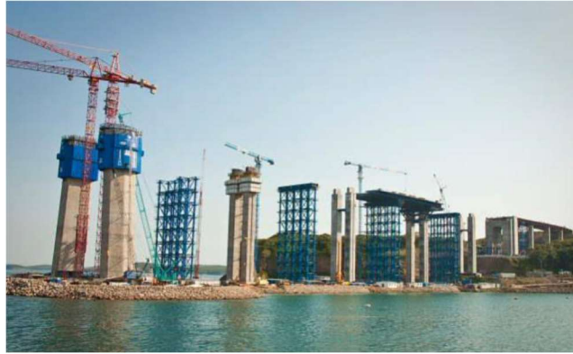
Reparaciones en seco (Islas)
