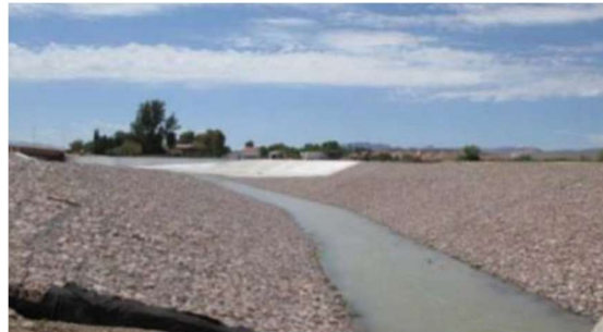
Protección del talud del dique
