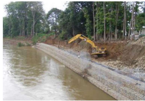
Protección del talud de la orilla inferior
