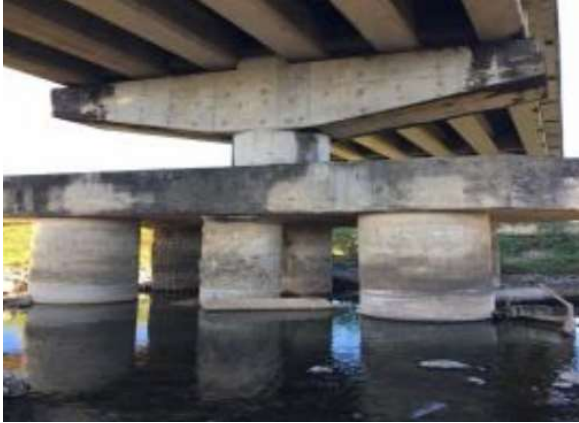
Figura 24. Puente Vado ancho, Tapachula – Arriaga, daños por socavación local en pilas y exposición de acero de refuerzo (CENAPRED, Instituto de ingeniería UNAM,2017)
