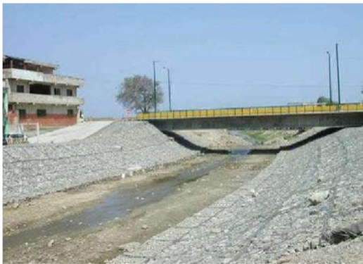
Protección contra socavación por contracción
