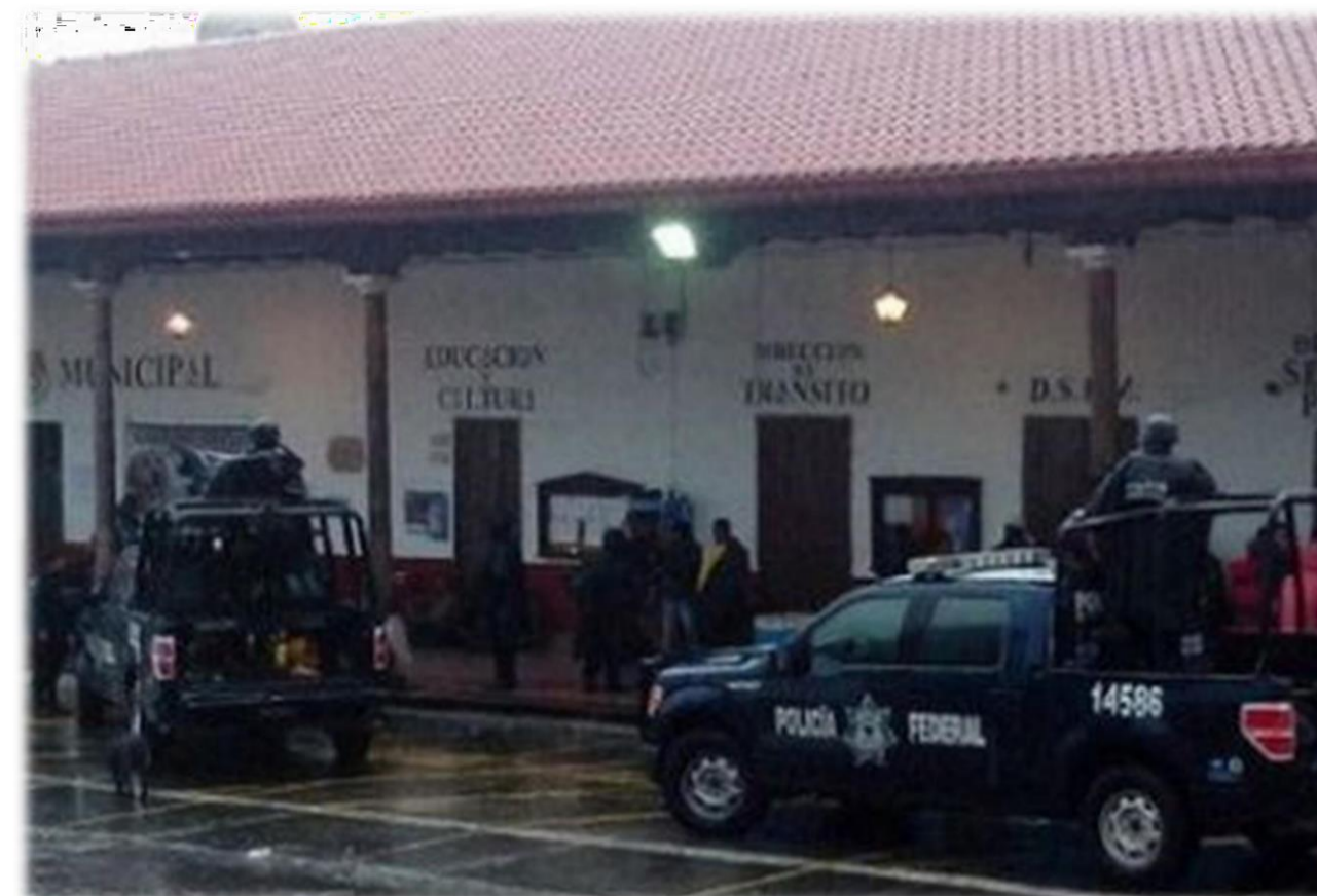
Fachada principal de la Presidencia Municipal de Tancítaro, Mich.
