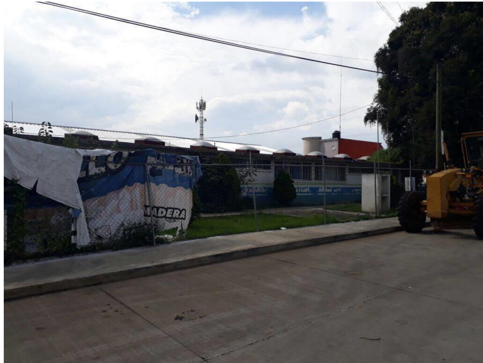
Toma 5: parte de la fachada principal la cual en algunas áreas tiene tapada la vista por medio de lonas que no tienen ninguna información referente al centro de salud
