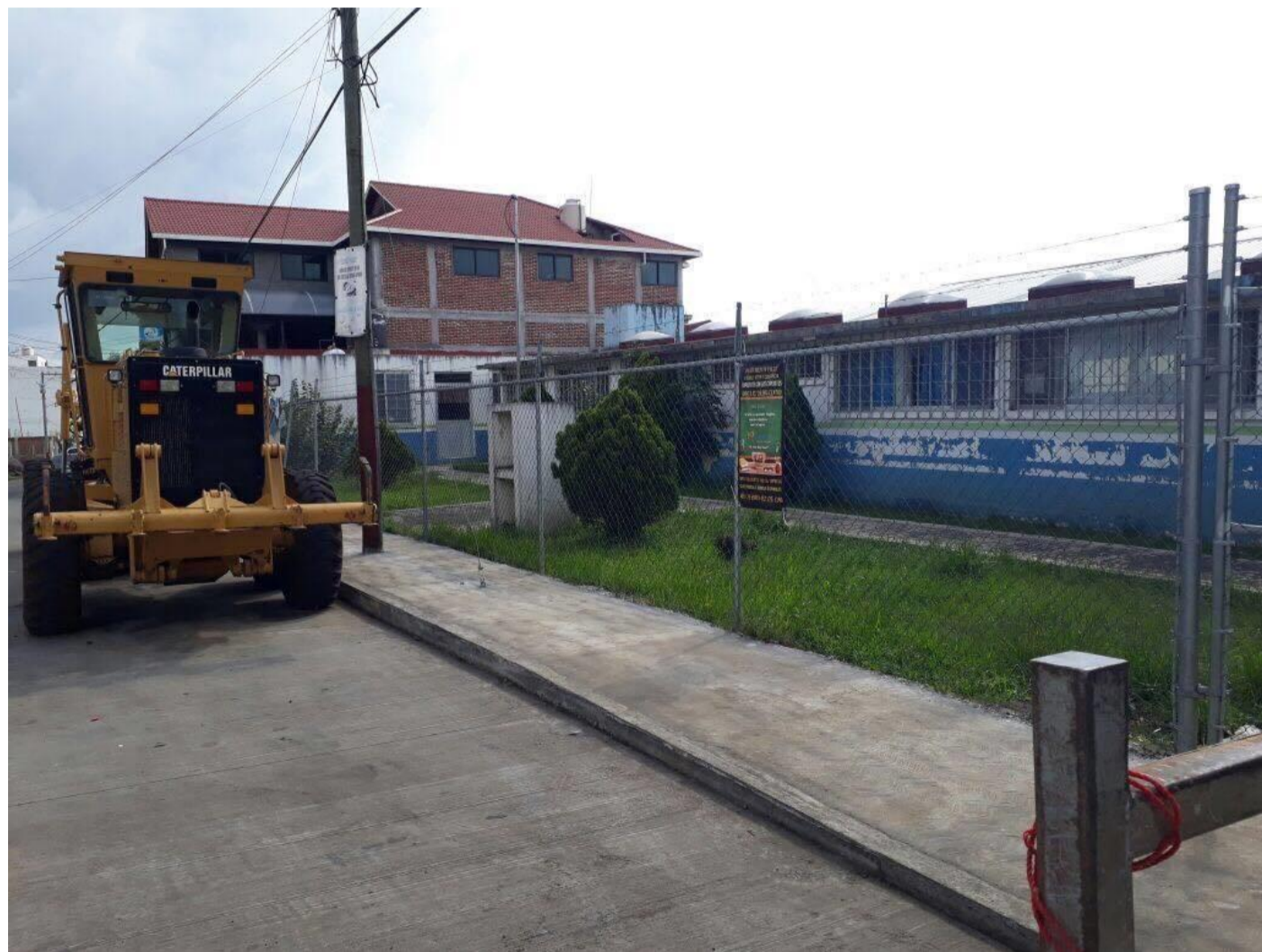
Toma 3: cuenta con una malla perimetral de la construcción la cual en ciertos puntos ya esta en mal estado, y se aprecia una banqueta con las dimensiones apropiadas
