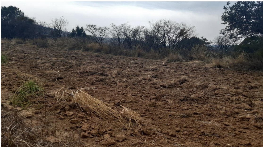
Figura No. 25 Preparación de Terreno
