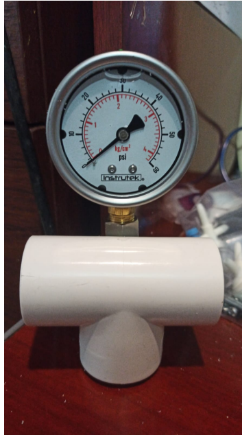
Figura 4.10: Montaje del manómetro en la conexión tipo “T” de PVC
