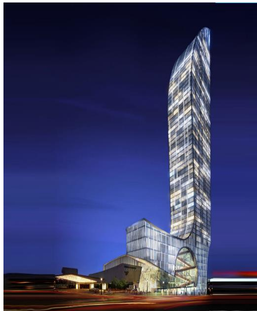
Figura 2.3. L-Tower (tomada de arquitecturaenconstruccionenelmundo.blogspot.com )
