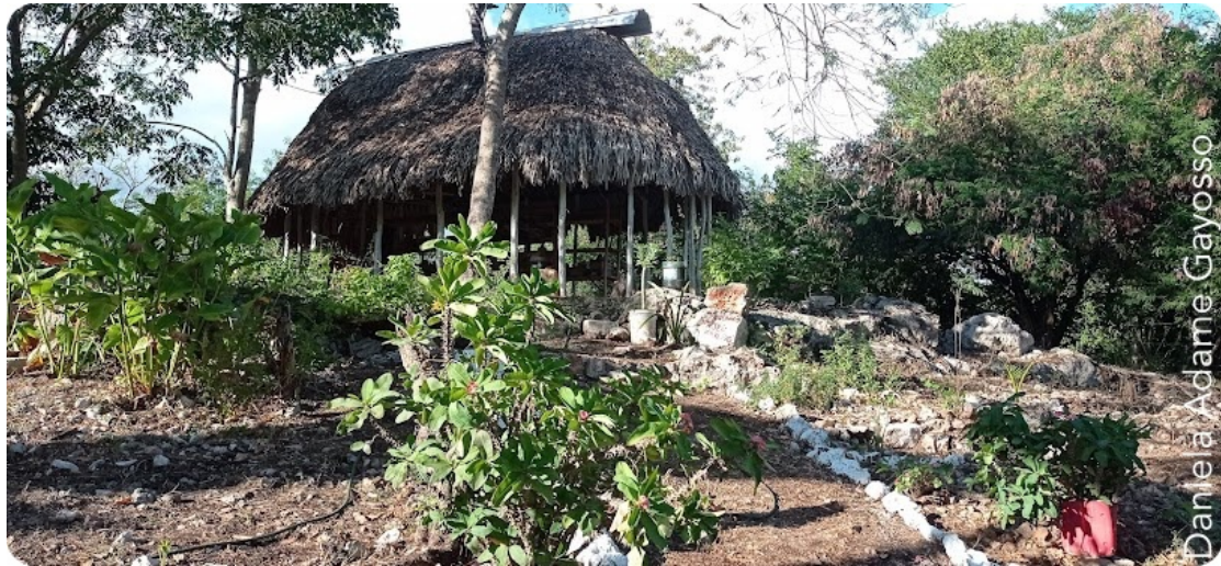
Fig. 18 Meliponario del grupo Meejen kaboo'b, Teabo, Yucatán construido en una porción elevada del terreno para evitar inundaciones, se puede apreciar que la estructura de soporte está elaborada con madera y el techo por palma terminado con una cumbrera de lámina de zinc.
