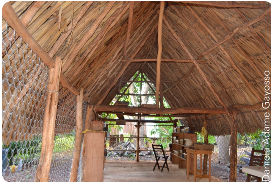
Fig. 21 Meliponario del grupo Jara Orión, Tekax, Yucatán, se puede observar la estructura interior del techo, elaborada con madera y palma, la estructura de soporte está constituida por madera y delimitada por malla ciclónica. Las colmenas están dispuestas en anaqueles de madera y se aprecia una mesa para manejos.
