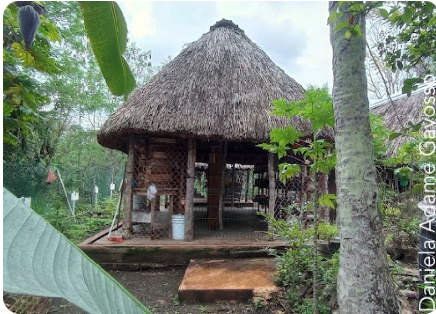
Fig. 20 Meliponario del grupo Flor de Jazmín, Xaya, Yucatán. La estructura de soporte está elaborada con madera y delimitada por malla ciclónica, el techo está constituido por palma con cumbreira de lámina de zinc, el piso está elevado respecto al suelo y las colmenas están sobre soportes de madera.
