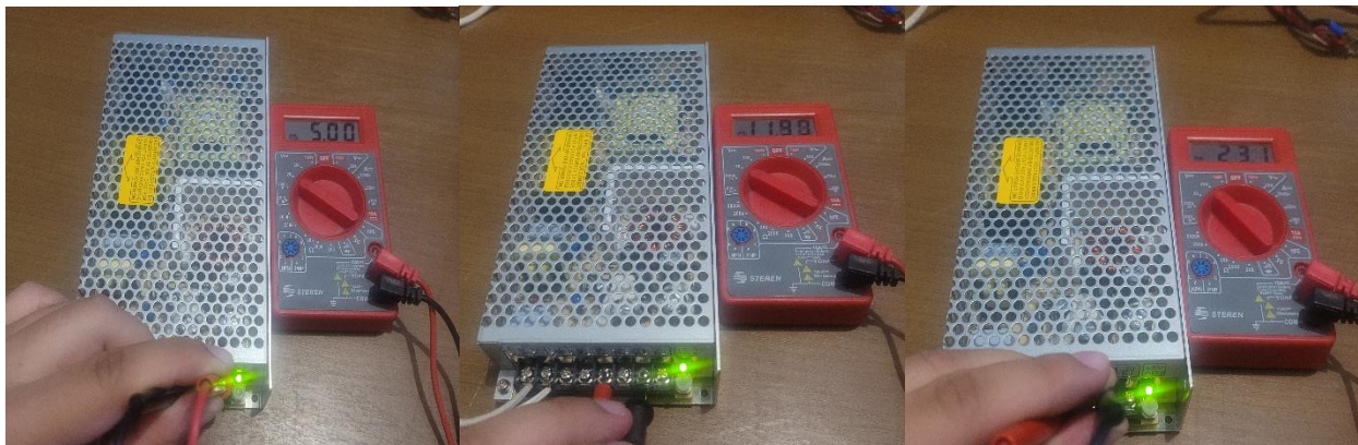
Ilustración 71 - Evidencia prueba de la fuente de alimentación
