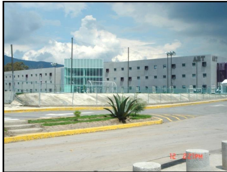
Figura 10.-Vista del edificio de internado.
