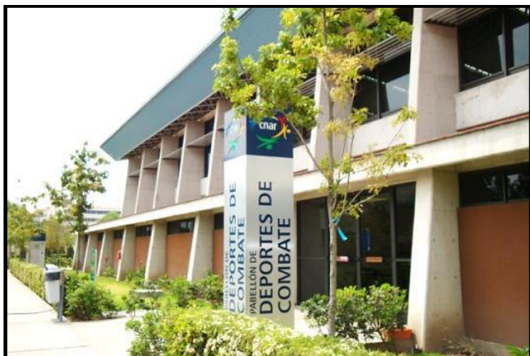
Figura 88.-Fachada de acceso al Pabellón de Deportes de Combate.
