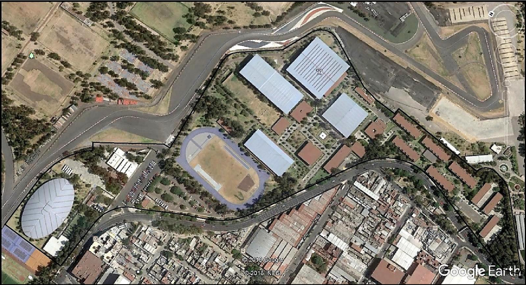
Figura 70.-Vista satelital de conjunto de edificios que integran el C.N.A.R., imagen extraída de Google Earth.
