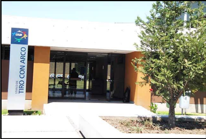
Figura 96.-Fachadas de acceso al Stand de Tiro con Arco.
