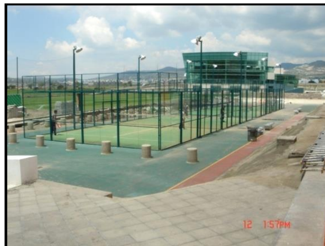
Figura 19.-Canchas de tenis.
