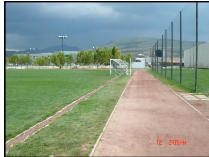
Figura 23.- Andadores, drenaje pluvial y barrera para retener balones en las prácticas a portería en canchas de fútbol.
