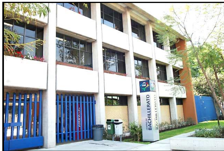
Figura 73.-Vista del acceso a la Escuela de Bachillerato.
