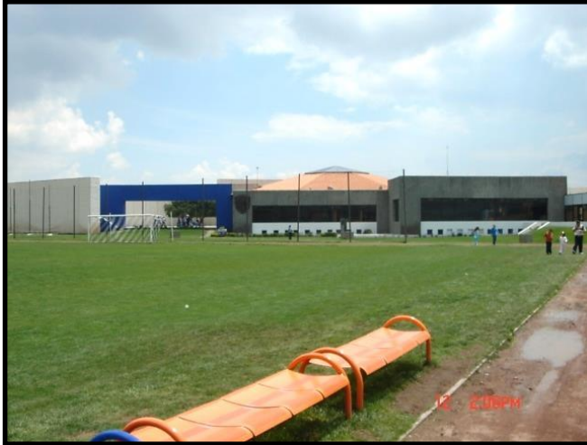
Figura 6.-Vista de la zona deportiva y al fondo la zona administrativa.
