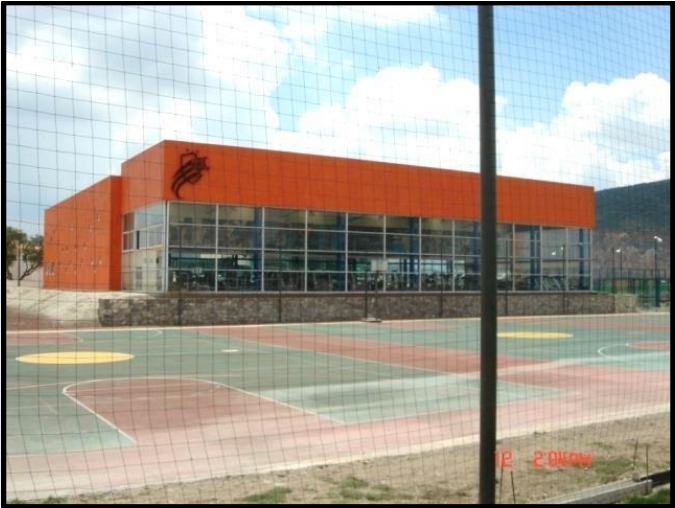
Figura 11.-Gimnasio de acondicionamiento físico.
