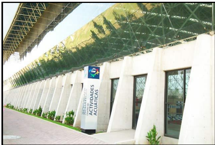
Figura 83.-Fachada de acceso al Pabellón Acuático.
