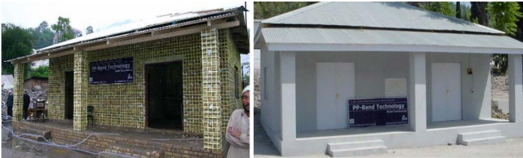
Figura 46. Rehabilitación estructural con bandas de polipropileno en Pakistán (JBIC, et al., 2007).
