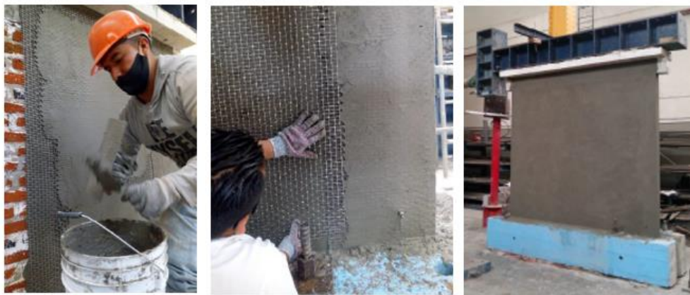
Figura 57. Encamisado textil con fibra de vidrio y curva de comportamiento histerético (Lubin, 2021).
