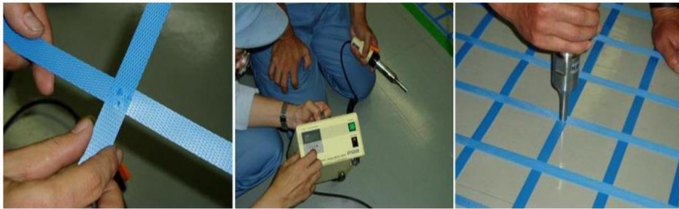
Figura 49. Proceso de pegado de bandas para la formación de la malla de polipropileno (Sathiparan, 2012).
