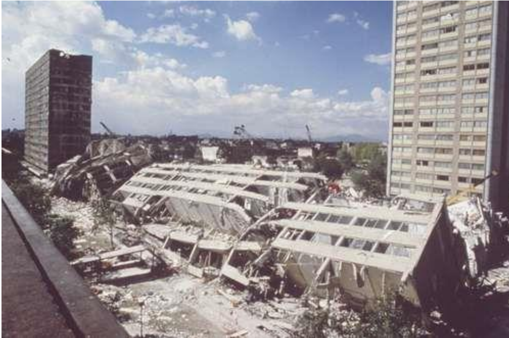
7 La Jornada (2010) Edificio Nuevo León, Tlatelolco, derribado debido al sismo de 1985 [Fotografía]. Recuperado de https://www.jornada.com.mx/2010/09/19/politica/002n1pol .
