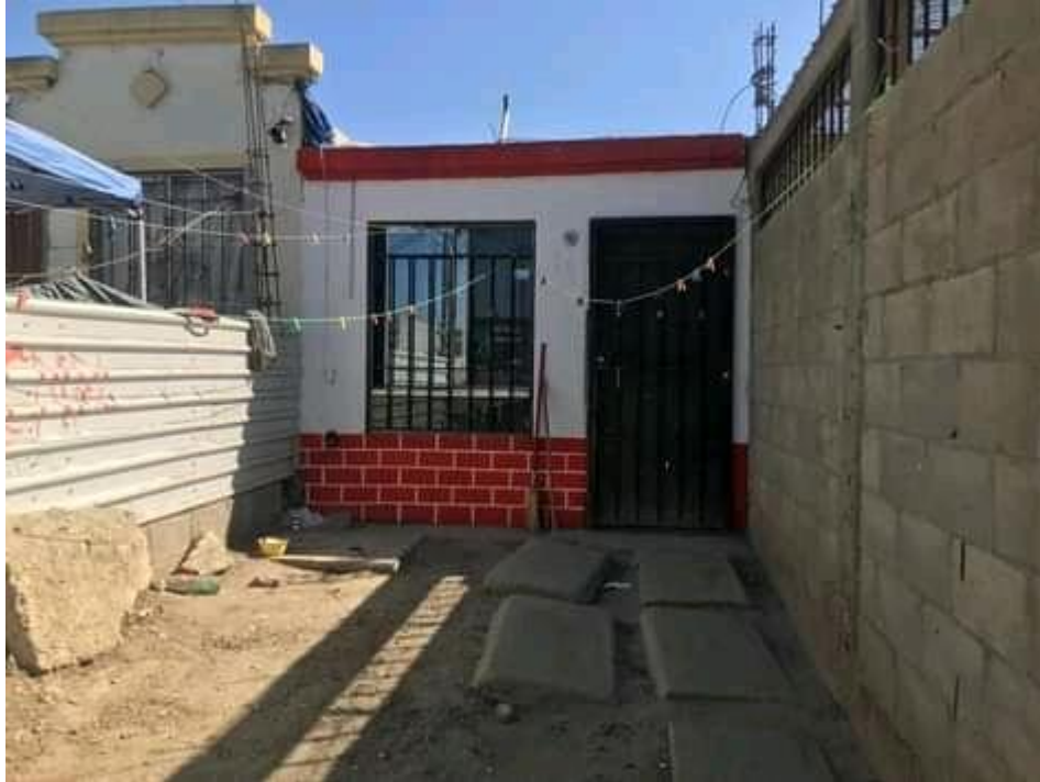
70 Estado actual de una vivienda, con las modificaciones que sus habitantes le realizaron (2021). Foto tomada por un vecino anónimo.
