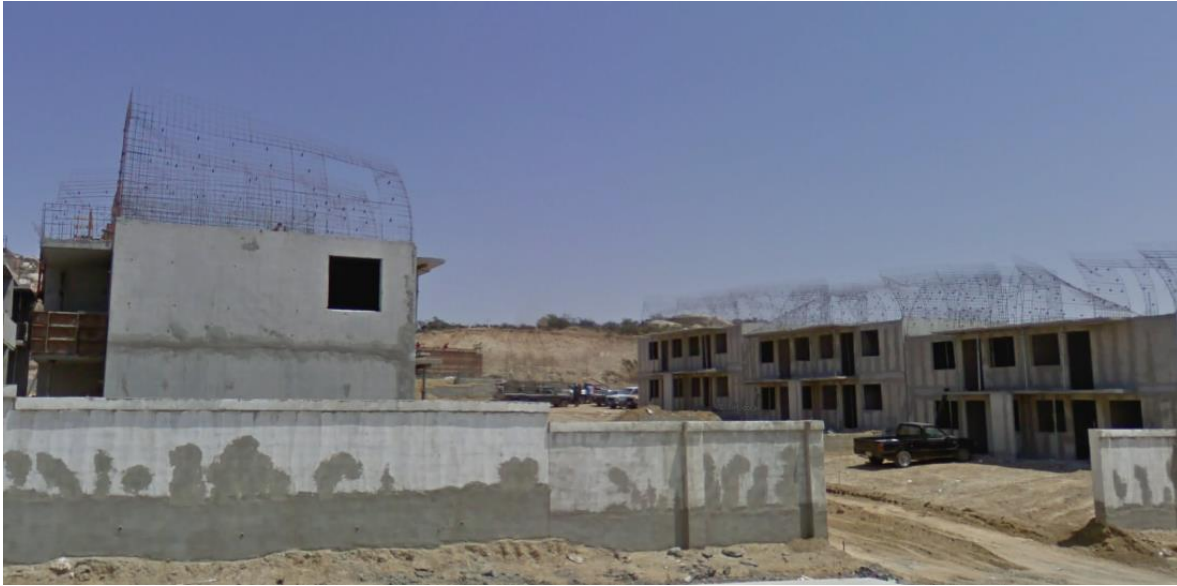
91 Vivienda tipología séxtuples/dodecaduplex en fase de construcción (2021). Recuperado de Google Maps.
