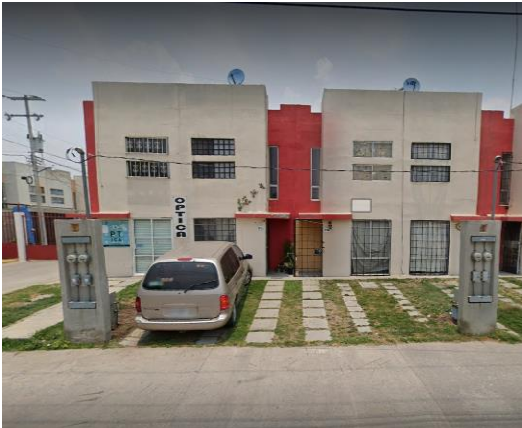
26 Vista de las fachadas, las viviendas ya han sido habitadas. (2021) Recuperado de Google Maps.
