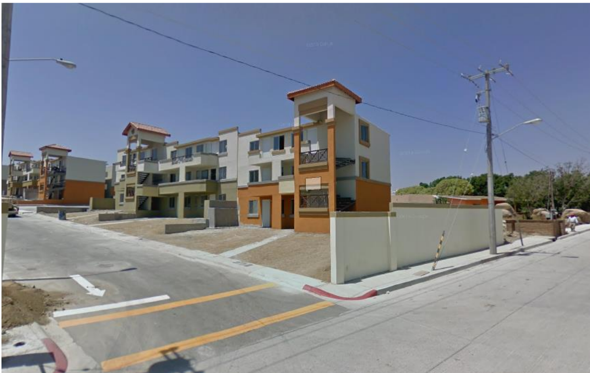
90 Vista exterior de la fachada del modelo séxtuplex/dodecaduplex (2021). Recuperado de Google Earth.
