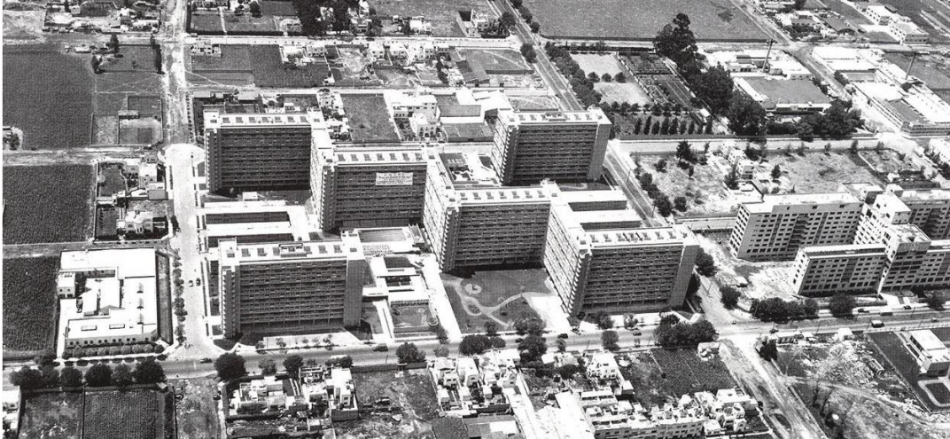
5 Vista aérea conjunto Presidente Alemán. Noticias 22 (2017) "El multifamiliar moderno", la utopía social [Fotografía]. Recuperado de https://noticias.canal22.org.mx/2017/07/06/el-multifamiliar-moderno-la-utopia-social/
