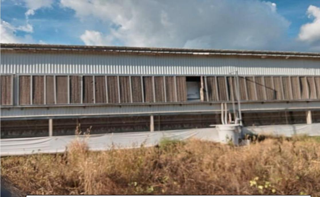
Figura 27. Exterior de la caseta. Se pueden observar paneles evaporativos dañados o faltantes.
