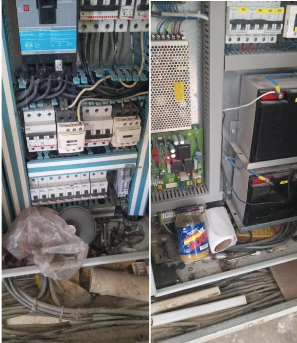
Figura 39. Interior de los paneles de control de la caseta. Se pueden observar objetos ajenos a su funcionamiento que pueden ocasionar daño o malfuncionamiento del equipo.
