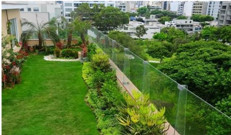
**Figura 2.3.** Ejemplo de azotea semi-intensiva [23].
