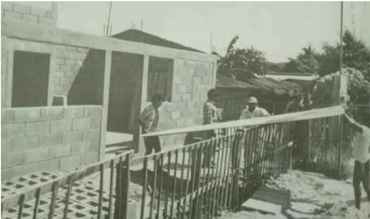
Imagen 5 y 6. Construcción de las primeras casas en ciudad Renacimiento; se pueden observar los blocks de concreto, la colocación de castillos como refuerzos verticales, así como los refuerzos horizontales. Obtenida de "Construcción y evolución urbana de la colonia Ciudad Renacimiento de Acapulco, Guerrero" por Miguel Ángel Sánchez Huerta, 2018, PP.: 81.
