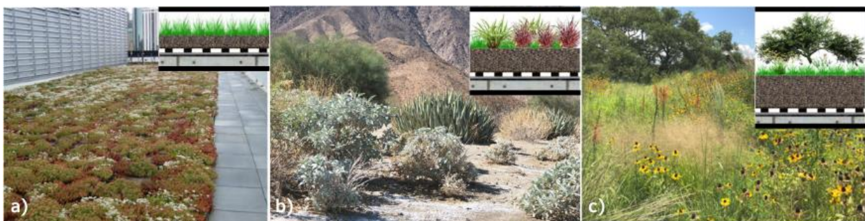
Figura 2. Diferentes tipos de azoteas verdes. a) Azotea verde extensiva de tipo modular (clima semi-árido), espesor de sustrato de 10 cm, Denver, Colorado. b) Azotea verde semi-intensiva (clima árido), espesor de sustrato de 30 cm, parque estatal del desierto de Anza-Borrego, San Diego, California. c) Azotea verde intensiva (clima subtropical húmedo), (con sistema de irrigación integrado), espesor de sustrato de 25 cm, Austin, Texas. Imágenes modificadas de Besir y Cuce (2018), Dvorak, B. (2021) y GSA (2011)
