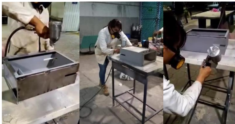
Figura 3.4A Proceso previo a pintar los módulos
