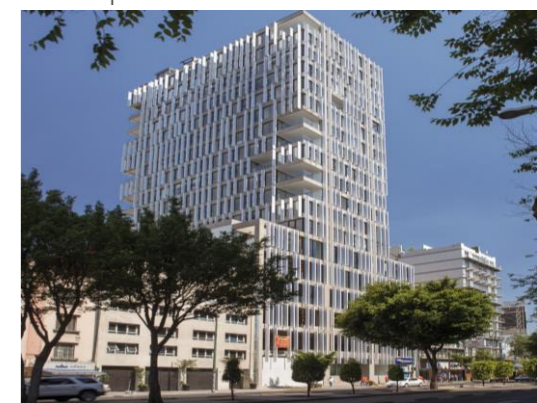
6 Imagen 134. Torre Ámsterdam Altura aprox. 60m 134
