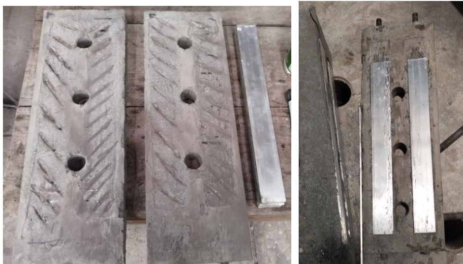
Figura 33. Preparación para la colocación de placas de aluminio en el prototipo de concreto DFC-04.
