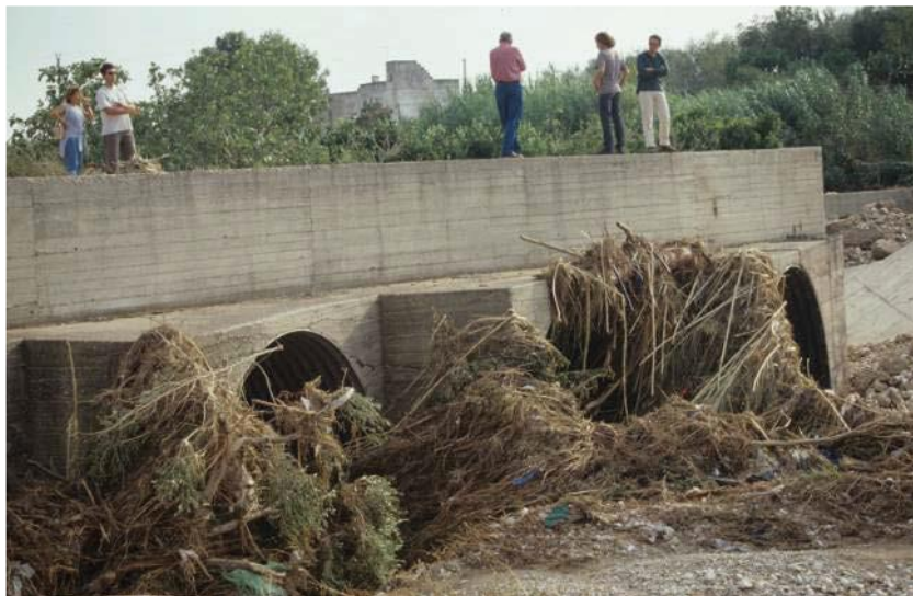
Figura 5. Daños producidos por inundaciones en zona kárstica: los efectos de la inundación de septiembre de 2003 en la provincia de Tarento, Italia (Parise, 2009).
