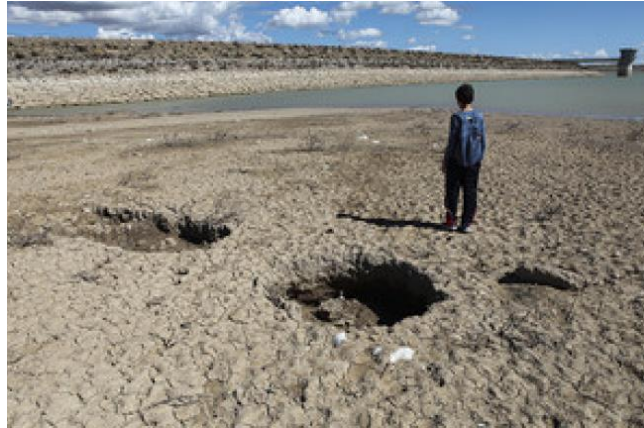
Figura 10. Dolinas de colapso relacionadas con la disolución de yeso formados en 2014 en el embalse de Loteta, España. (Gutiérrez, 2016)
