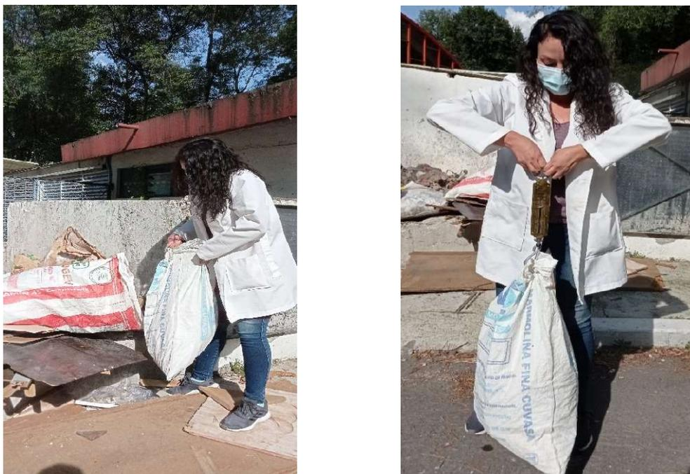
**Figura 17.** Pesaje de los residuos generados en la remodelación interior del Edificio 7.
