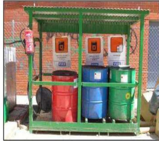
**Figura 3.** Almacenamiento de residuos peligrosos y no peligrosos, en construcciones.
