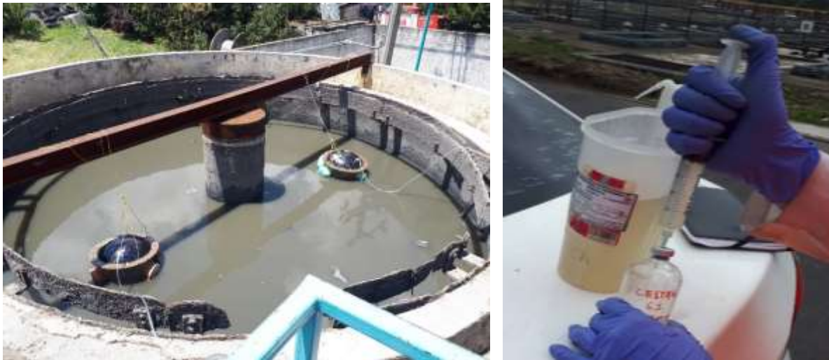
Fig.5.1. Muestreo en campo. Cuantificación de emisiones en sedimentador primario (izquierda) y toma de muestra para análisis de metano disuelto (derecha).
