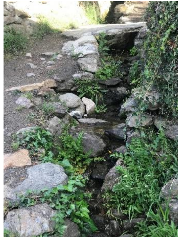
Figura 24. Acequia de la Ruta del Aceituno donde se observa la presencia de diferentes materiales pétreos de carácter brechoide (Pabello 2019).
