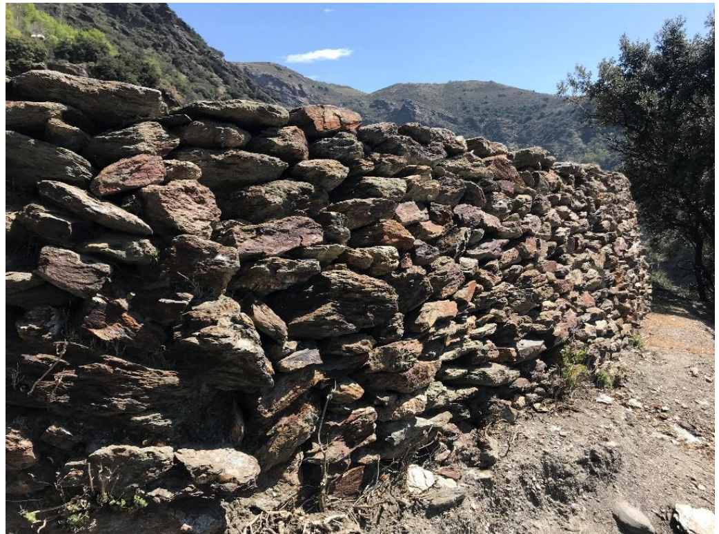
Figura 27. En la Alpujarra el balate está utilizado como contención de la era (Pabello 2019).
