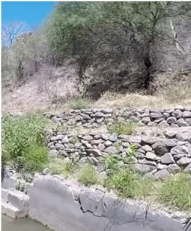
Figura 26. En la misión de San Francisco Javier se observa la contención de la alberca hecha mediante balates (Pabello 2019).
