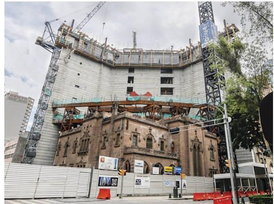
Fig. 5 Construcción de Torre Reforma.
