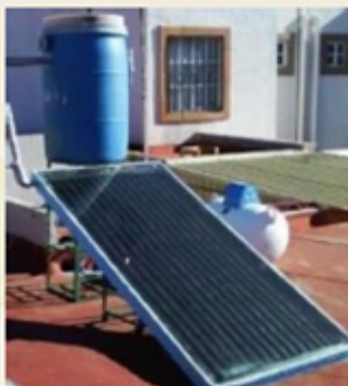
Calentador solar de CPVC diseñado por Rod Tapia, Estado de México de Ecotecnias y Prácticas sustentables de Iodesol
