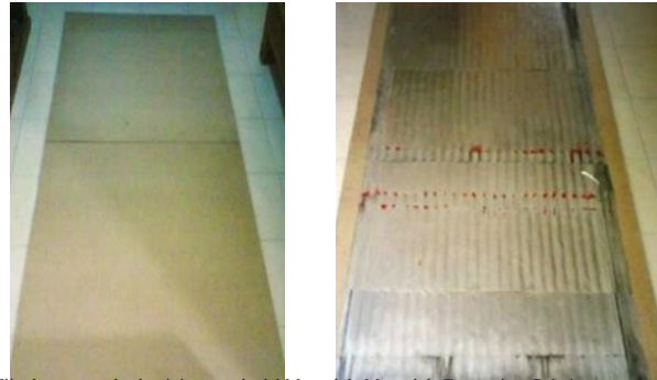
Fijar los tramos de aluminio, tomado del Manual de Manual de Ecotecnias Prácticas sustentables.
