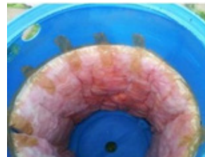
Colocar el aislamiento del tanque a su interior y exterior, tomado del Manual de Manual de Ecotecniasy Prácticas sustentables.
