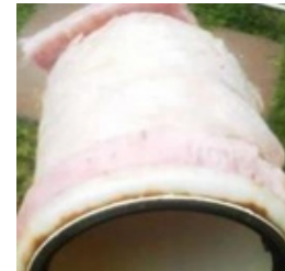
Colocar el aislamiento del tanque a su interior y exterior, tomado del Manual de Manual de Ecotecniasy Prácticas sustentables.
