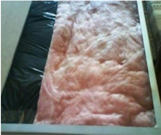
Colocar fibra de vidrio con bolsa de plástico aislante, tomado del Manual de Manual de Ecotecniasy Prácticas sustentables.
