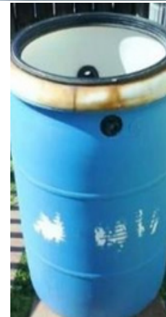
Colocar el termotanque interno dentro Ilustración 18 Listo, Termotanque aislado del externo para que quede aislado, tomado del Manual de Manual de Ecotecnias y Prácticas sustentables.
