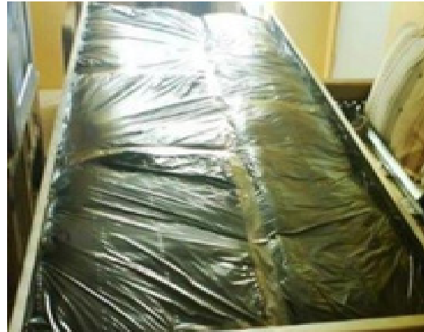
Forrar la fibra de vidrio con aislante, tomado del Manual de Manual de Ecotecniasy Prácticas sustentables.
