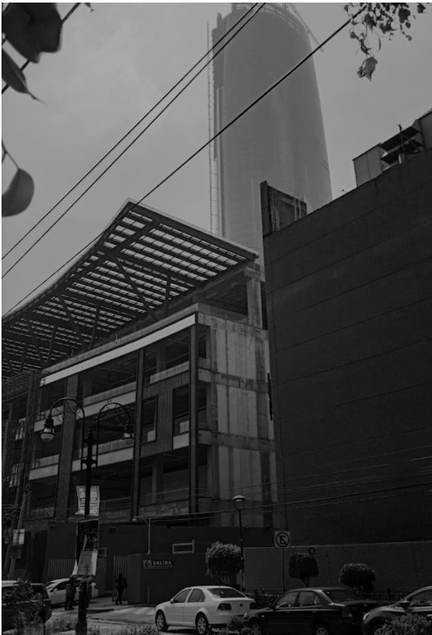
Fotografía: Daniel Cabrera, proyecto Mitikah, Barrio de Xoco, CDMX.
