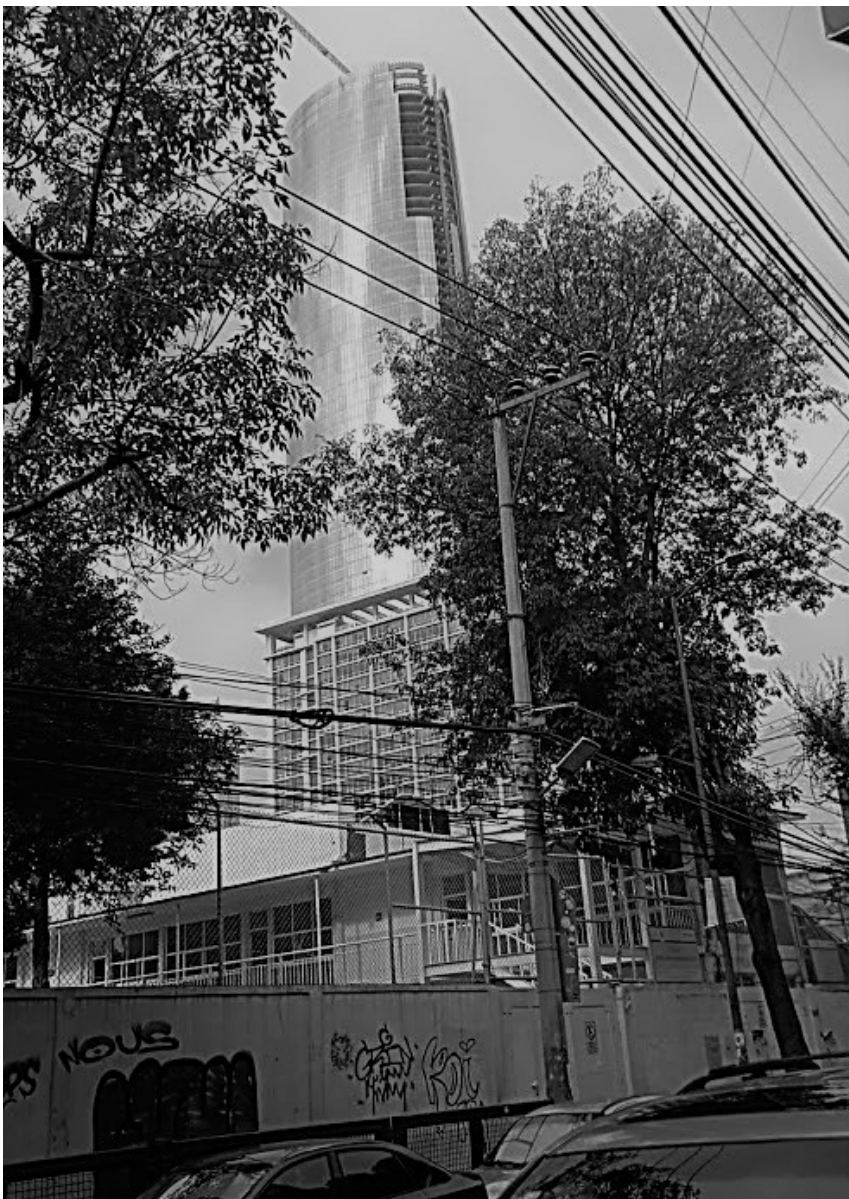
Fotografía: Daniel Cabrera, proyecto Mitikah, Barrio de Xoco, CDMX.
