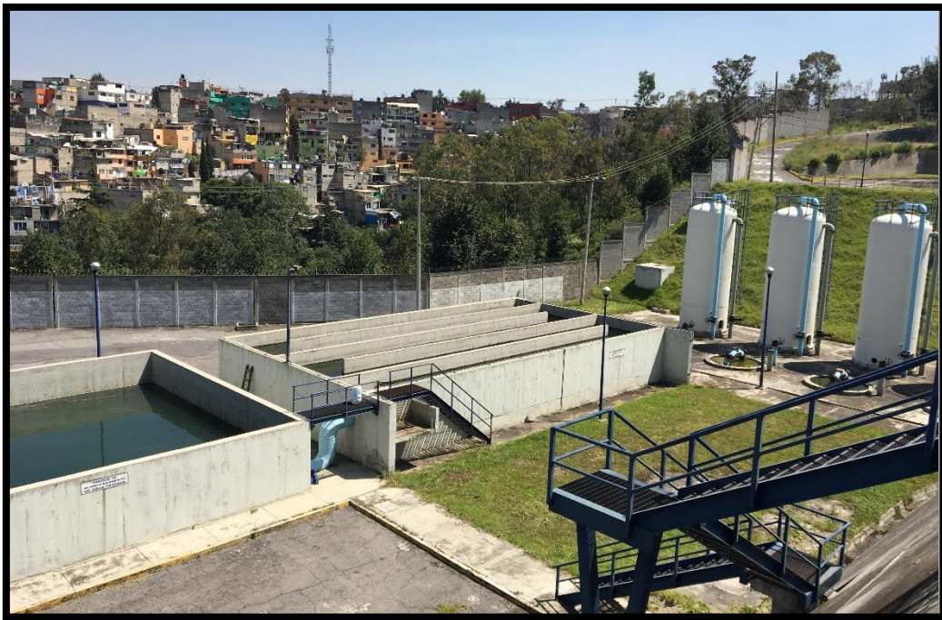
Figura 4.19. Vista de la PTAR Santa Fe.
