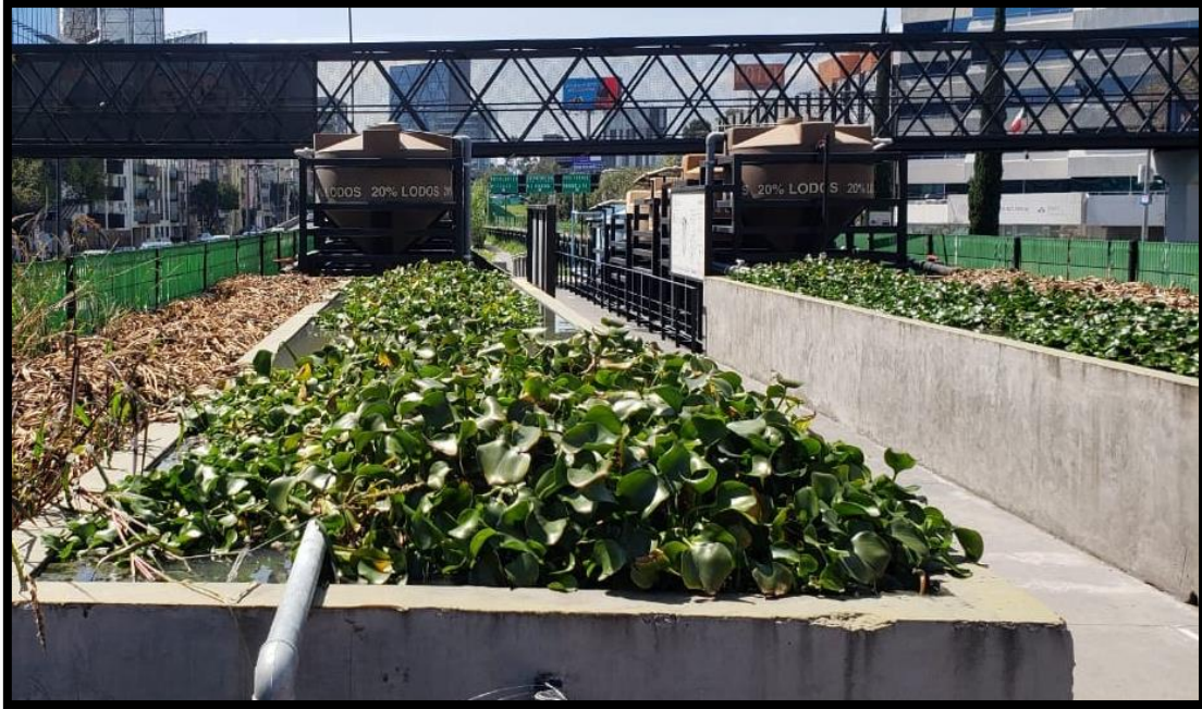
Figura 4.20. Vista de la PTAR Ecoducto (tanques desarenadores en primer plano).
