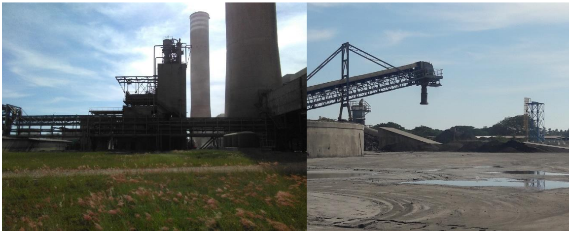
Figura 21. Planta termoeléctrica de CFE generación IV, Petacalco, Guerrero.
