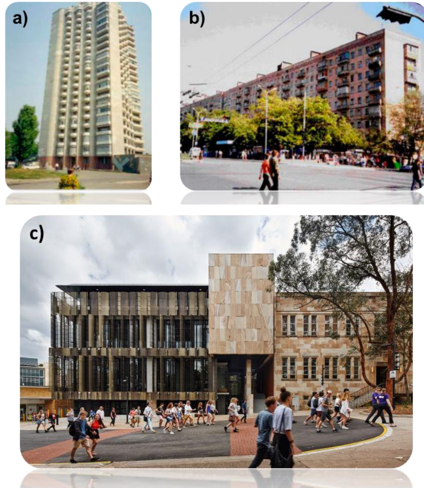
Figura 6. (a) El primer edificio residencial hecho de concreto de cemento activado por álcalis sin ningún CPO. (Edificio residencial de 20 pisos, Lipetsk, Federación de Rusia, 1987–1989); b) Uno de los dos edificios residenciales de 9 pisos, Mariupol, Ucrania, 1960 [29]; y c) Instituto del Cambio Global [28].
