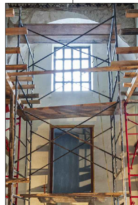
FOTO-03 VISTA DE GRIETAS EN EL MURO.
