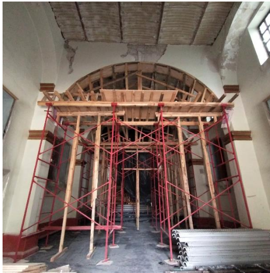
19 Vista de los apuntalamientos colocados en los arcos fajones al interior de la nave del templo. Noviembre 2021. K.R.V.
