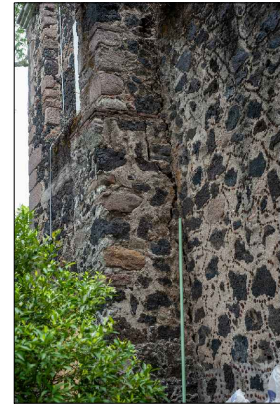
FOTO-02 VISTA DE FRACTURA EN CONTRAFUERTE DEL TEMPLO.
