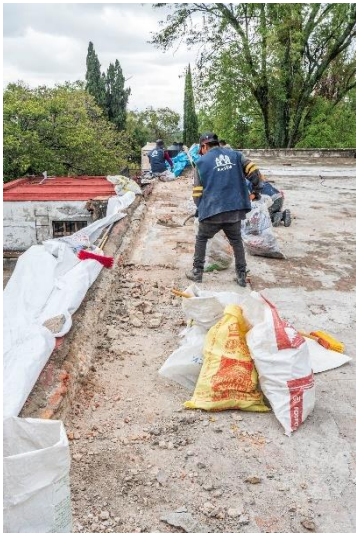
18 Vista del proceso de la liberación del chaflán, entortado y enladrillado de la cubierta. Noviembre 2021. Archivo Sackbé.
