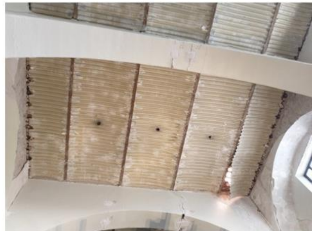
44 Vista de vigas tipo riel en el actual sistema de cubierta de bóveda de láminas de zinc. Noviembre 2021. K.R.V.
