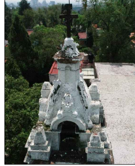
FOTO-07 VISTA DE BASE DE CRUZ Y REMATE CON FRACTURAS Y DISGREGACIÓN DE JUNTAS QUE PROVOCAN APLANADOS SUELTOS Y CRECIMIENTO DE FLORA Y MICROFLORA NOCIVA.
