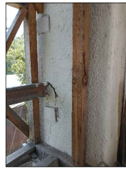
FOTO-07 VISTA DE GRIETAS EN PIERNAS DEL PRIMER CUERPO DE LA TORRE CAMPANARIO.
