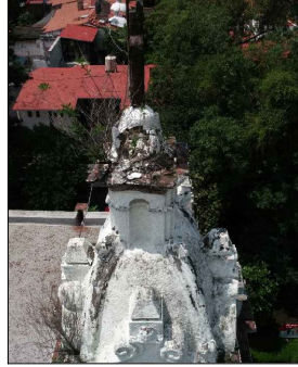
FOTO-01 VISTA DE BASE DE CRUZ Y REMATE CON FRACTURAS Y DISGREGACIÓN DE JUNTAS QUE PROVOCAN APLANADOS SUELTOS Y CRECIMIENTO DE FLORA Y MICROFLORA NOCIVA.
