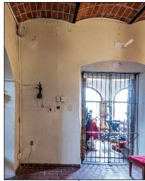
VISTA DE GRIETAS Y FISURAS EN EL APLANADO DE MURO EN SACRISTÍA. FOTO-01
