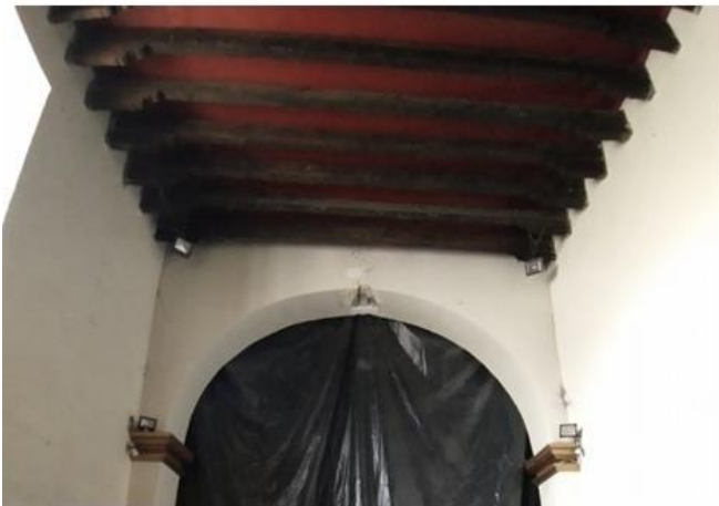
43 Vista de vigas de madera en el presbiterio que hacen alusión al sistema de tablado original de la cubierta del templo. Noviembre 2021. K.R.V.
