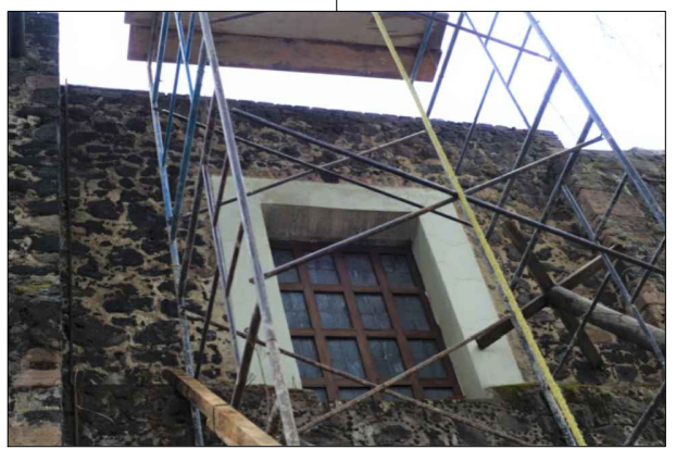
FOTO-04 VISTA DE FLORA Y MICROFLORA NOCIVA EN JUNTAS CON MORTERO DISGREGADO EN CORNISA.
