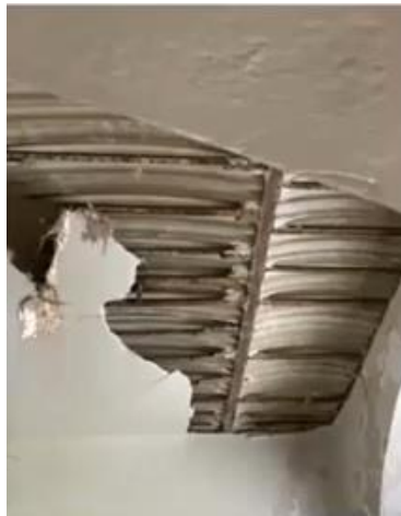
28 Vista de la cubierta parcialmente colapsada con listones de madera y plafón de yute y yeso. S.f. Fotografías obtenidas del video "Sesión 3. Situación actual del templo de San Jerónimo Lídice. Acciones para su rehabilitación." Canal de Youtube "Parroquia San Jerónimo Lídice"
