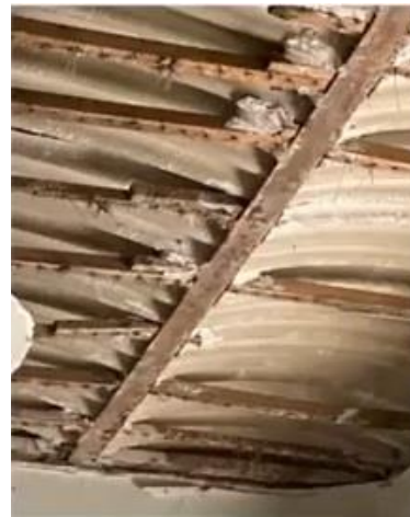
28 Vista de la cubierta parcialmente colapsada con listones de madera y plafón de yute y yeso. S.f. Fotografías obtenidas del video "Sesión 3. Situación actual del templo de San Jerónimo Lídice. Acciones para su rehabilitación." Canal de Youtube "Parroquia San Jerónimo Lídice"
