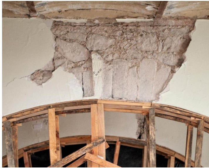
23 Detalle de lápidas reutilizadas como dovelaje en arco fajón del campo santo anteriormente ubicado en el atrio del templo. En la pieza clave se lee: "F / MR / + / 1907". Noviembre 2021. K.R.V.
