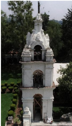
16 Vista de los apuntalamientos colocados en los arcos del primer y segundo cuerpo de la torre campanario. Noviembre 2021. Archivo Sackbé.
