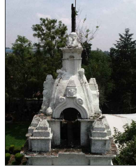
FOTO-04 VISTA DE BASE DE CRUZ Y REMATE CON FRACTURAS Y DISGREGACIÓN DE JUNTAS QUE PROVOCAN APLANADOS SUELTOS Y CRECIMIENTO DE FLORA Y MICROFLORA NOCIVA.
