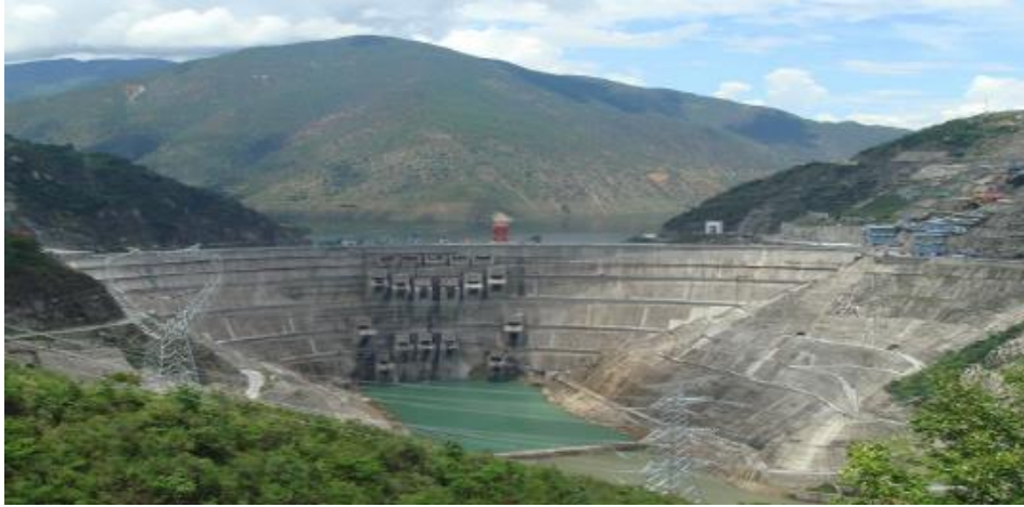
Fig. 100 Presa de arco Jinping I, en China.
