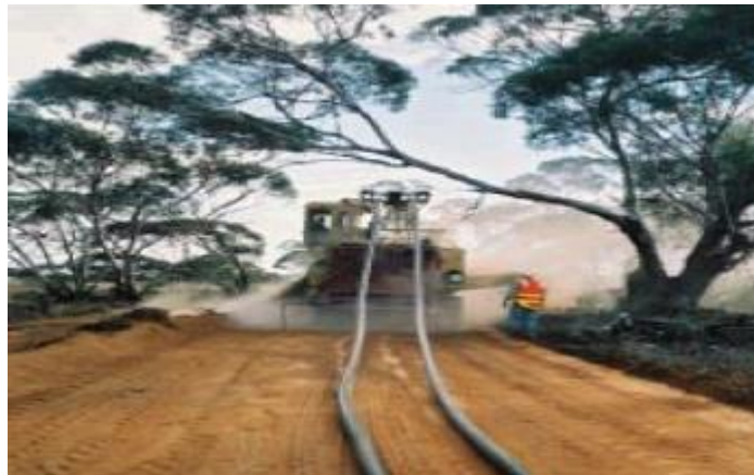
Fig. 104 Colocación de cables en el enlace Murraylink.
