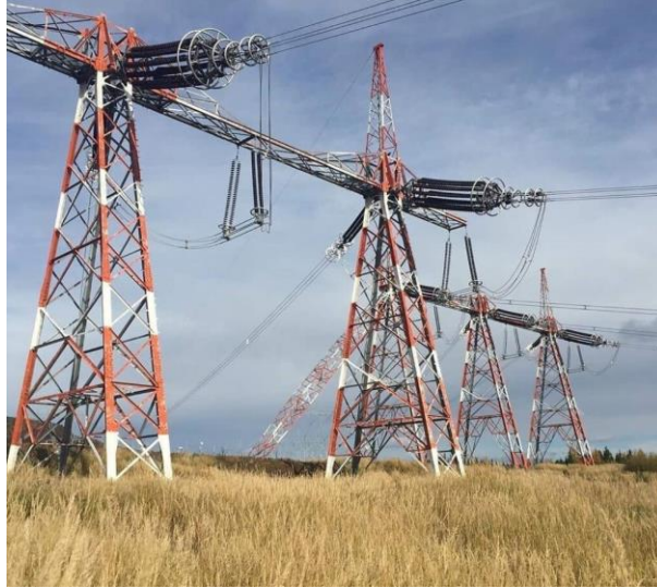
Fig. 27 Torre de transmisión de 745 KV ubicada en Alemania.
