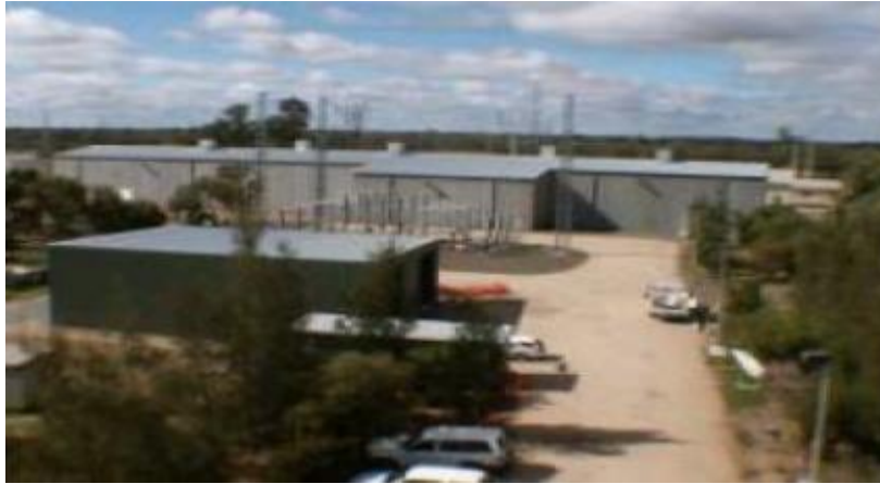
Fig. 103 Estación de conversión en Red Cliffs, Victoria.
