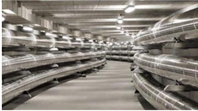
Fig. 57 Instalación del túnel GIL, Munich, Alemania
