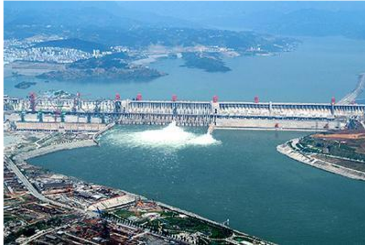
Fig. 97 Visión aérea de la presa de las Tres Gargantas, en China.
