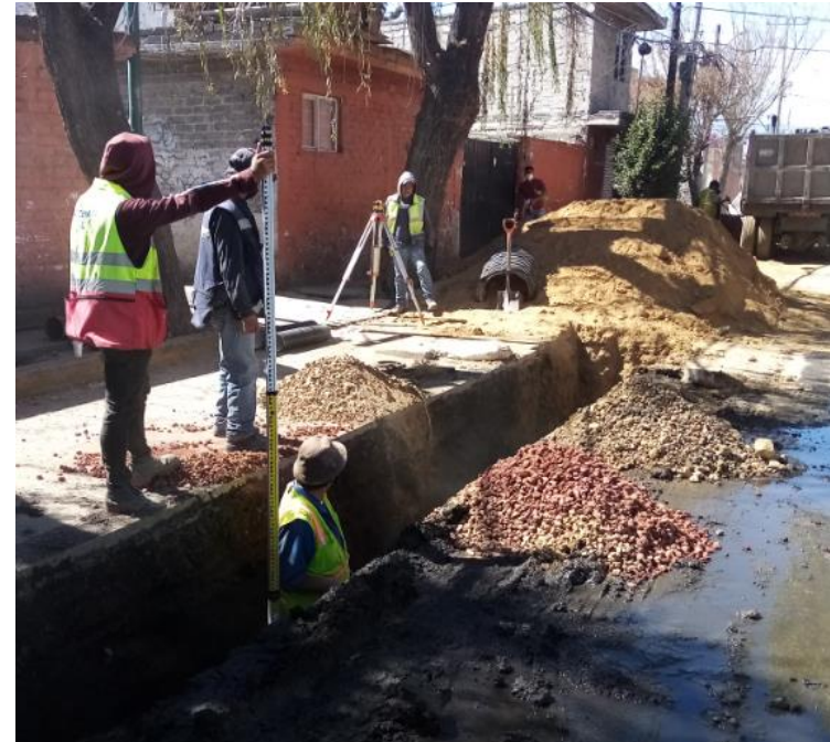
17.-IMAGEN PERSONAL OBTENER NIVEL TRAS COLOCAR EL ACOSTILLADO DE TEZONTLE PARA QUE LA TUBERÍA NO SÉ ENCUENTRE POR DEBAJO DEL NIVEL DESEADO.
