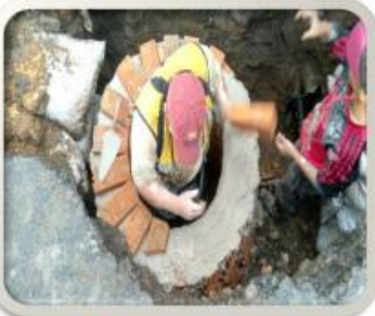
CONSTRUCCIÓN DE POZO DE VISITA
