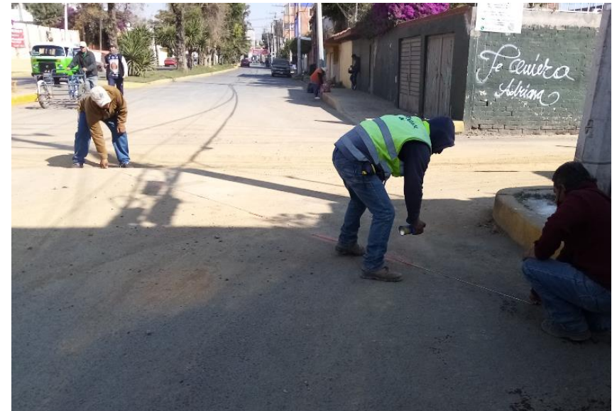
6.-IMAGEN PERSONAL TRAZO PARA CORTE DE LÍNEA DE ASFALTO.
