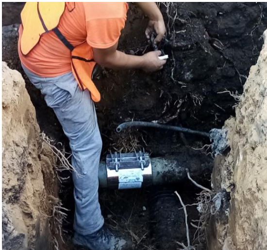
8.-IMAGEN PERSONAL REPARACIÓN DE TOMA DOMICILIARIA Y COLOCACIÓN DE MANGA DE ACERO PARA REPARACIÓN DE TUBO DE AGUA POTABLE DE 4"
