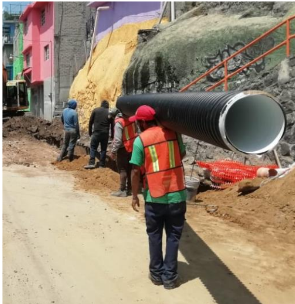
3.-IMAGEN PERSONAL CARGA Y ACARREO DE TUBERÍA DE PEAD
