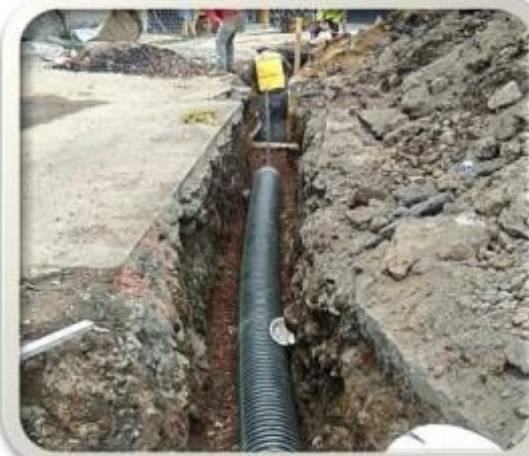
TENDIDO DE TUBERÍA
