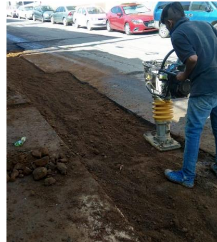
21.-IMAGEN PERSONAL COMPACTACIÓN DE LA CAPA TE TEZONTLE CON EQUIPO MECÁNICO.
