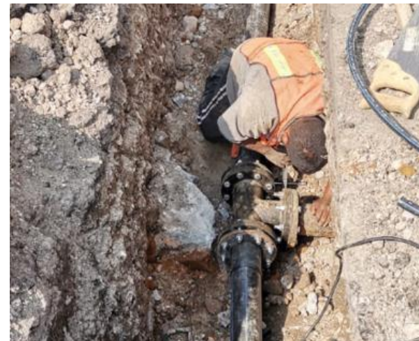
9.-IMAGEN PERSONAL MONTAJE DE PIEZAS PARA AGUA POTABLE.
