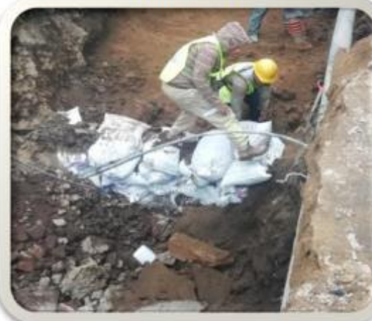
SUMINISTRO DE FILTRO Y COLOCACIÓN DE COSTALES
