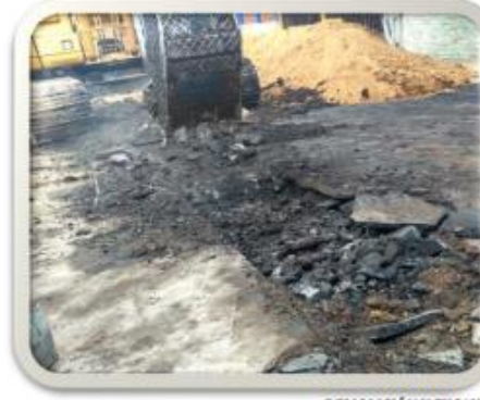
DEMOLICIÓN Y EXCAVACIÓN
