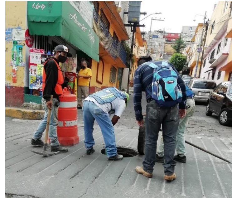
4.-IMAGEN PERSONAL REVISIÓN DE DRENAJE EXISTENTE.
