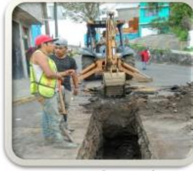
DEMOLICIÓN Y EXCAVACIÓN
