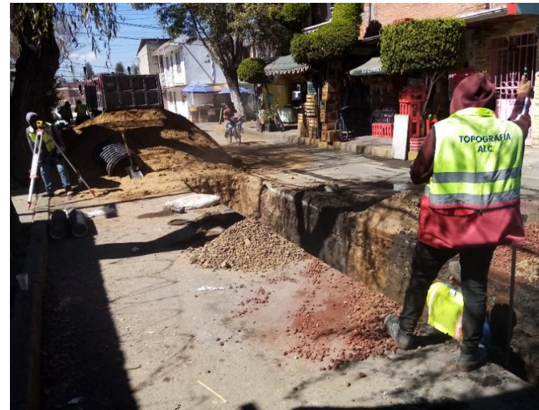
10.-IMAGEN PERSONAL ARRASTRE DEL TERRENO E HIDRÁULICO CON EQUIPO TOPOGRÁFICO.
