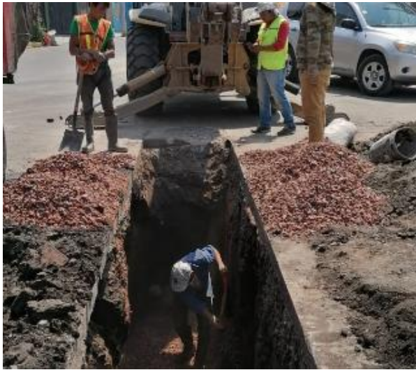
16.-IMAGEN PERSONAL COLOCACIÓN CAMA DE TEZONTLE PARA ASENTAR TUBERÍA.
