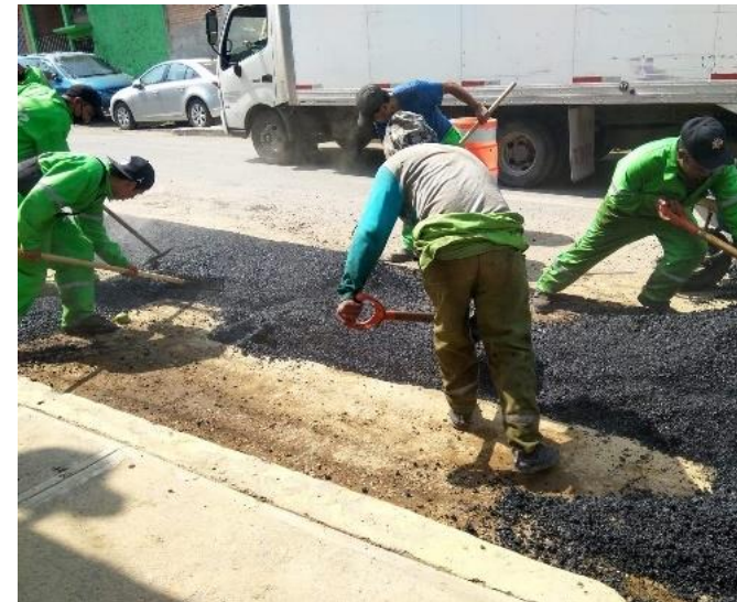
23.-IMAGEN PERSONAL COLOCACIÓN DE ASFALTO CALIENTE.
