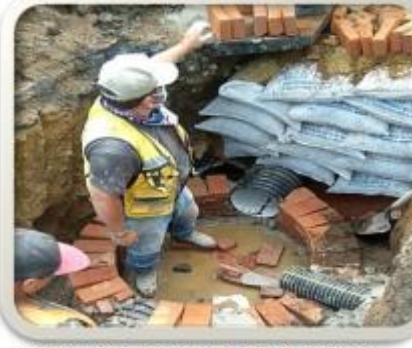
SUMINISTRO DE FILTRO Y COLOCACIÓN DE COSTALES
