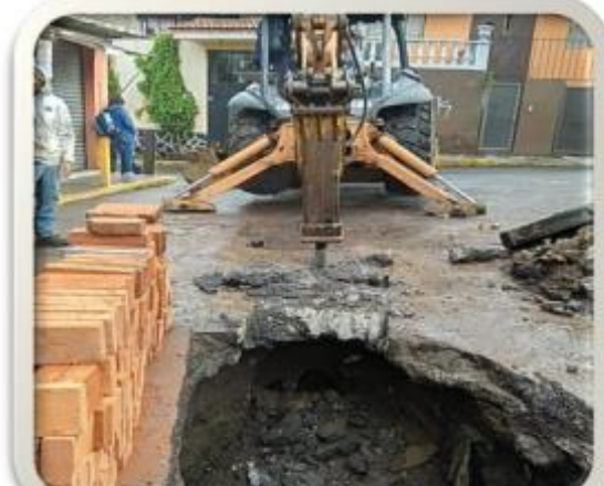
DEMOLICION Y EXCAVACION
