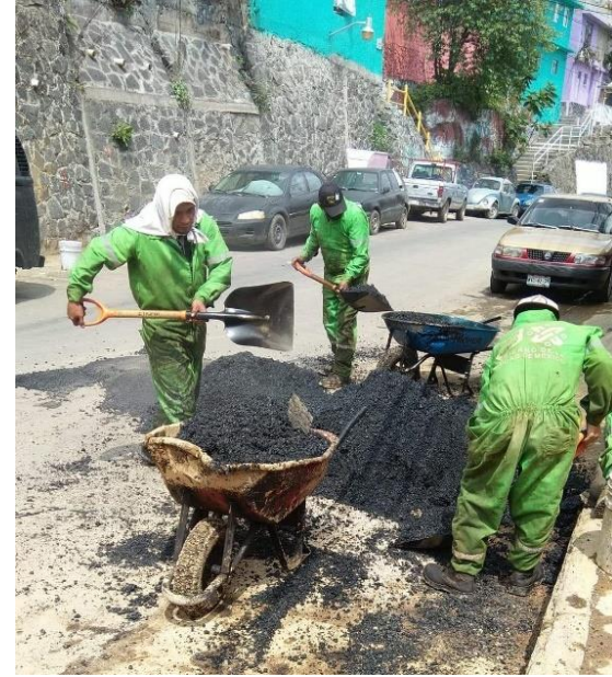
25.-IMAGEN PERSONAL ACARREO EN CARRETILLA DE ASFALTO CALIENTE.
