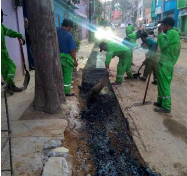
24.-IMAGEN PERSONAL COLOCACIÓN DE EMULSIÓN ASFÁLTICA.
