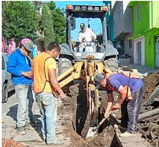
11.-IMAGEN PERSONAL EXCAVACIÓN DE ZANJA.
