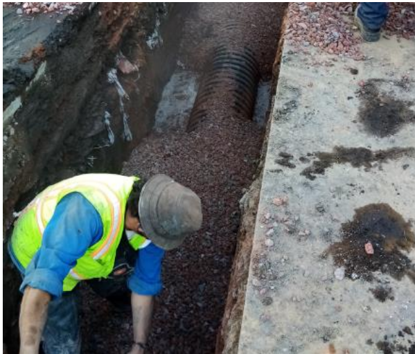
18.-IMAGEN PERSONAL COLOCACIÓN DE ACOSTILLADO DE TEZONTLE EN TUBERÍA.
