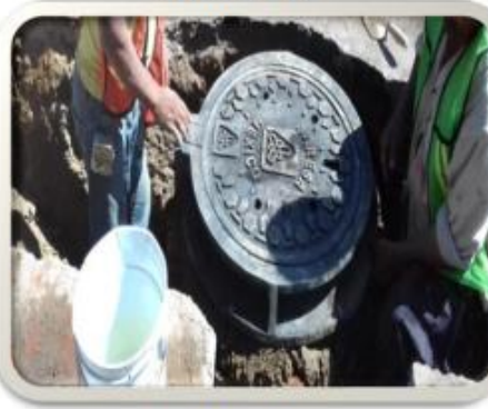
COLOCACION DE BROCAL
