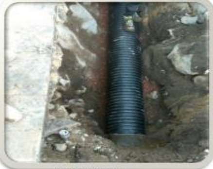
TENDIDO DE TUBERÍA
