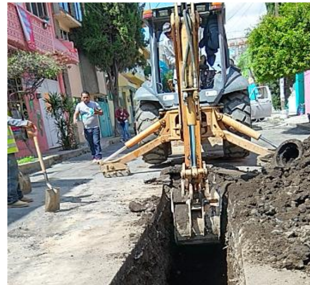
13.-IMAGEN PERSONAL EXCAVACIÓN DE ZANJA.
