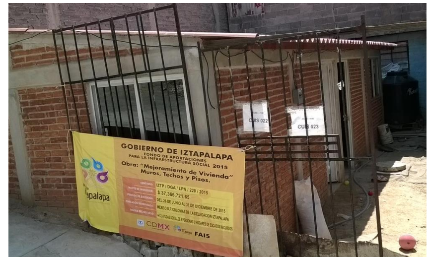
1.-IMAGEN PERSONAL CASA TERMINADA.
