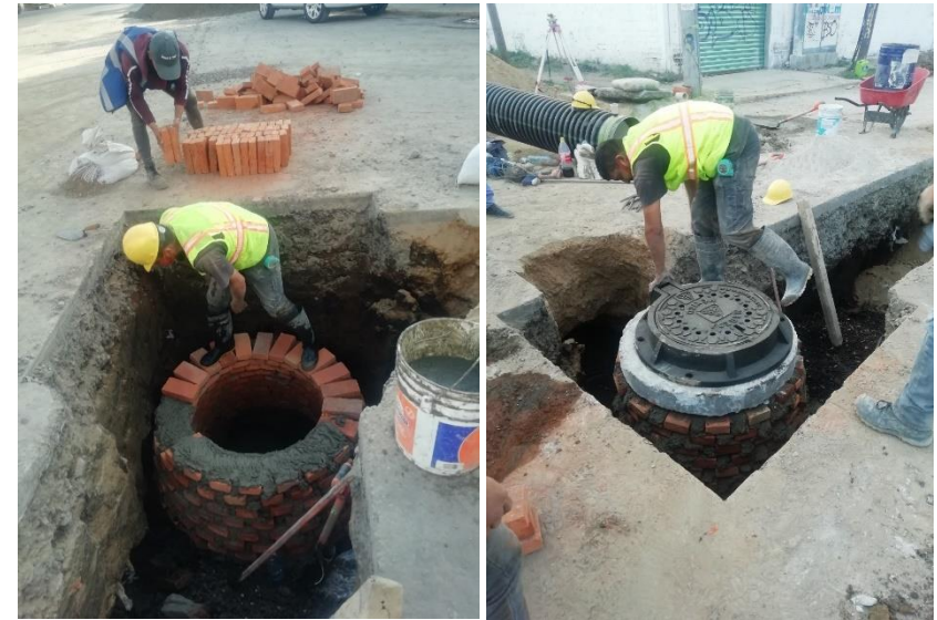
20.-IMAGEN PERSONAL CONSTRUCCIÓN DE POZO DE VISITA.
