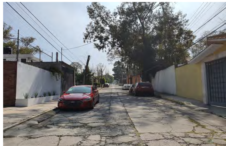
53. Calle Faisán, Fotografía: Alvaro Izquierdo
