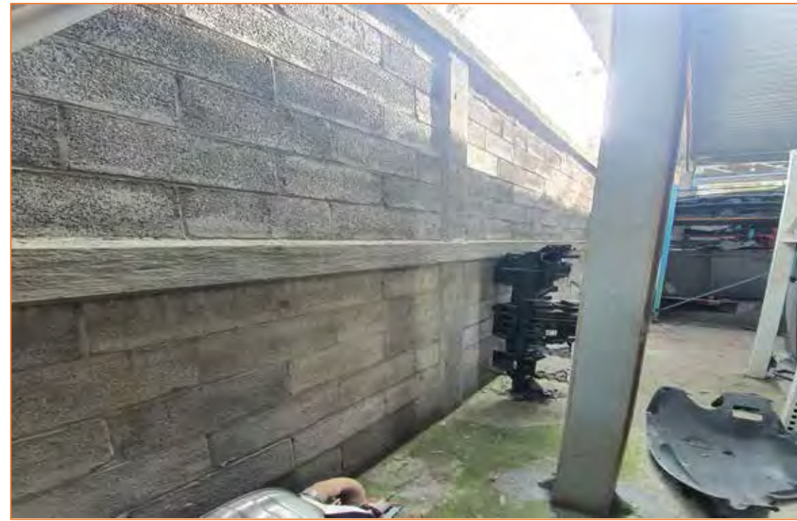
4 VISTA INTERIOR MURO TRASERO
