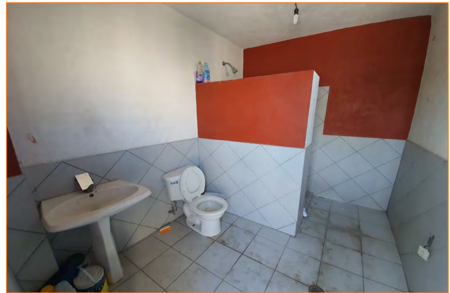
47. Fotografía 4, Baño Existente, Fotografía: Alvaro Izquierdo
