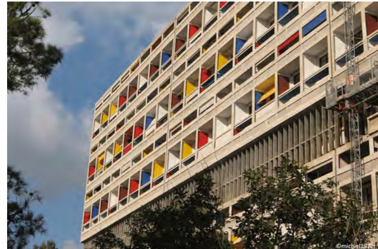
25. Fachada Unité d'Habitation de Marseille, Fuente: Critic-ARQ
