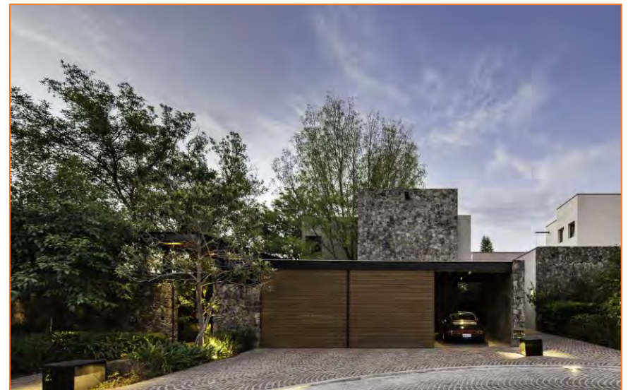
13. Fachada Principal Casa SR, Fotografía: Adriana Polo
