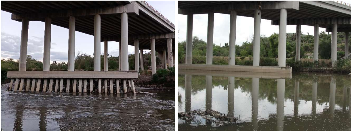
Fig. 6. - Izquierda. Fotografía tomada el 16 de junio de 2021 en la que claramente se distinguen los micropilotes de la cimentación del caballete 5, como consecuencia de la fuerte socavación activa y general del cauce sin lograrse distinguir depósito de sedimento de material de transporte. Izquierda. Fotografía tomada el 08 de agosto de 2021 en la que se observa el nivel que alcanza el agua del río bajo el caballete 5. Haciendo un comparativo de las fotografías, se señala que la socavación general continua activa, por dos razones: 1) No se nota por las características de la corriente material de transporte. 2) En zona cercana a la estructura aguas arriba existe una reducción natural del área hidráulica que favorece el cambio en el ángulo de ataque de la corriente sobre las pilas y el incremento de la velocidad con el que las partículas de agua impactan el fondo del cauce, lo que explica el intenso lavado del material bajo la cimentación de los caballetes 3 a 6. Fotografías archivo del autor.
