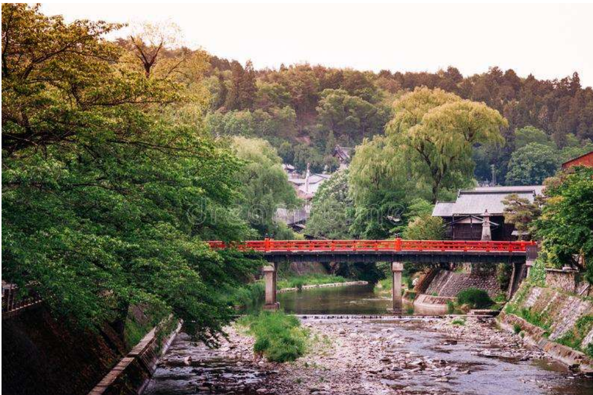
Puente Rojo de Nakabashi sobre el río Miyagawa, en Takayama, Japón. Imagen tomada del sitio: https://thumbs.dreamstime.com/b/puente-rojo-de-nakabashi-en-takayama-jap%C3%B3n-77106635.jpg Fecha de actualización: 12 de julio del 2020.
