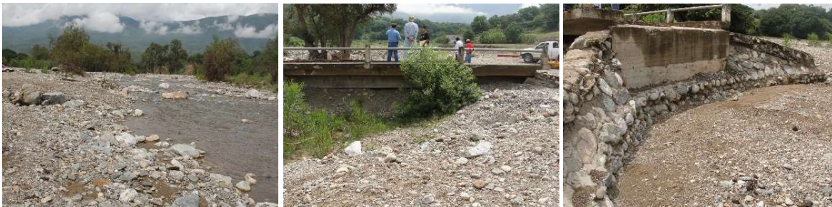
Fig. 16.- Camino a San Juan Bautista Atlatlahuca ubicado en la Sierra de Oax., Méx. que continúa con un Puente sobre el Río Chiquito. Derecha. Vista tomada desde el hombro izquierdo de la estructura y hacia aguas abajo del cauce. En la que se puede observar el tamaño del sedimento que transporta la corriente en condiciones de crecientes. Central. Con el paso de una avenida atípica el puente quedo completamente azolvado. Izquierda. Camino totalmente interrumpido por la pérdida del acceso de salida del puente. Archivo del autor diciembre del 2012.
