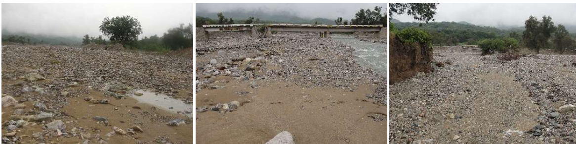
Fig. 18.- Puente sobre el Río Las Vueltas ubicado en la Sierra de Oax., Méx. que comunica con el poblado de la Unión y San Juan Bautista Atlatlahuca. Derecha. Vista tomada desde el hombro derecho de la estructura y hacia aguas arriba del río. En la que se puede observar un cauce divagante muy ancho y que las avenidas provocan una elevada capacidad y competencia de gran diámetro que incluso ha invadido la superestructura y golpeado su parte baja (claros insuficientes y galibo vertical escaso para dar paso al sedimento). Central. Panorámica derecha de la estructura tomada desde aguas arriba del cauce. En la que se aprecia la Pila 4 asentada por efecto de la socavación y desplomada hacia el hombro derecho. Los terraplenes de los accesos se construyeron sobre el cauce y obstruyen fuertemente el área hidráulica de este. Izquierda. Se distingue el puente aguas abajo de la confluencia del Río Limón. Archivo del autor enero del 2013.
