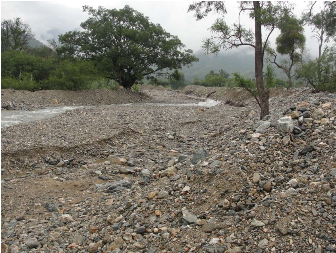
Fig. 45- Vista aguas abajo del cauce Río Limón, se resalta la protección con bordo para dirigir la corriente.
