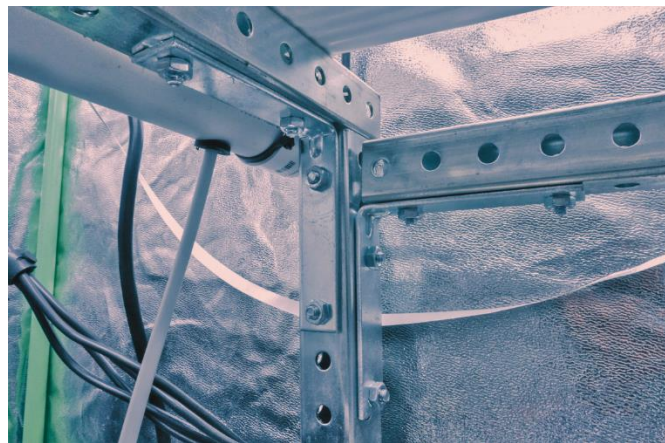
Figura 8. Fuente de elaboración propia. El marco con barras de acero de 90^\circ que sujetan la pata trasera izquierda a la columna.
