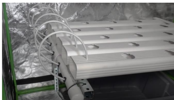
Figura 18. Fuente de elaboración propia. Colocación de tubos de PVC y canales sobre marco metálico
